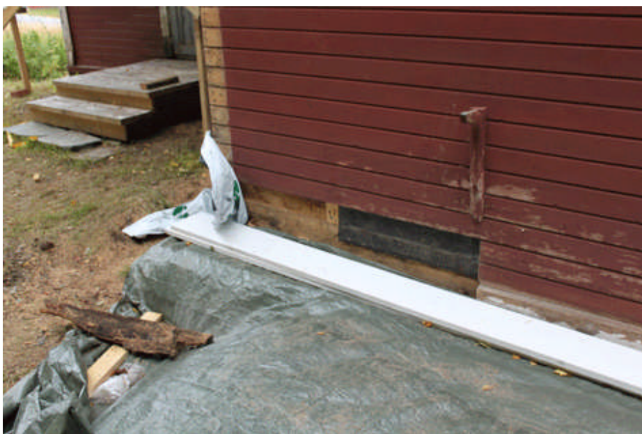
Här skymtar man vindpappen som varit fäst innanför väggspanelen
