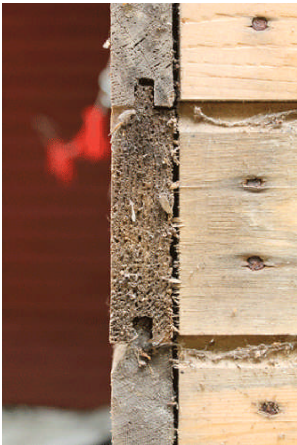
Närbild på den fasspontade vägghpanelen
