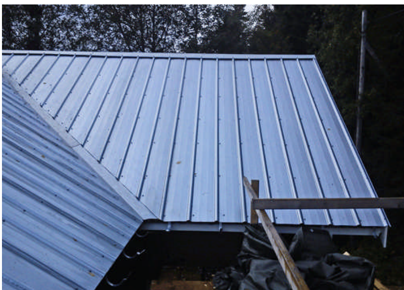
Pannplåttaket är monterat med självborrande skruv
