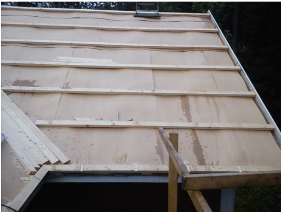
Skivor med oljeboard har lagts på takfallen. Foto Fahlströms bygg
