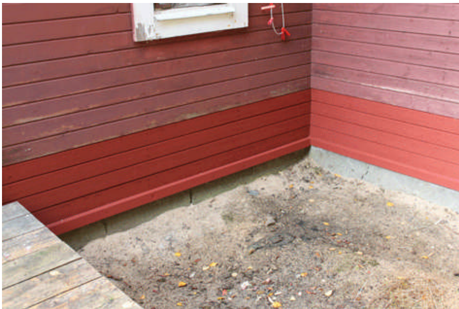
Ny vägghpanel har monterats och målats med Falurödfärg
