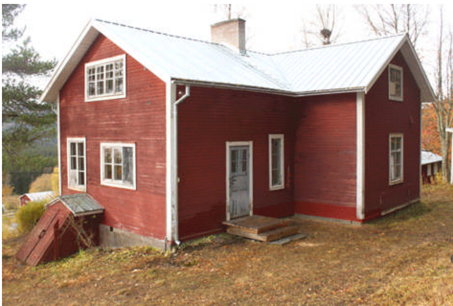
Hela huset med nytt pannplåttak, stuprör och hängrännor, samt lagad fasadpanel
