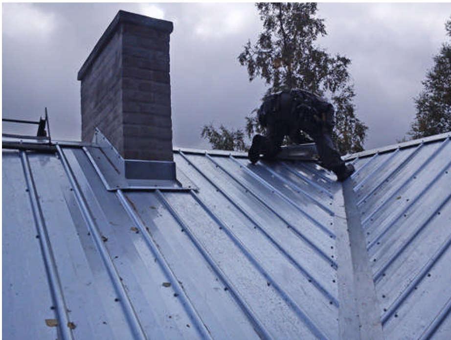
En "krage" har monterats kring skorstenen för att förhindra att vatten kan läcka in
