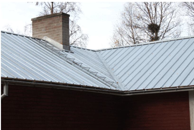
Pannplåttaket är monterat med självborrande skruv
