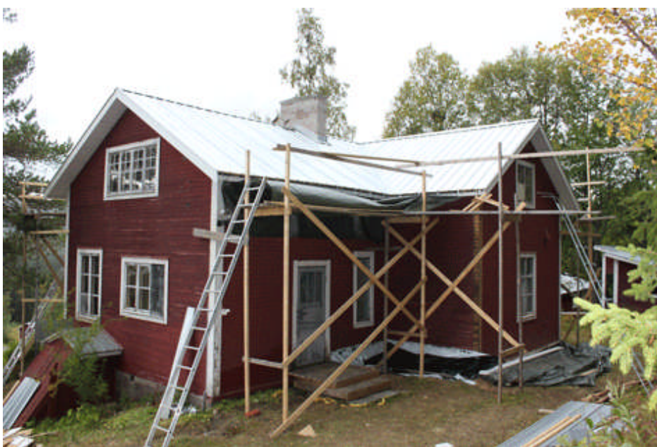
På husets baksida fanns en hängränna sedan tidigare, denna var i dåligt skick och har därför bytts ut till en ny hängränna med stuprör. Samtidigt har man valt att montera hängrännor och stuprör även på de fasader som tidigare inte
