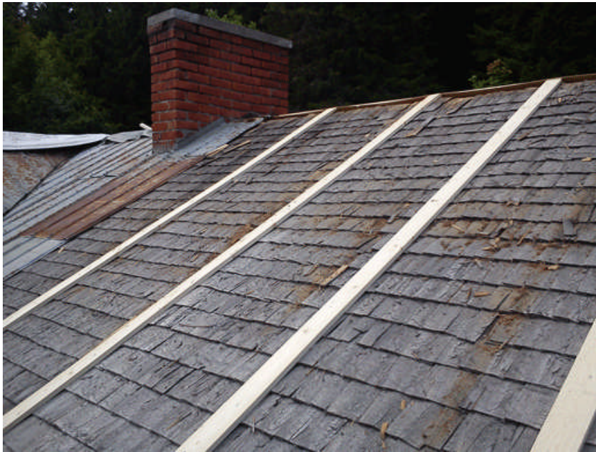
Nya ribbor har lagts på takfallet, ska fungera som underlag till skivor med oljeboard. Foto Fahlströms bygg
