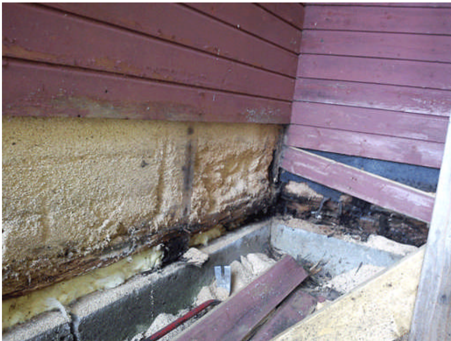
När väggspanelen demonterats kom isoleringen med sågspån fram. Foto Fahlströms bygg
