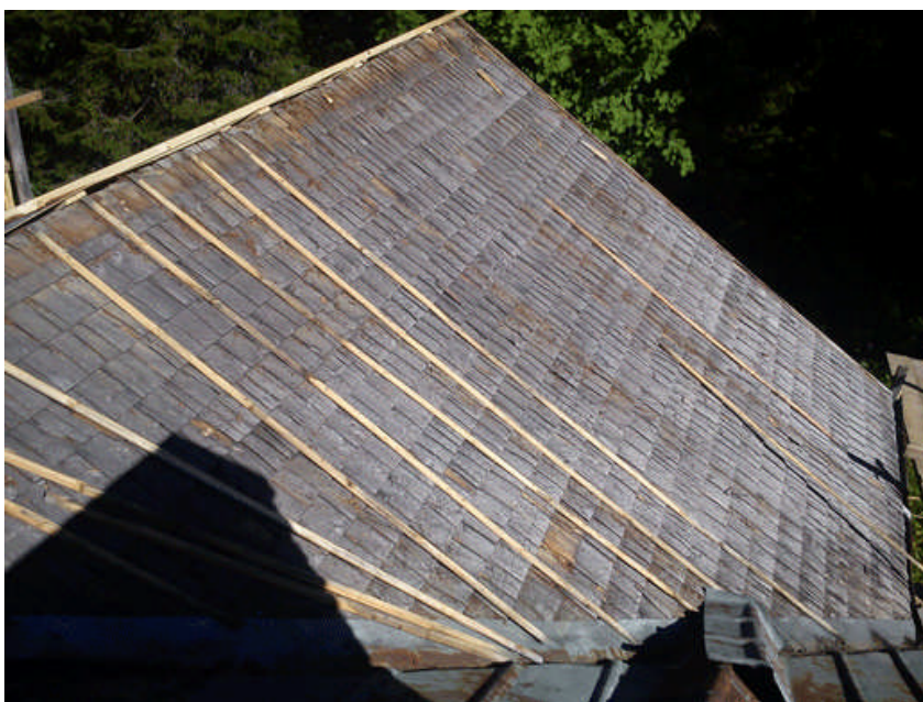
Det äldre pannplåtstaket hade varit monterat med spik på smala ribbor som låg längs takfallet. Foto Fahlströms bygg
