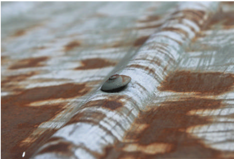
Detaljbild på det äldre pannplåttaket med tillhörande spik
