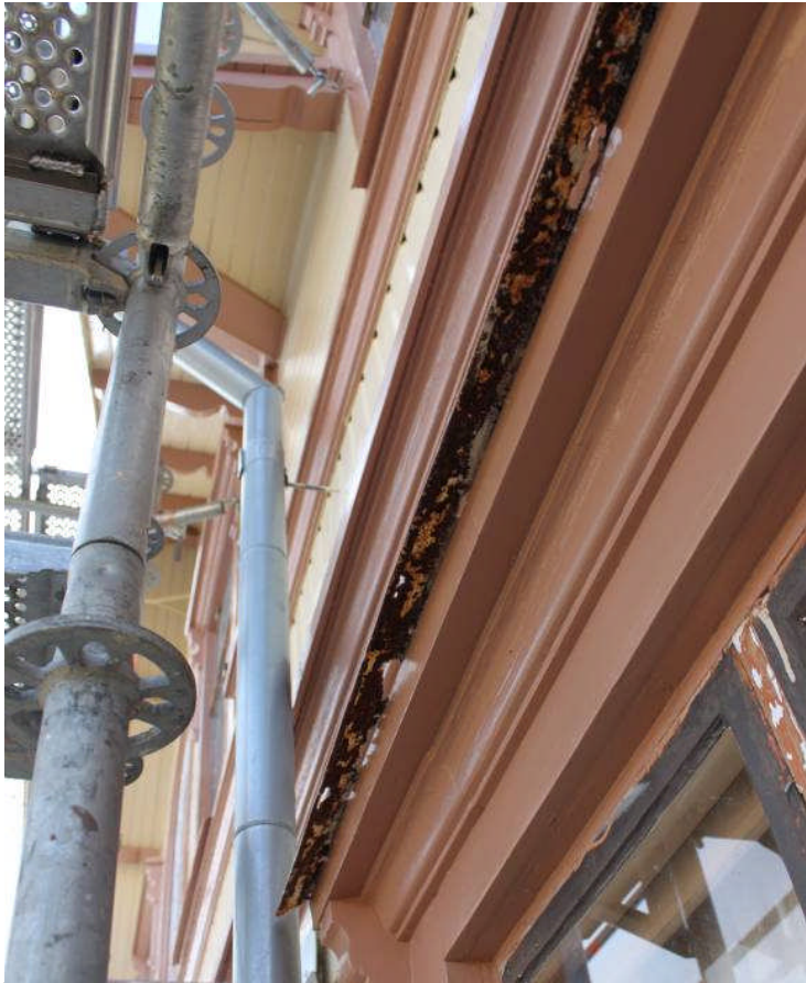
På fönstret längst ned till höger på den norra fasaden är den övre fönsteromfattningens skyddsplåt rotskadad och behöver bytas ut, här ses den underifrån och ovanifrån. IMG_2094 och IMG_2101 Foton: Jenny Brantestad
