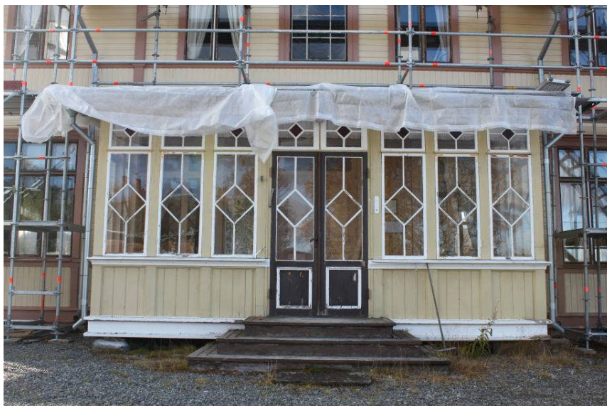
Målningsarbete kvarstår fortfarande på verandan samt på norra fasadens samtliga fönsterbågar. IMG_2042 Foto: Jenny Brantestad
