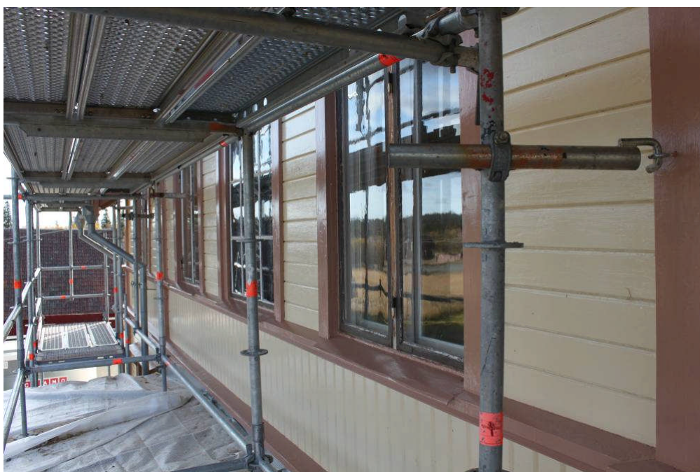
Fasadens liggande och stående fasspontpanel samt listverk och fönsterfoder i respektive färgsättning. IMG_2061 Foto: Jenny Brantestad
