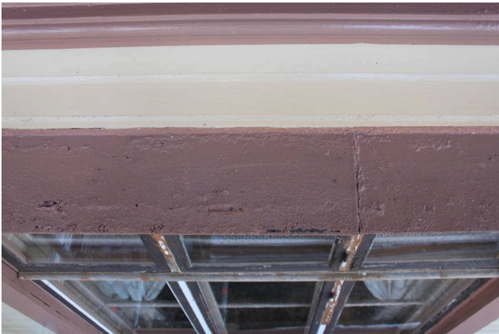
På fönstret längst ned till höger på den norra fasaden är den övre fönsteromfattningens skyddsplåt rotskadad och behöver bytas ut, här ses den underifrån och ovanifrån. IMG_2094 och IMG_2101 Foton: Jenny Brantestad
