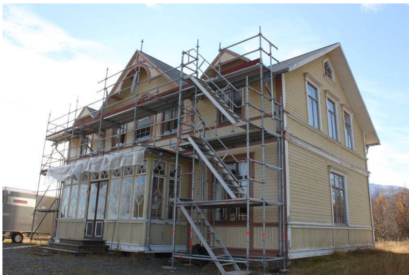
Den norra fasaden där arbetet är slutfört (förutom verandan) samt den västra fasaden där arbetet kvarstår. IMG_2077 Foto: Jenny Brantestad
