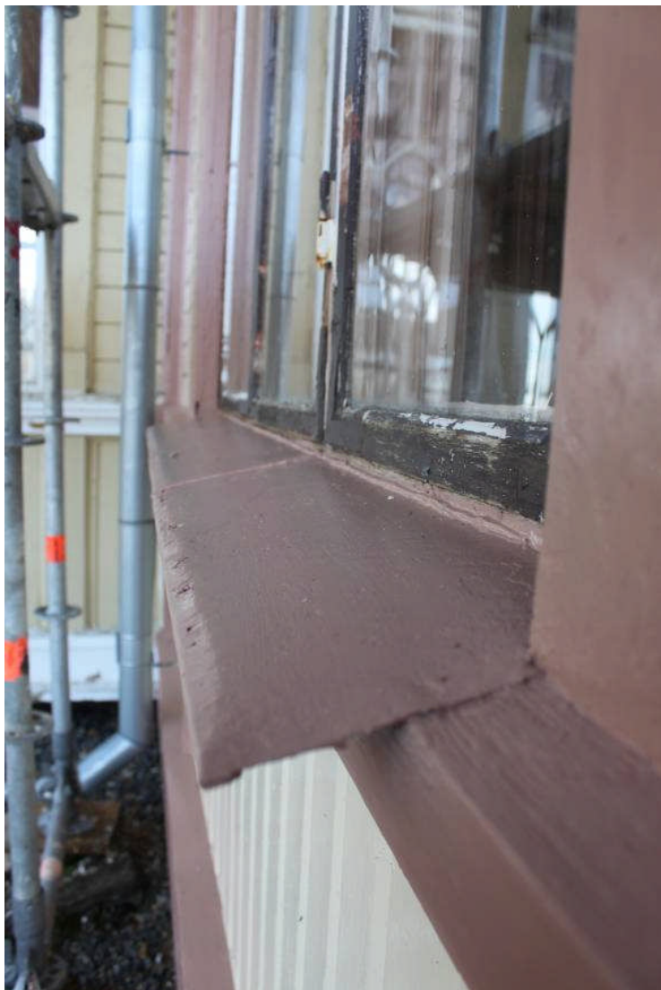
Fönsterbleck och listbleck har rengjorts och därefter behandlats med rostskyddsfärg (Kirjo Rostskyddsfärg, Teknos AB) för att sedan målas i samma kulör som listverk och foder. IMG_2095 Foto: Jenny Brantestad
