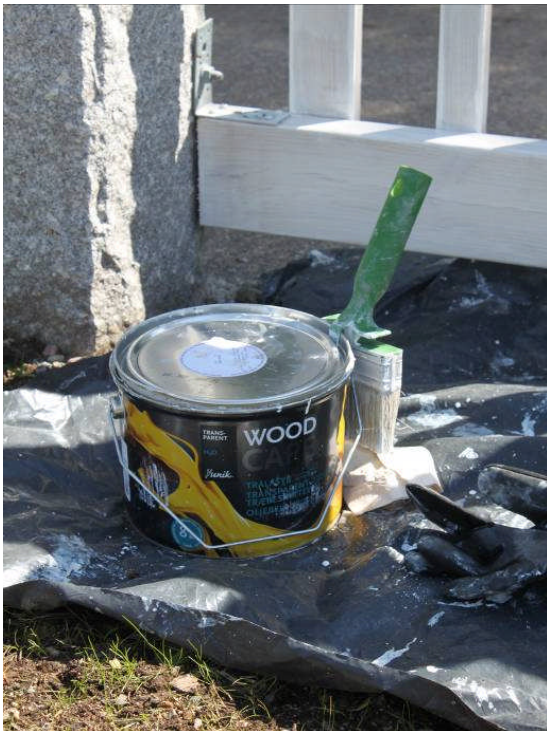
Bild 29 & 30: Trästaketet är behandlat med vit trälasyr, Yunik wood care lasyrolja. Flera kvistbortfall kunde ses på staketet men vid besök i augusti var detta åtgärdat. (Digital bild nr.9193 & 9198)
