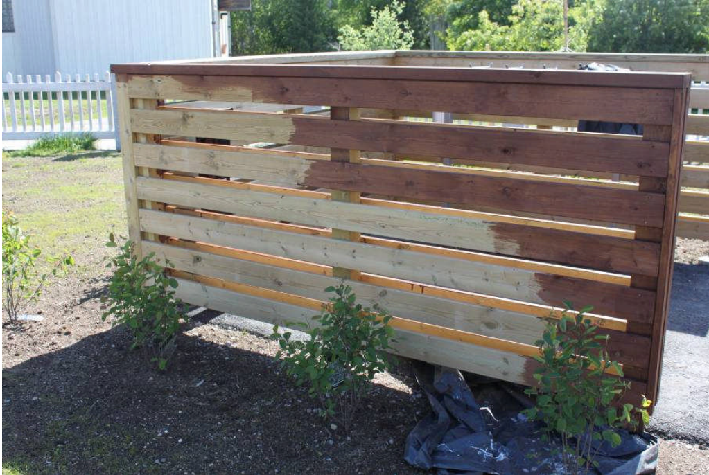
Bild 34: En av de två platserna där en skärmvägg av trä har byggts upp, ca 120 cm hög. Inom denna kommer skräpbehållare för både brännbara - och komposterbara fraktioner att finnas. Här ska det även placeras en ställning för vattenkannor och en vattenpost samt en el-stolpe för kyrkogårdspersonalen. Målning pågick vid efterbesiktningen i juni. (Digital bild nr.9185)
