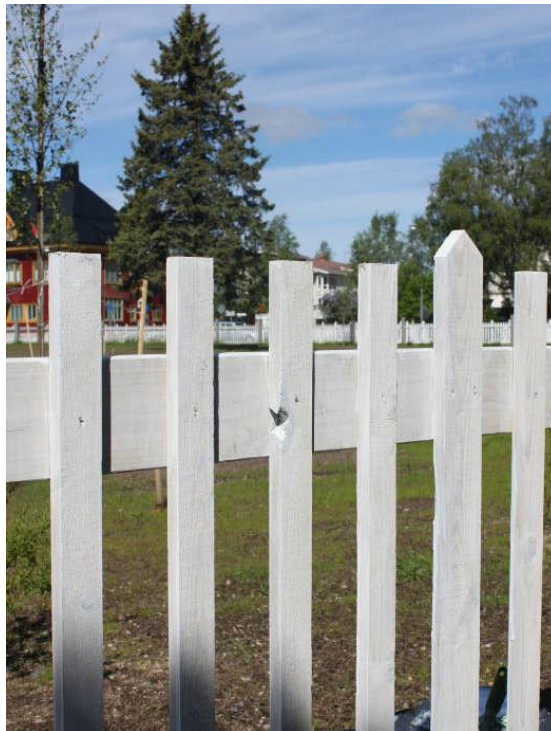
Bild 29 & 30: Trästaketet är behandlat med vit trälasyr, Yunik wood care lasyrolja. Flera kvistbortfall kunde ses på staketet men vid besök i augusti var detta åtgärdat. (Digital bild nr.9193 & 9198)
