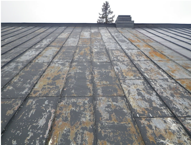
Den äldre plåttäckningen
