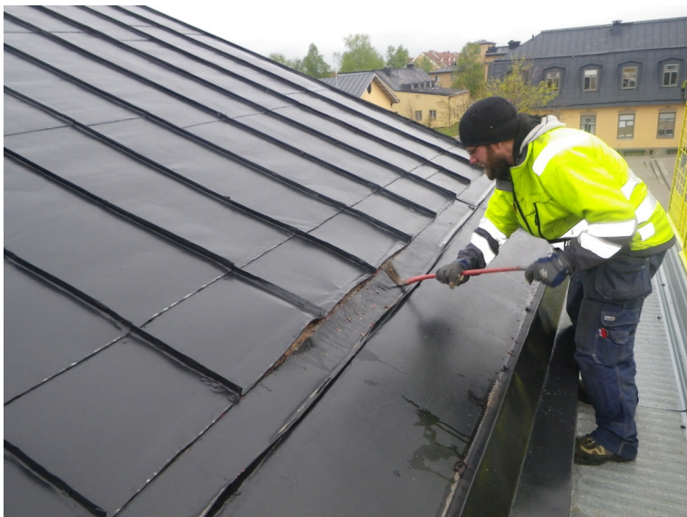
Plåt börjar att rivas
