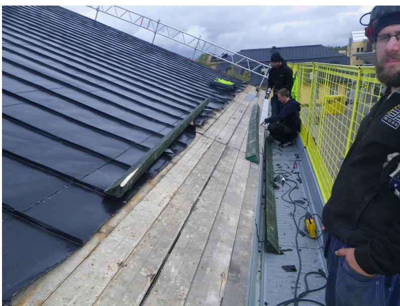
Först rev man bort plåten vid takfoten på sektion 1
