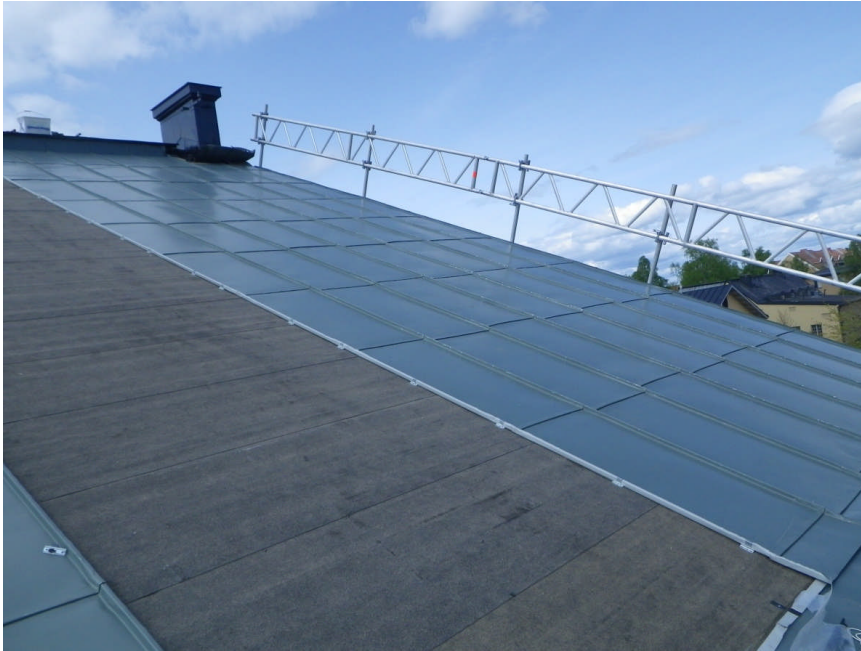
Plåten har börjat att läggas, hakfalsarna är gjorda med minsta möjliga förskjutning, Foto: Rogers plåtslageri
