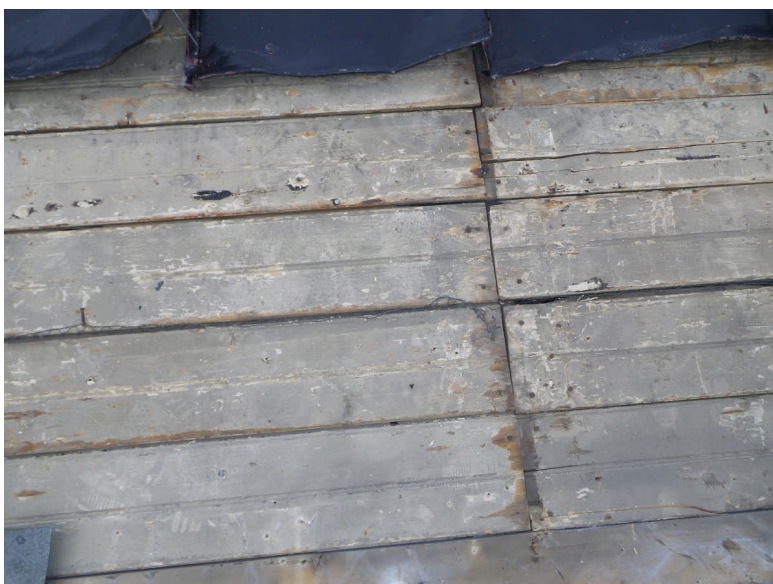
Råspont nere vid takfot
