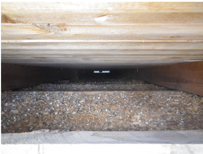
Fyllning av sågspån under rotet
