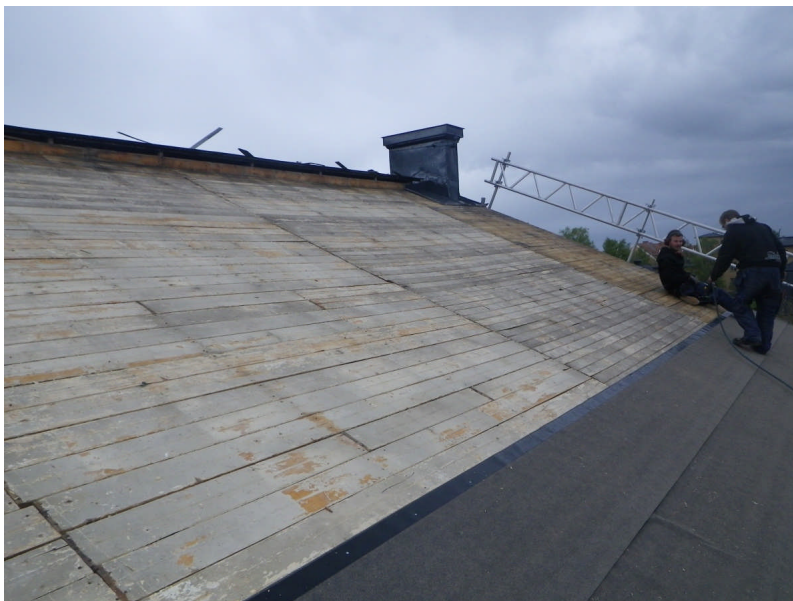
Pappen läggs nerifrån och upp på takfallet
