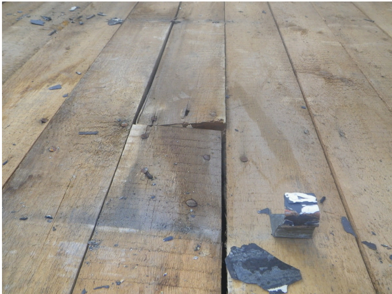
Rotet rensas från klammrar/fästbleck innan papp läggs Foto: Rogers plåtslageri
