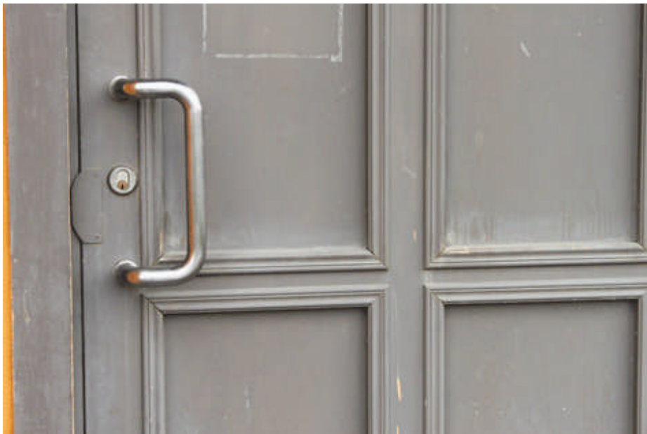
Entrédörr mot norr, före målningsbehandling
