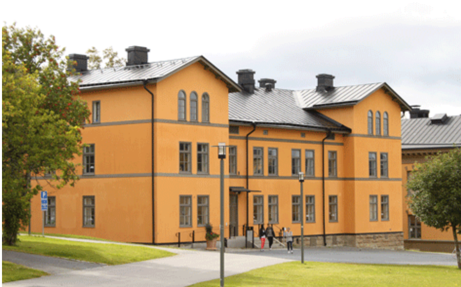
Byggnad nr 5, bild tagen då samtliga restaureringsarbeten på fasaden var klara 2012
