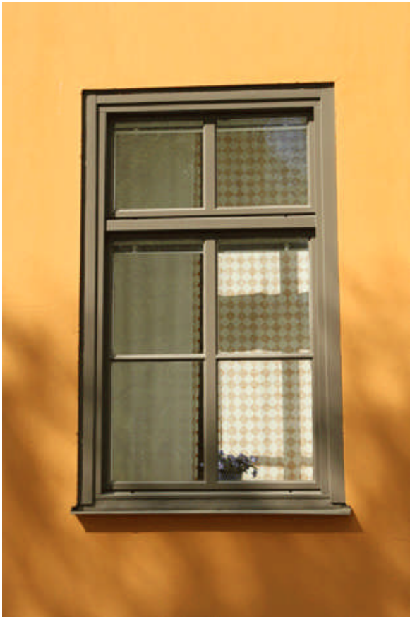
Målat fönster, fasad mot söder
