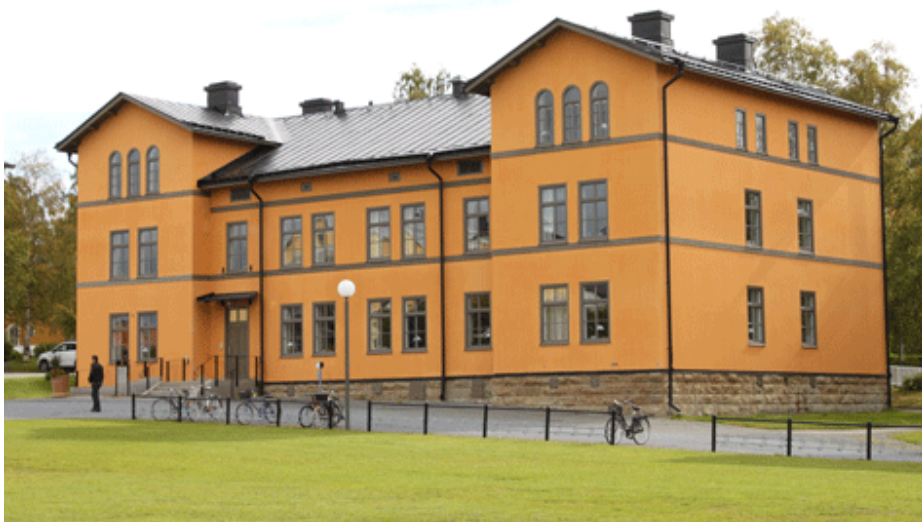
Tak nymålat, fasadrestaureringen är färdigställd
