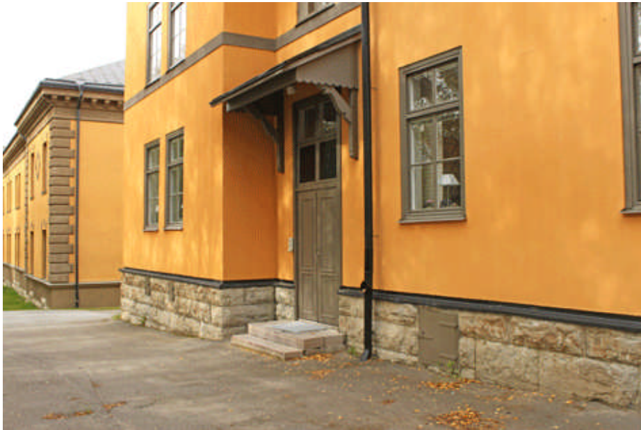
Fasad mot söder efter att fasadrestaureringen är färdigställd
