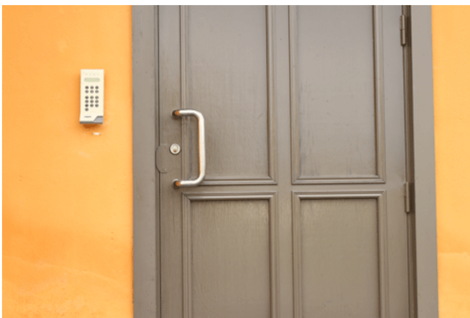
Nymålad entrédörr, fasad mot norr
