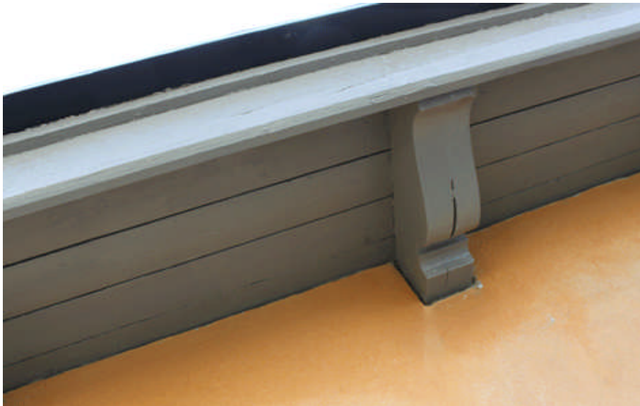
Takfot, efter målningsbehandling
