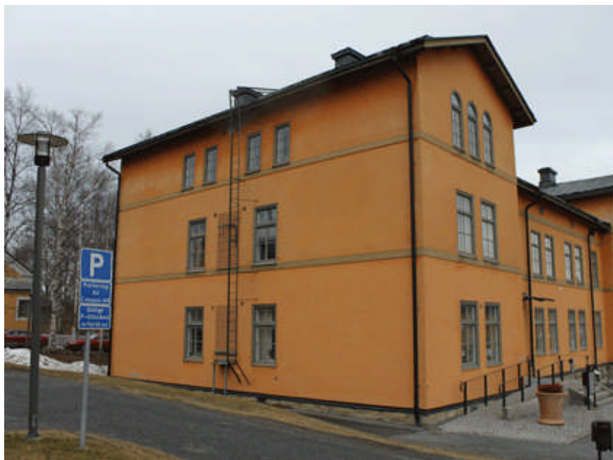
Fasad mot öst, igsatta fönster
