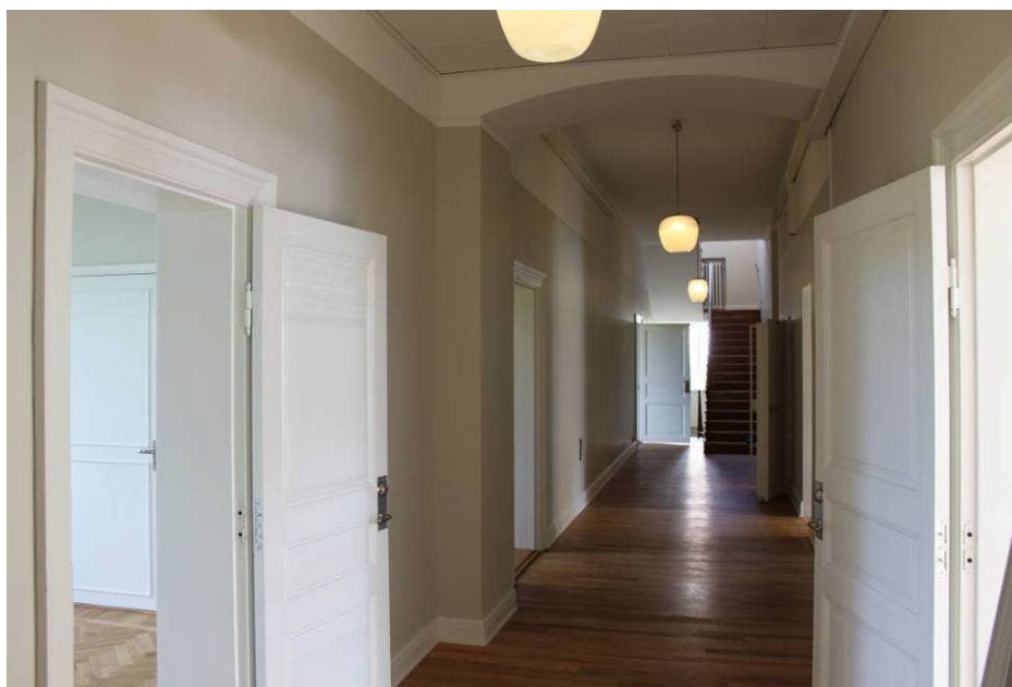
Bild 20. Korridoren i bottenvåningen efter renovering, längst bort syns trappan till våningen ovanför. Pelaren och valvbågen avslöjar den ursprungliga byggnadskroppens sträckning.
