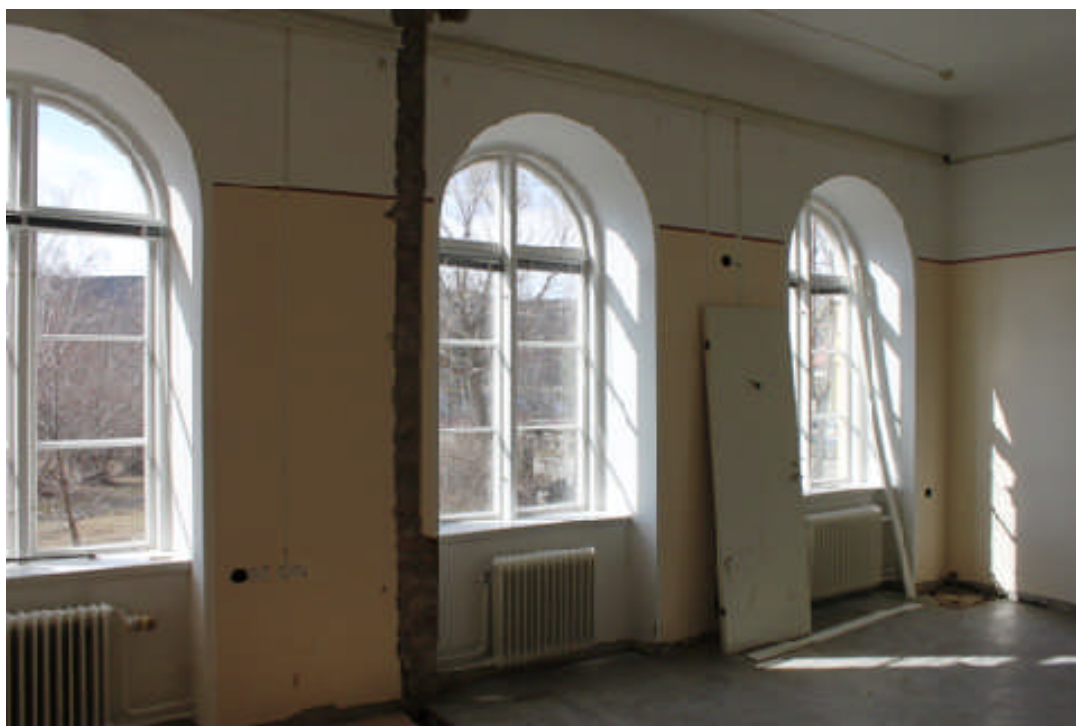
Bild 22. Rum 38 Paus när mellanväggen är nedriven och ytterväggens tegelmur är blottat. Dörren som vilar mot väggen mellan fönstren fick ny placering mot konferensrummet bredvid.
