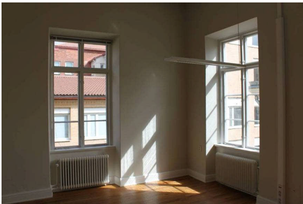
Bild 33. Kontor 148 efter renovering.
