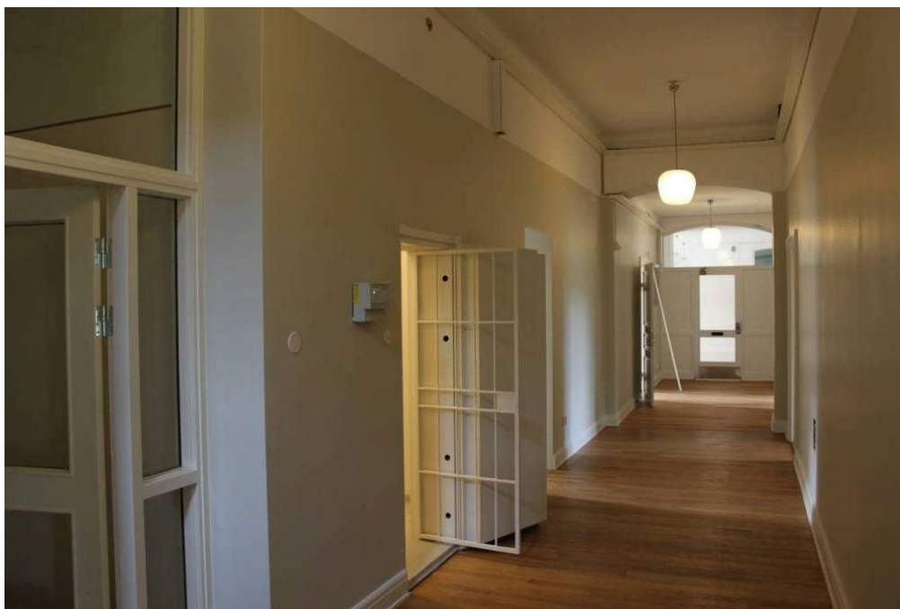
Bild 22. Under: Bild tagen åt samma håll efter renovering, fotografen står i korridor 36 och fotograferar bort mot korridor 36 C som tar vid efter valvbågen. Det nya träglaspartiet som skiljer till angränsande kontorslokaler, syns till vänster i bild. Till skillnad från det andra träglaspartiet är övre fönstret rektangulärt och glasrutor omgärdar dörren.
