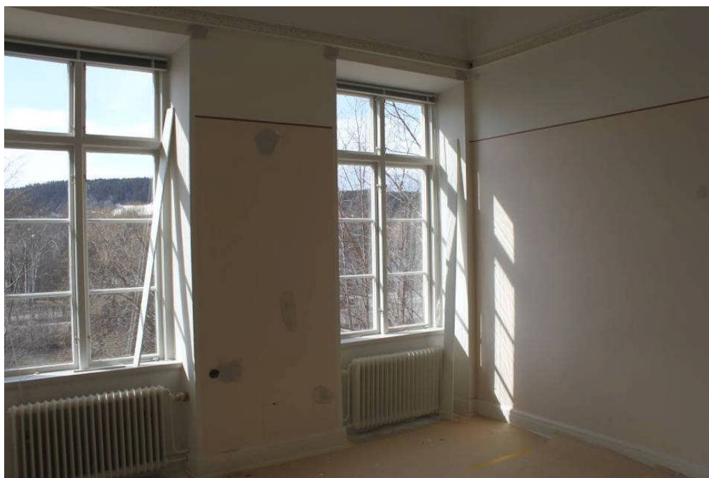
Bild 31. Kontor 140 under renoveringen. Vägghäftet för det tidigare akustikundertaket syns ovan fönstren.
