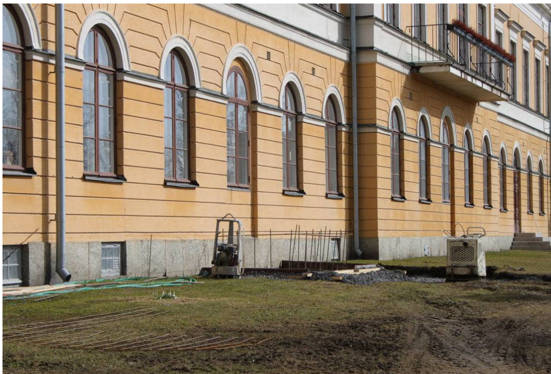
Bild 13. Trädgårdsfasaden innan ombyggnaden där en indragning i vägglivet vid ett fönster (fyra från vänster) avslöjar att där tidigare funnits en dörr.
