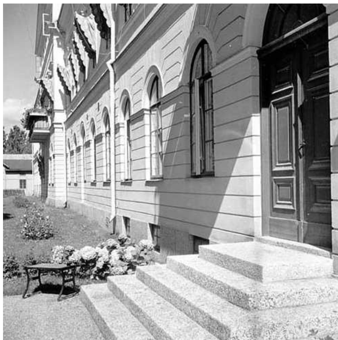
Bild 2. 1936. Fotografi över den västra fasaden, de båda dörröppningarna på var sin sida av frontespisen i den ursprungliga byggnadskroppen är igensatta. Möjligtvis skedde detta i samband med 1930-talets ombyggnad när residenset förlängdes och nya entréer tillkom, exempelvis dörren i förgrunden.
