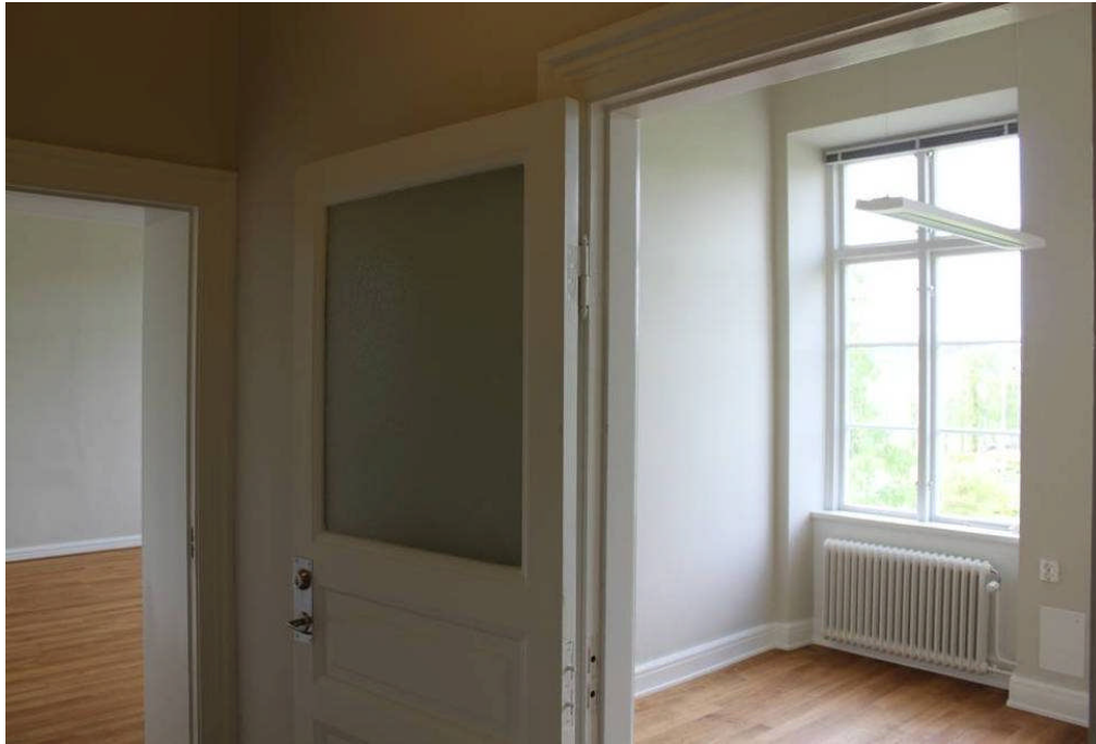
Bild 29. Kontor 139 till höger i bild, efter renovering. Lägg märke till att dörren till detta rum har en glasruta insatt i översta spegeln.
