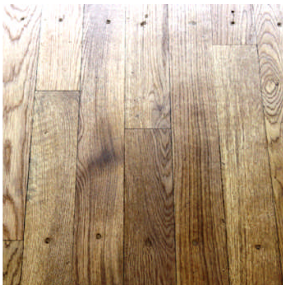
Bild 3. Parkettgolv med stavar lagda i samma riktning Spikhålen från linoleummattorna är ifyllda med spackel.
