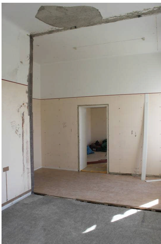
Bild 23. De två olika linoleummattorna syns, en grå och en beige. Dörröppningen sattes igen eftersom pentryt placerades där.
