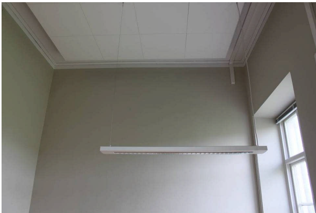
Bild 30. Akustikskivorna sattes med släpp från väggen, och takfärgen är nedmålad ungefär en decimeter på väggen.
