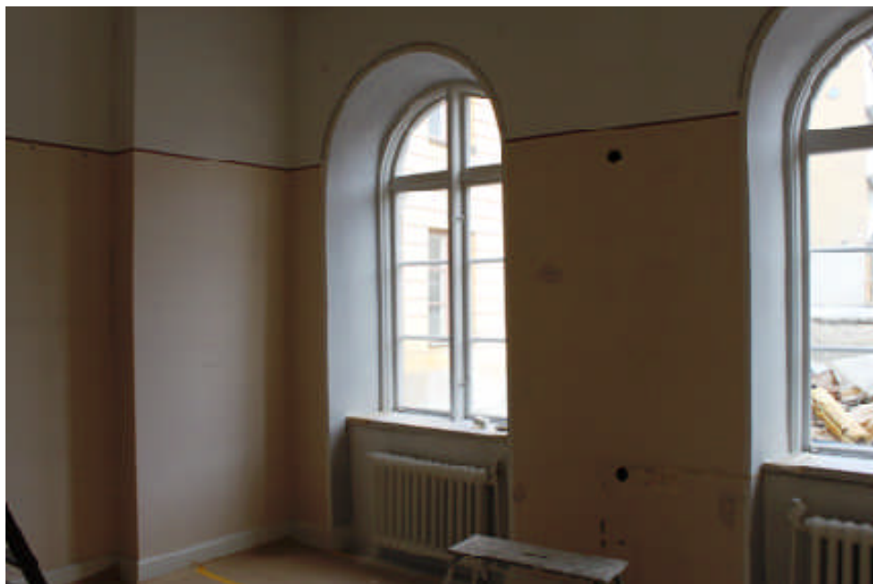
Bild 16. Kontor 30 innan renovering. Gardinsbeslag kring fönsternischernas bågar togs bort. Väggarna är målade i en aprikos kulör som bryts av en röd smal bård innan takfärgen tar vid.
