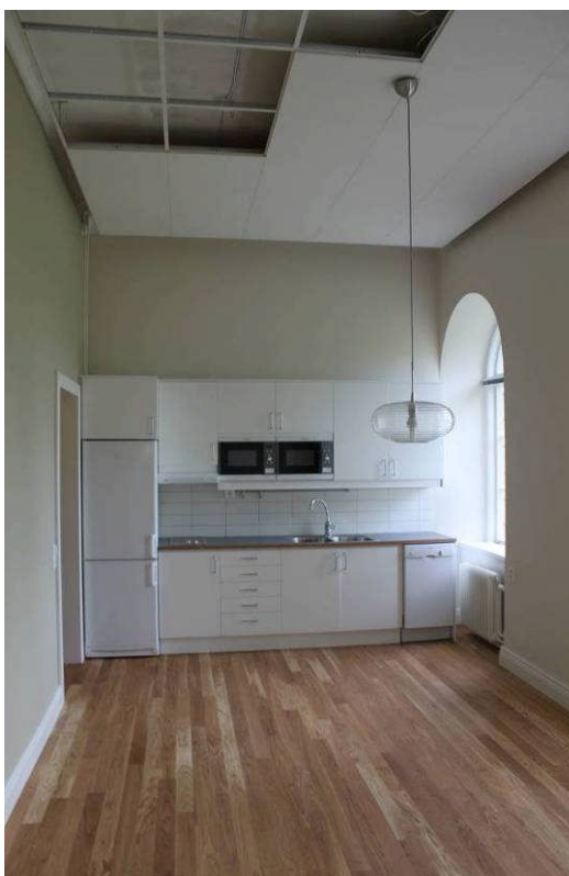
Bild 24. Nytt parkettgolv samt ny taklampa. Akustikundertaket är på väg att sättas upp och det monterades med släpp från väggen. En vägg sattes upp mot passage 37, till vänster om kyl/frys.
