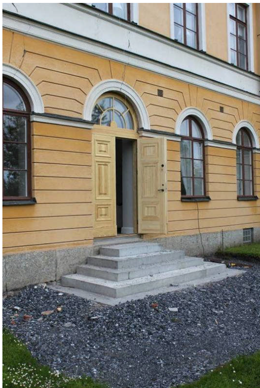
Bild 14. Den nya dörren samt trappa på plats. Ytan med grus stenbelades och dörren målades i en brunröd kulör som överensstämmer med fönstrens kulör.
