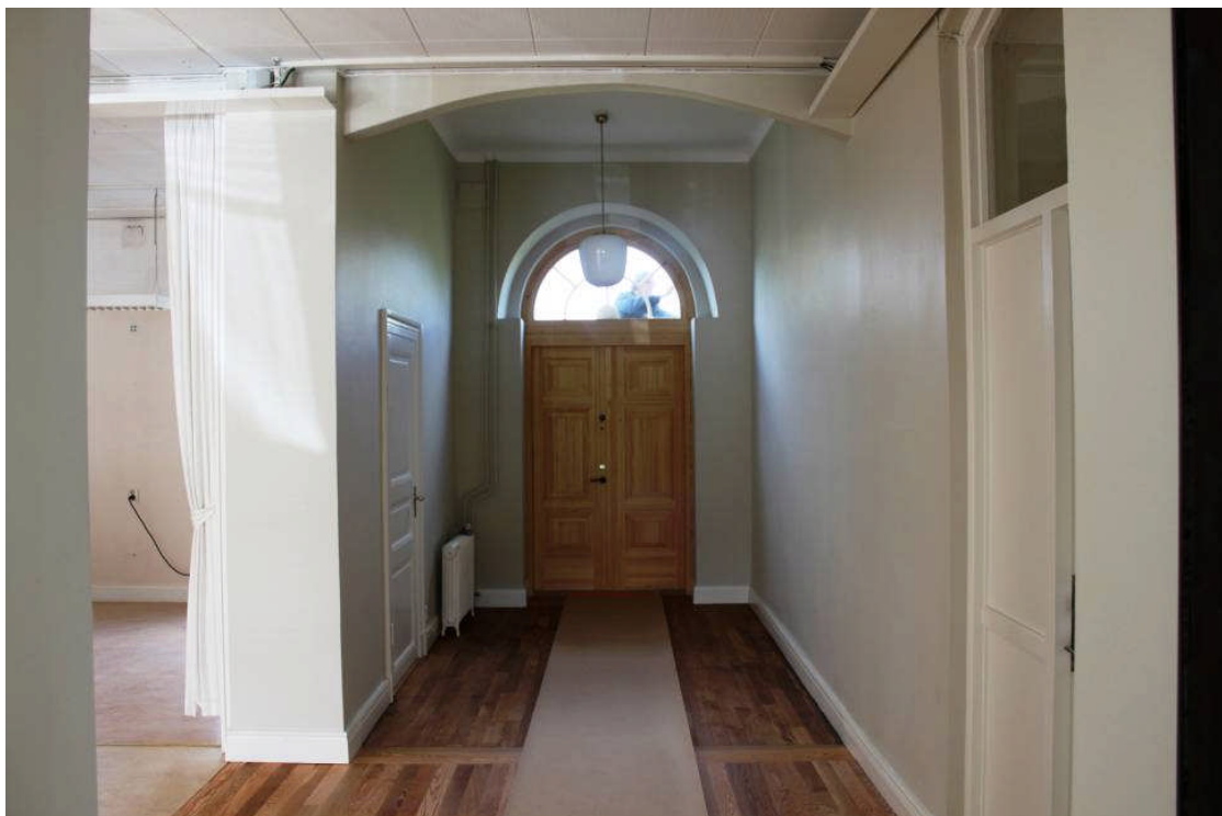
Bild 11. Efter ombyggnaden när den nya entrédörren är på plats och en båge mot taket vittnar om den tidigare väggen.
