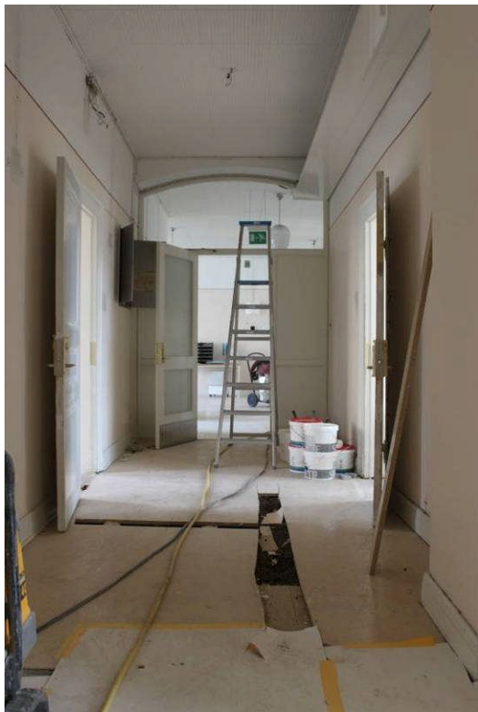
Bild 21. Vänster: Fotografi taget mot träglaspartiet i korridor 36 C under renoveringen. När linoleummattan revs bort upptäcktes att det inte låg parkett under utan ett nytt trägolv fick läggas. Den breda kabelhyllan uppe till höger byttes ut mot nättare på båda sidor korridoren.
