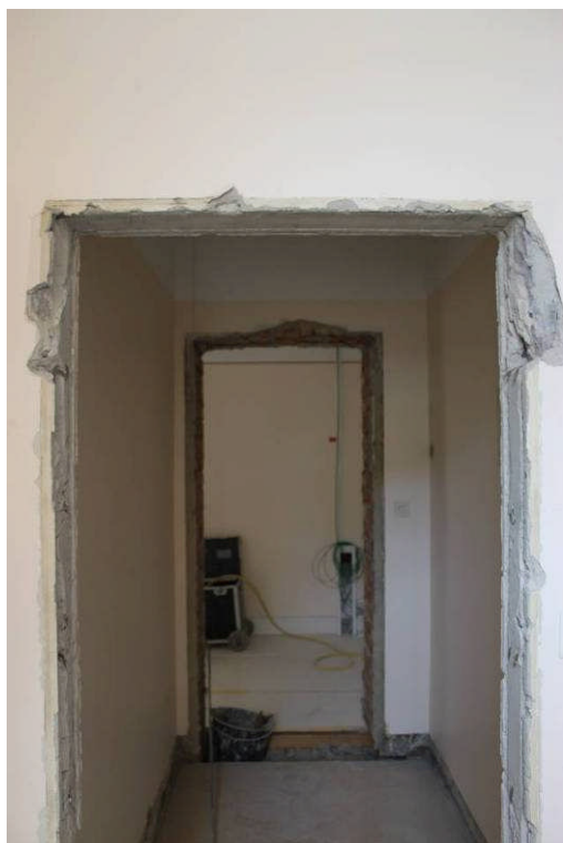
Bild 17. Passagen under renoveringen.
