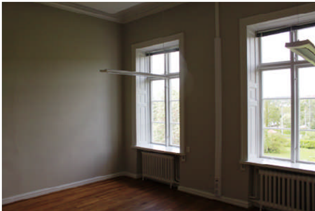
Bild 28. Profilerade foder kring fönstren.
