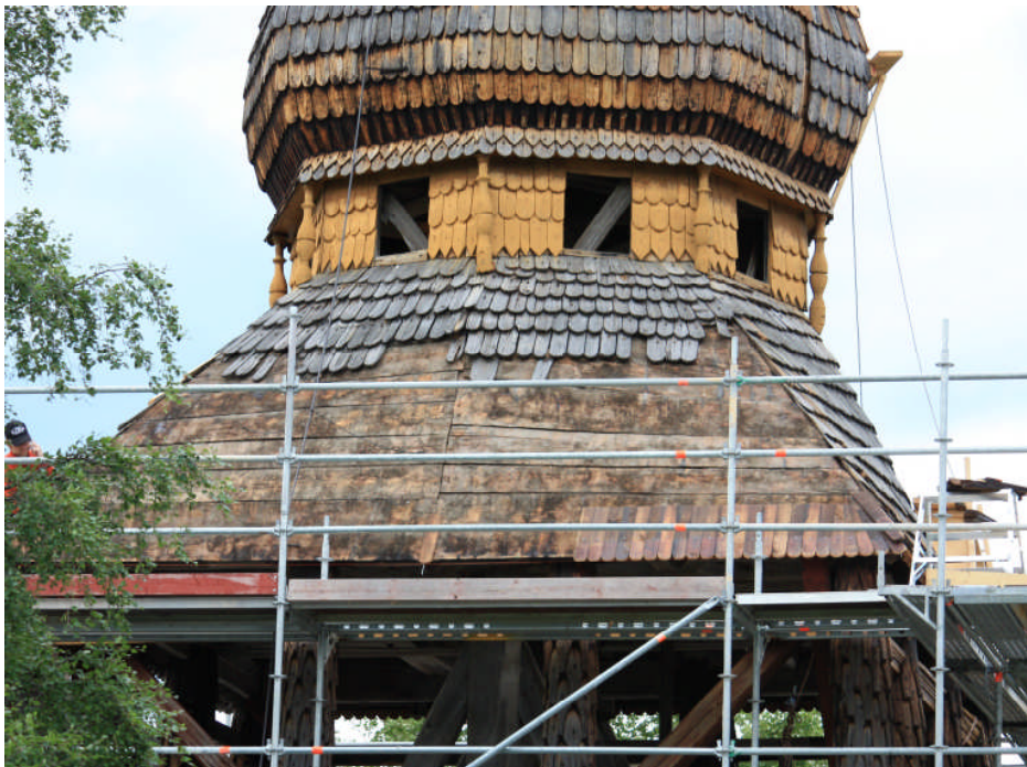
Bild 9. Byte av spån på taket ovan klockdäck (foto: Västra Storsjöbygdens församling).
