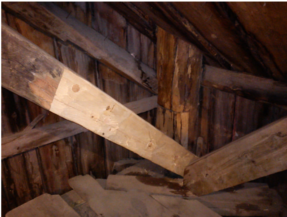
Bild 13. Snedsträva vid den sydöstra knutpunkten som ilagats (foto: Västra Storsjöbygdens församling)
