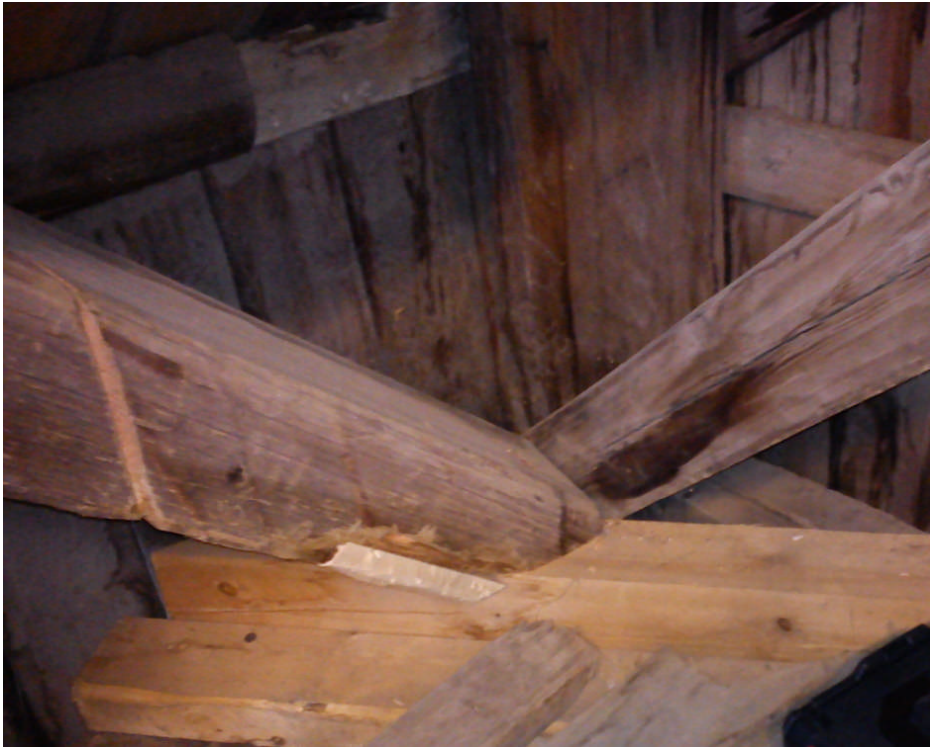
Bild 6. Snedsträvan vid den nordöstra knutpunkten har lagats med en halvsula och fått ett nytt upplag. Strävan förseddes även med skåra och droppkant (foto: Västra Storsjöbygdens församling).
