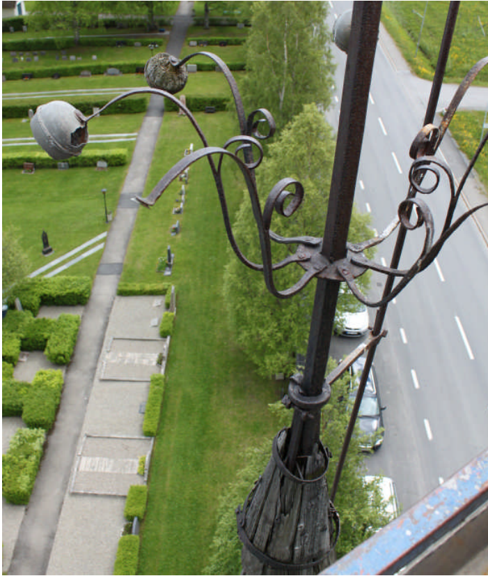
Bild 18. Skadade trä- och blykolor på klockstapelns spira (digital bild nr 011)
