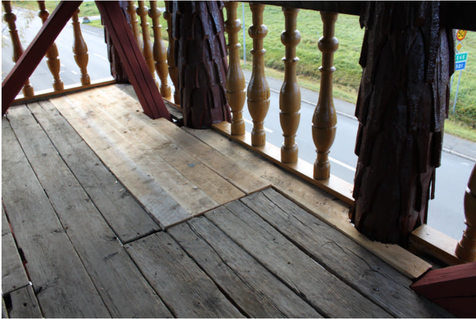
Bild 16. Utbytta golvbrädor på klockdäcket (digital bild nr 3178)
