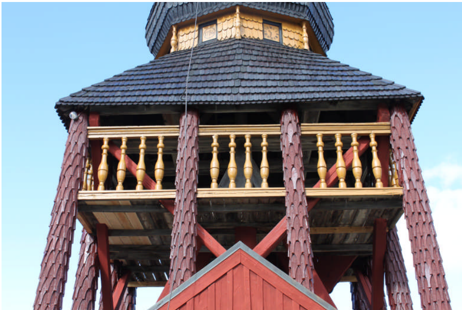
Bild 19. Klockstapeln efter restaurering vid slutbesiktningen 2010-09-15. Under klockdäckets golv skymtar den utbytta och den skarvade golvbjälken (digital bild nr 3193)
