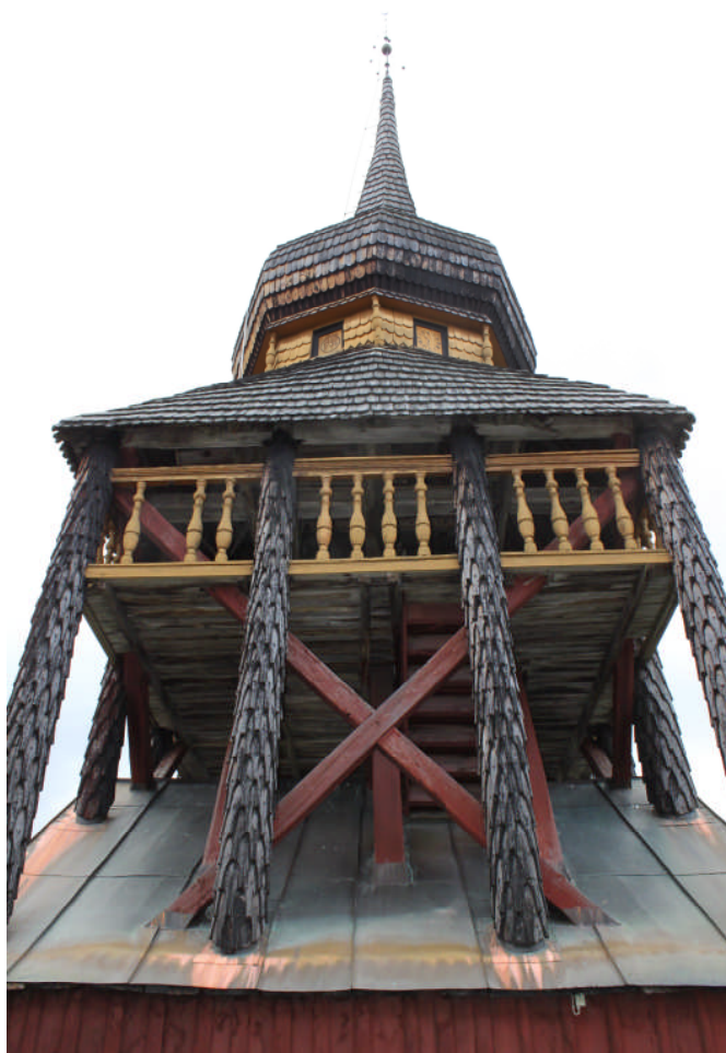
Bild 2. Hallens klockstapel före restaureringen med dess näbbspånsklädda pelare, rödfärgade kryssträvor samt gulmålad balustad och italian (digital bild nr 121).
