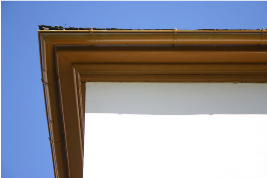
Bild 10. Kyrkans takfot har strykit tre gånger med linoljefärg pigmenterad med guldockra (digital bild nr 3256 ).
