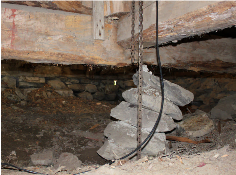
Bild 5. Grunden under bjälklaget har rensats ur och stenen har fixerats (digital bild nr 028).
