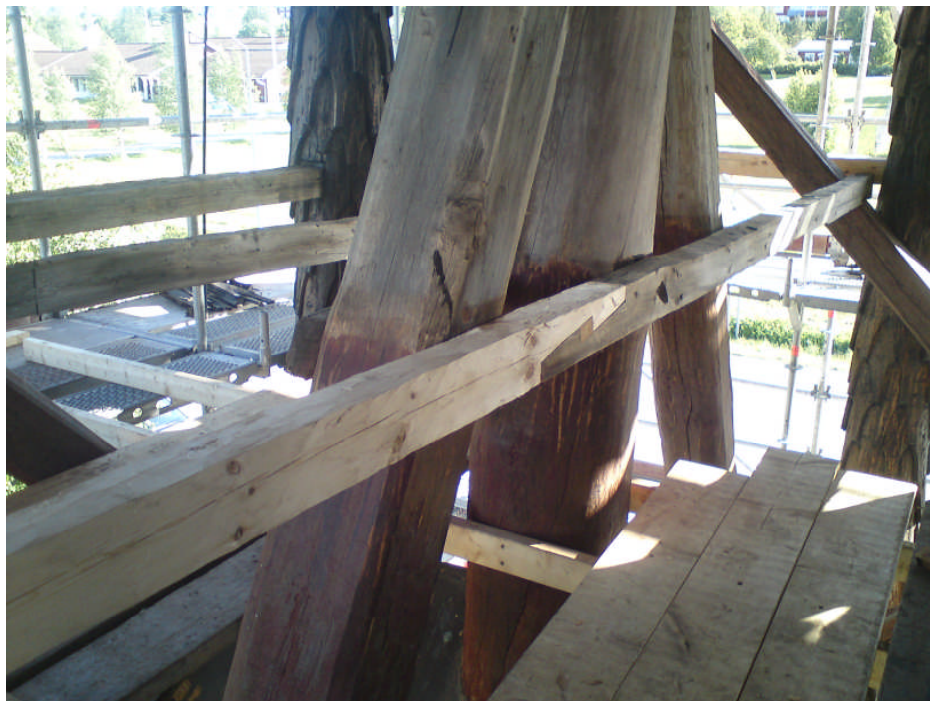
Bild 8. Ny golvbjälke med läsbar blixtskarv (foto: Kyrktak Bygg & konsult AB)
