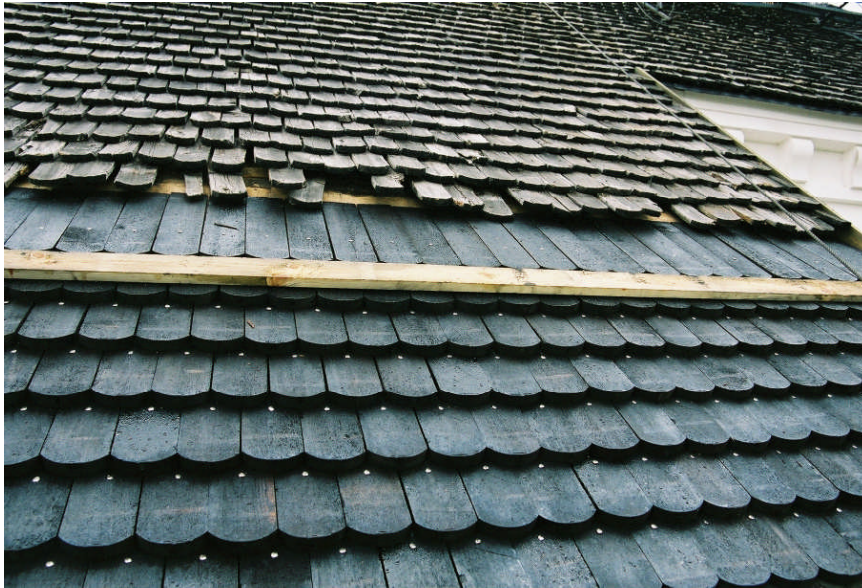
Spånläggning pågår, man började som brukligt nedifrån och demonterade äldre spån efterhand. Foto Jlm 05m73_32
