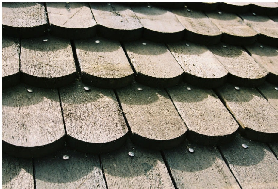
Nytt spån med synlig spikning
