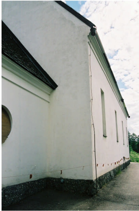
Putslagning vid takfot på långhus genomförd Foto Jlm: 05m80_16
