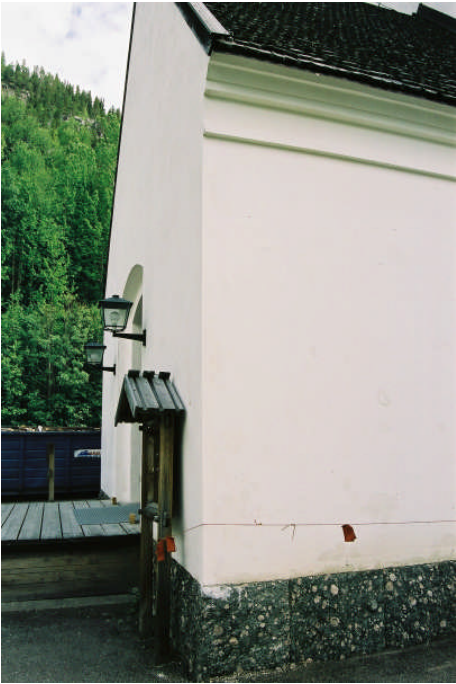
Putslagning vid hörn på vapenhus genomförd Foto: Jlm 05m80_15
