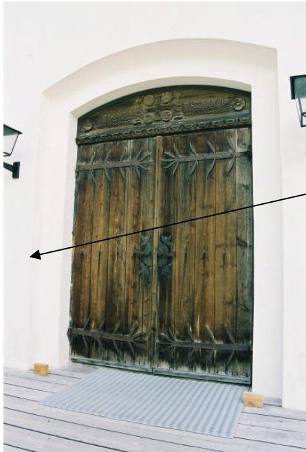
Lagning vid entrédörr Foto: Jlm 05m80_17
