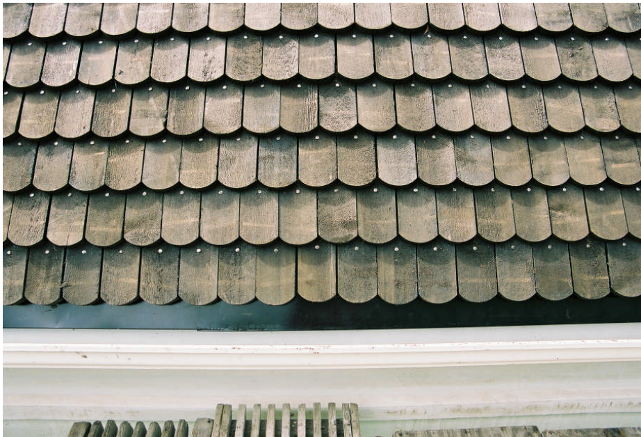
Här syns den svartmålade avtäckningsplåten vid takfoten
