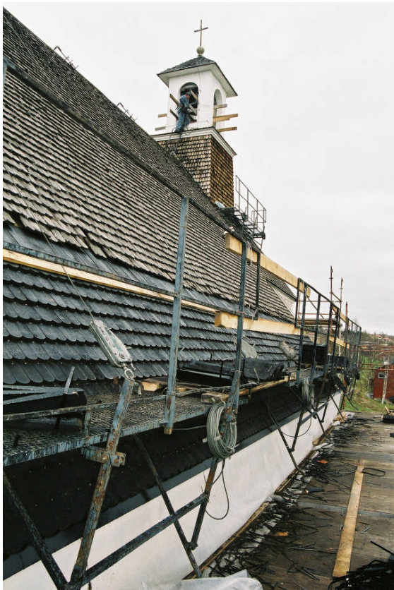
Långhusets södra takfall, arbete pågår Jlm 05m73_36
