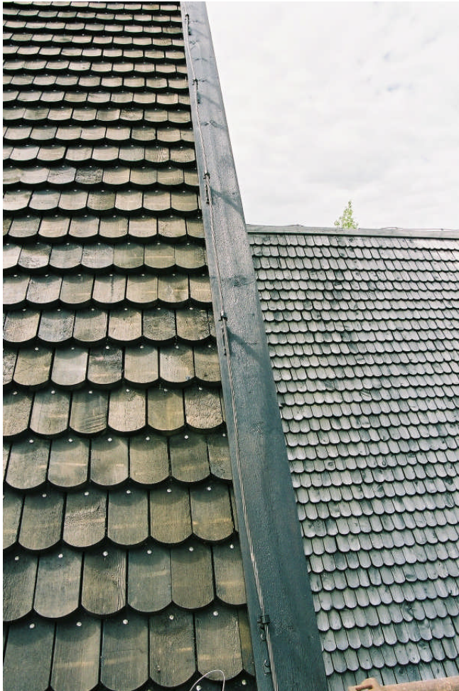
Nytt spån på långhus synlig spikning, äldre spån syns på vapenhusets tak Jlm 05m80_27
