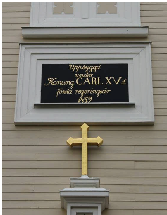
Vänster: Inskriptionstavlan och korset ovanför entrén efter restaurering. Tavlan vändes och ny text, med samma utseende som den tidigare, målades på baksidan.
