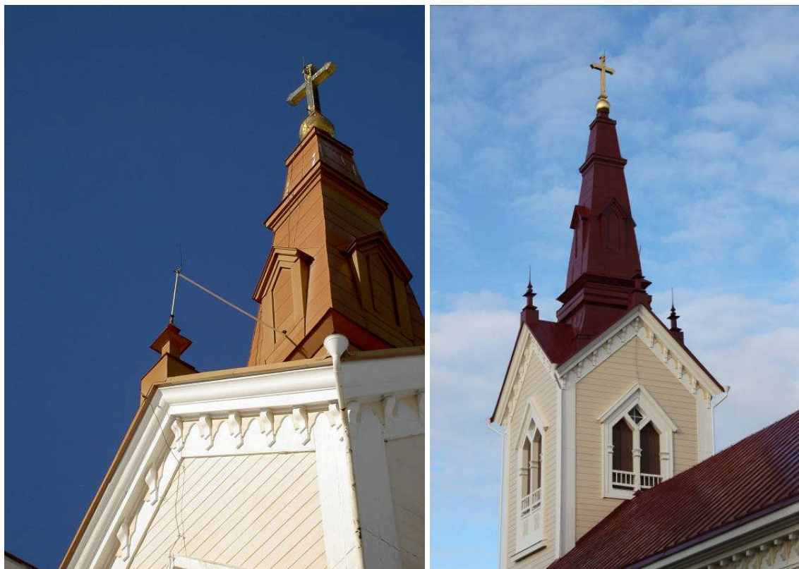
Tornspiran innan respektive efter restaureringen. Befintlig färg var blekt och gick mot orange, den nya färgen är röd. Lägg märke till att korset sitter lite snett och vinklat aningen mot söder. På högra bilden syns även ljudluckorna som målades under restaureringen.
