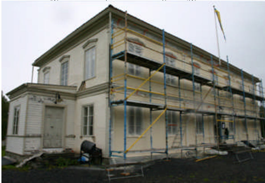
Bild 5. A-väggens fasad har restaurerats och avfärgats sommaren 2008. Renovering av fönster pågår.
