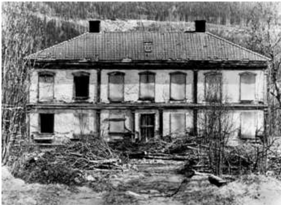
Bild 2: Fasad A innan restaureringen 1980-tal
