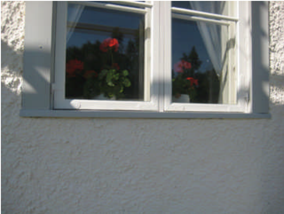
Bild 9. Fönsterfoder, vattbräda, fönsterbågar och fönsterkarm efter fönsterrenovering och målning
