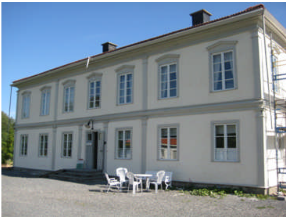
Bild 9. Fasad A vid slutbesiktningen 2009-08-07.
