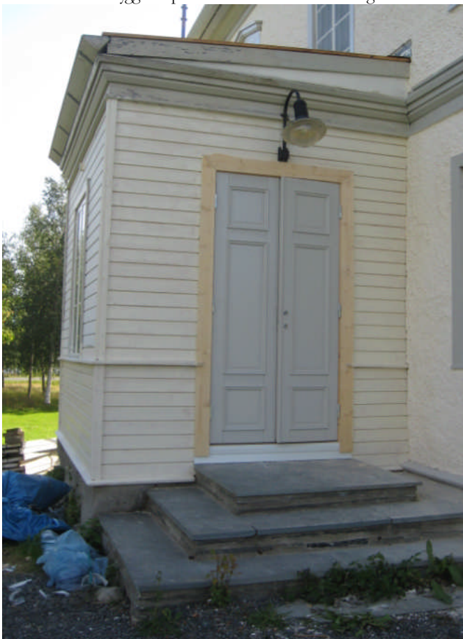
Bild 7: Gavelutbyggnad på fasad B efter restaureringsarbeten 2009.
