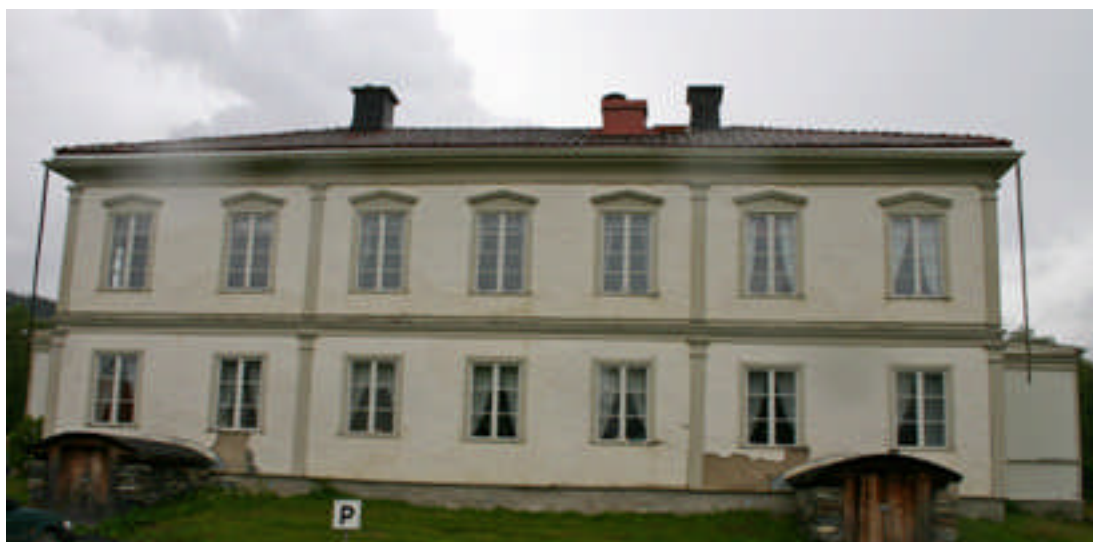
Bild 1. Fasad C, östra fasaden, med puts-skador innan restaurering 2008.
