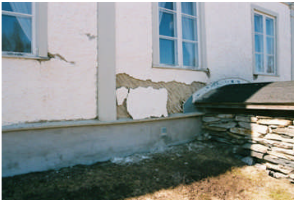
Bild 10: Fasad C, Skadad puts i anslutning till fönster och källarnedgång våren 2008 innan restaureringen påbörjades. Träribborna är synliga.
