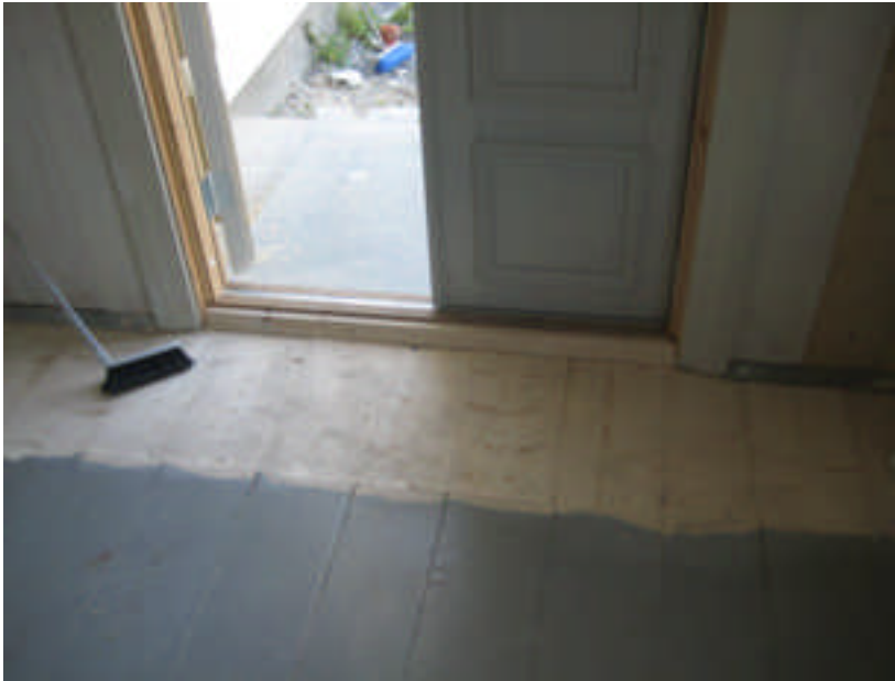
Bild 8. Golvet innanför entrén till utbyggnaden på B-vägg som byttes ut eftersom det var rötskadat.
