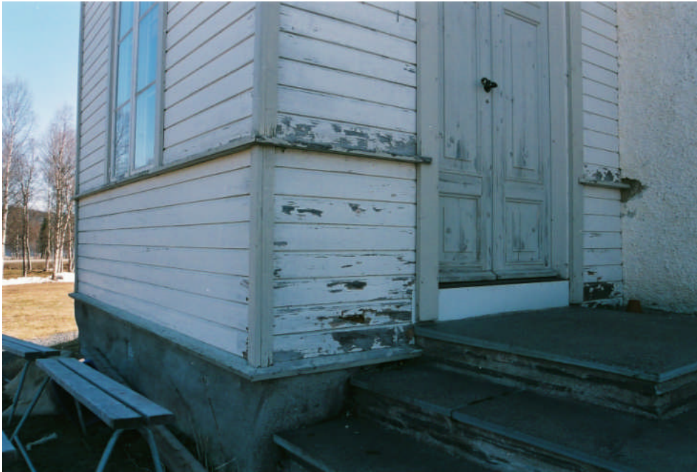
Bild 6: Gavelutbyggnad på fasad B innan restaureringsarbeten 2009.
