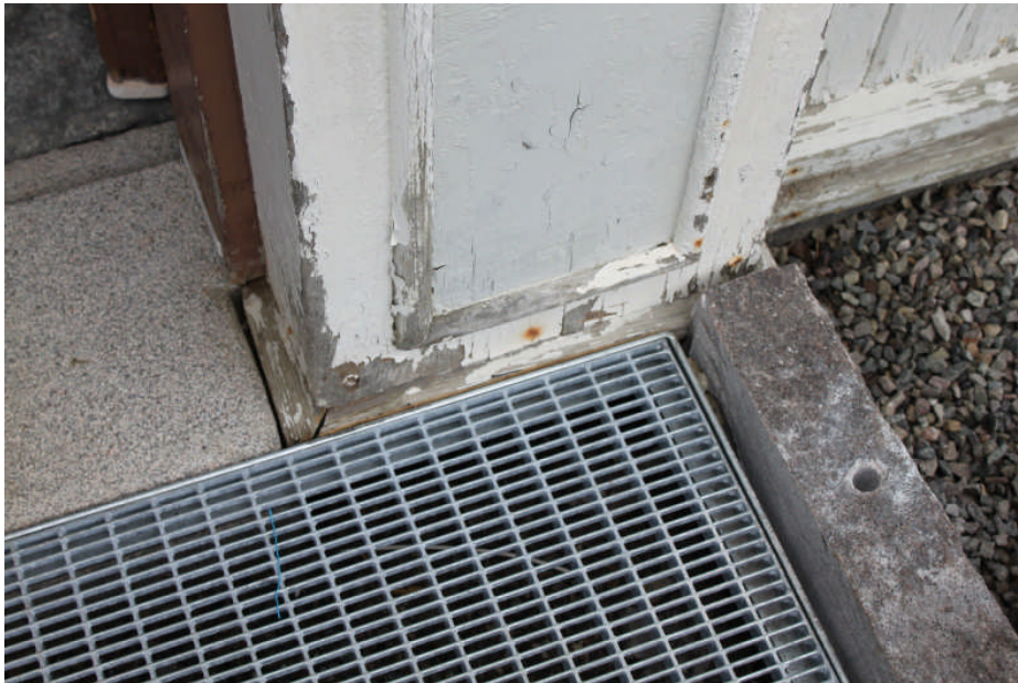
Tröskeln är monterad, skrapgaller ligger framför och kantsten har satts på plats
