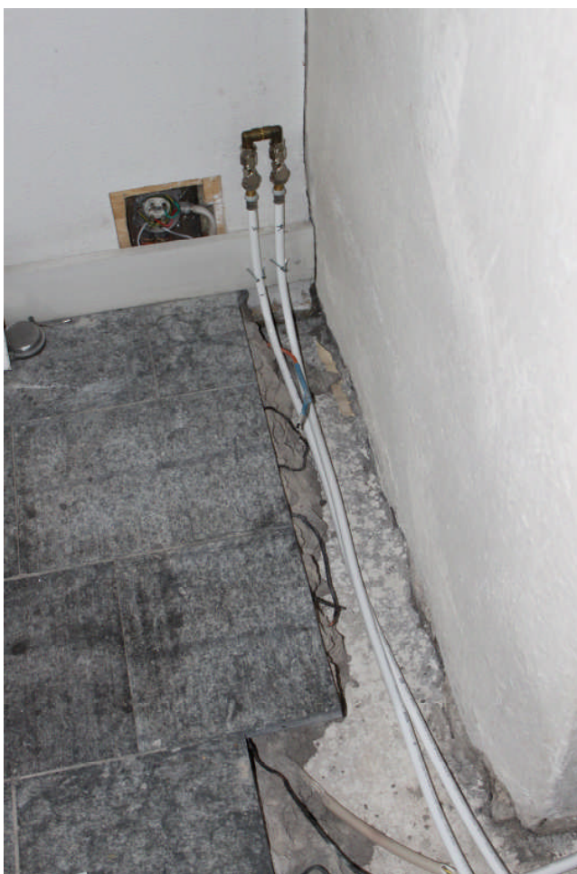
Under arbetet med att dra ledningar för radiatorer i vapenhuset
