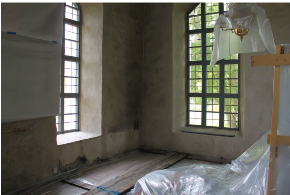
Arbete pågår i koret
