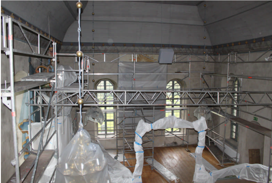
Ställningar är monterade i kyrkorummet för konservering av gesims och kullist
