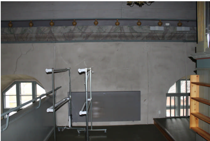
Äldre radiator på läktare som kommer tas bort under nästa restaureringsfas av kyrkan
