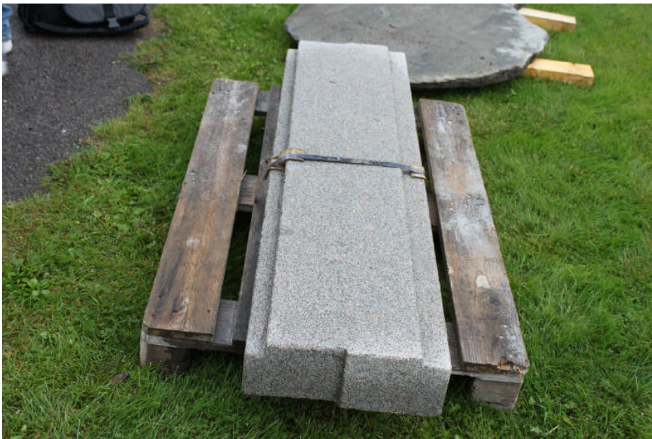
Den nya måttbeställda tröskeln i granit
