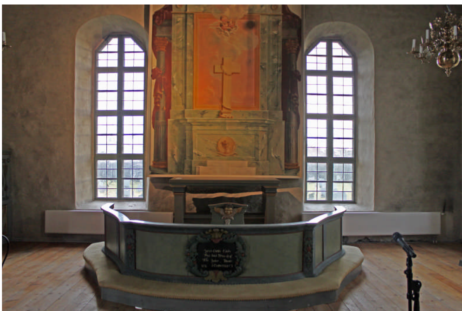
Radiatorer i koret, bilden är tagen före det att radiatoren på den norra sidan om altaret förskjuts åt vänster för att hamna i linje med fönsteröppningen
