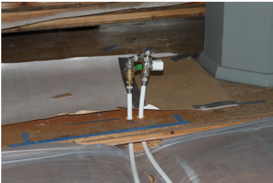
Hål har borrats i golvet och ledningarna för bänkvärmarna har dragits upp
