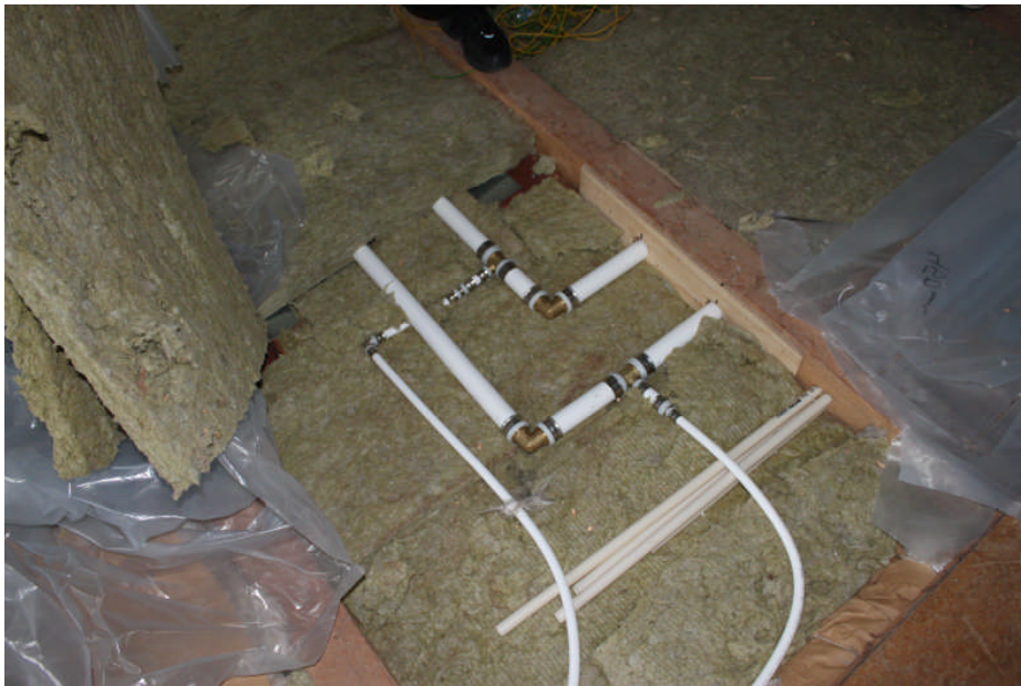
Golvet är bortmonterat och ledningarna nedlagda i isoleringen
