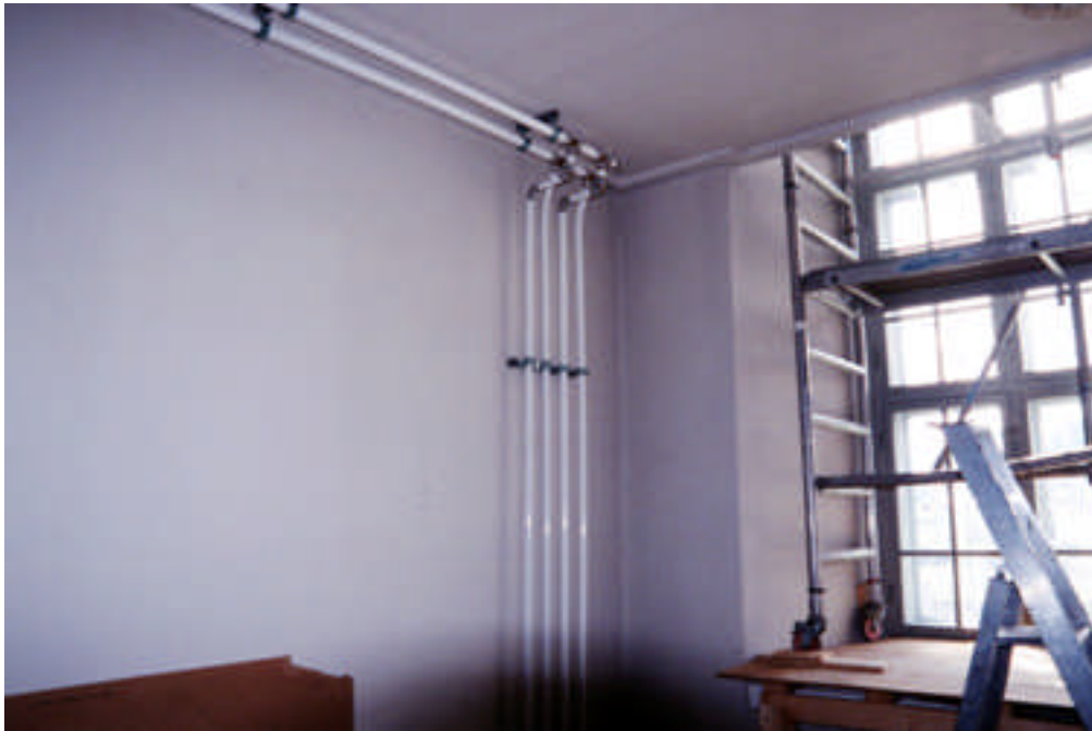
Bild 4: Rördragning från samlingsrummet upp till läktaren.
