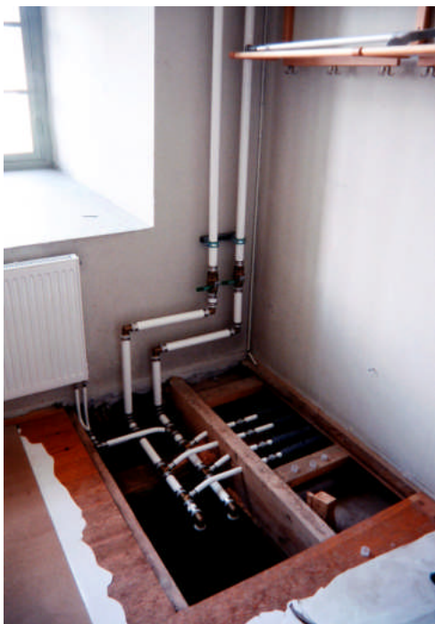
Bild 2: Brunn i köpprummet.
