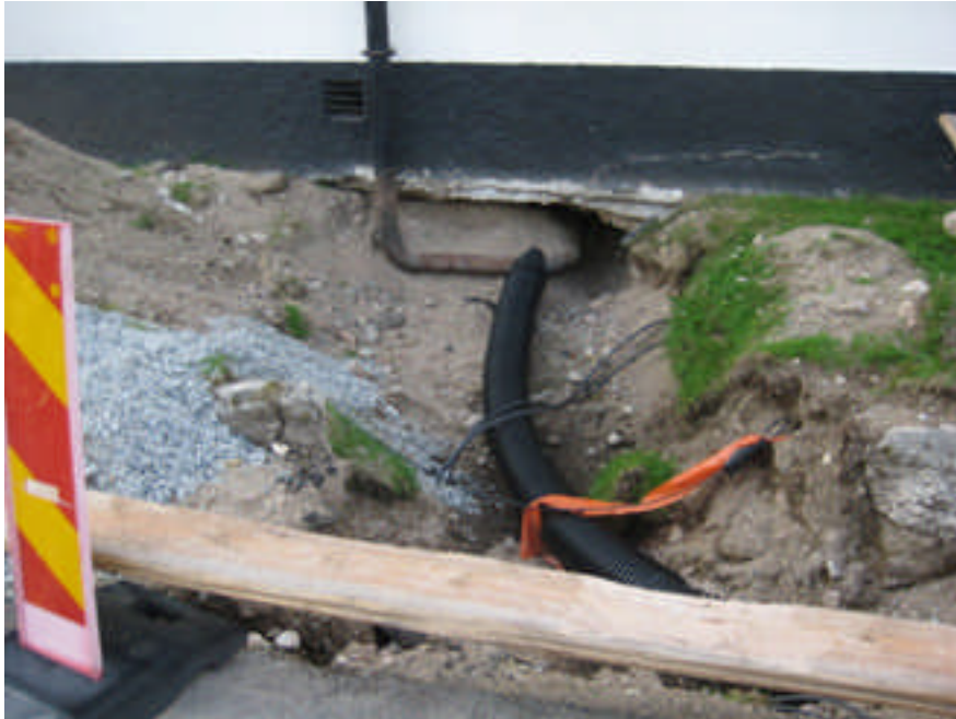
Bild 1: Kulvertdägning från värmecentralen mot kyrkan.
