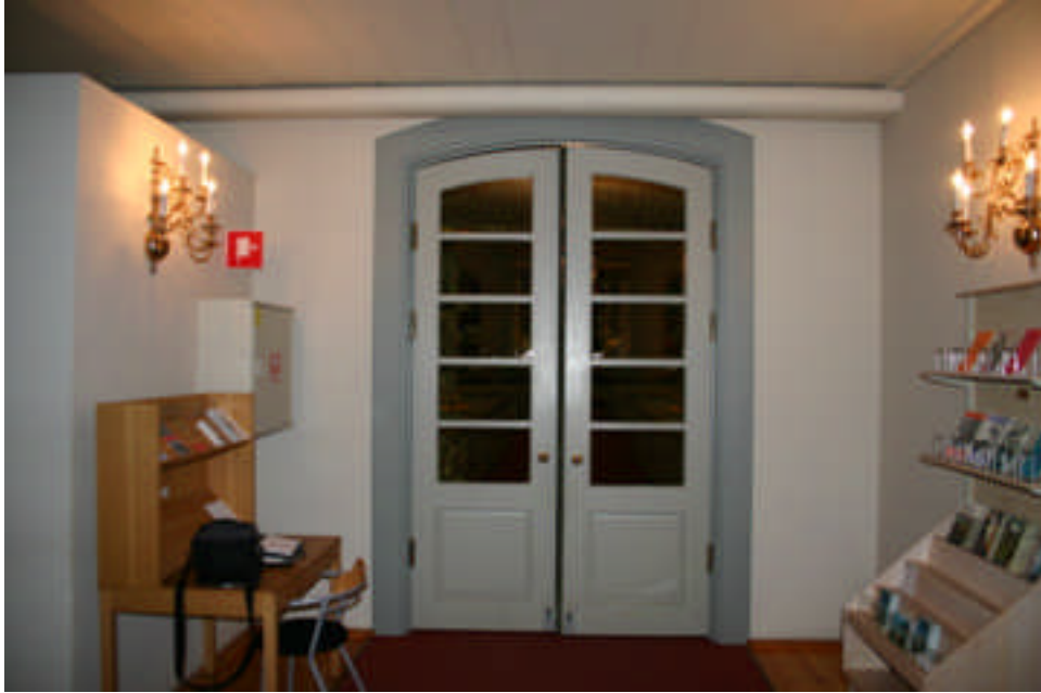
Bild 3: Isolerade rördragning längs taket mellan kapprum och samlingsrum.
