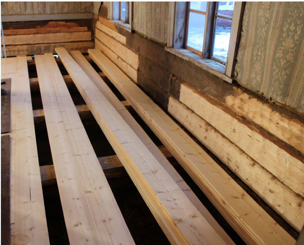
Bild 7. Rum D/sal. Golvbrädorna vilar på åsarna och har tillfälligt skruvats fast men ska ersättas med spik då golvet torkat ihop. IMG_6852
