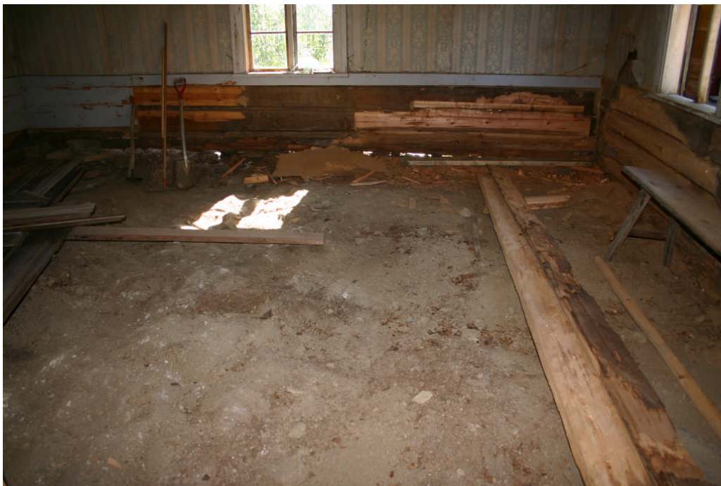
Bild 2. Rum D/sal efter bortplockning av golvbjälklag. Bild från 2010. IMG_3172
