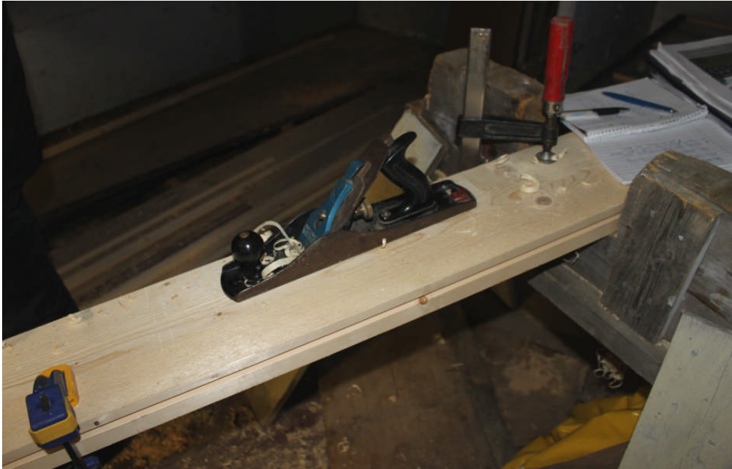
Bild 6. Golvbrädorna levererades maskinhyvlade men fick en handhyvlad yta på plats. IMG_6893
