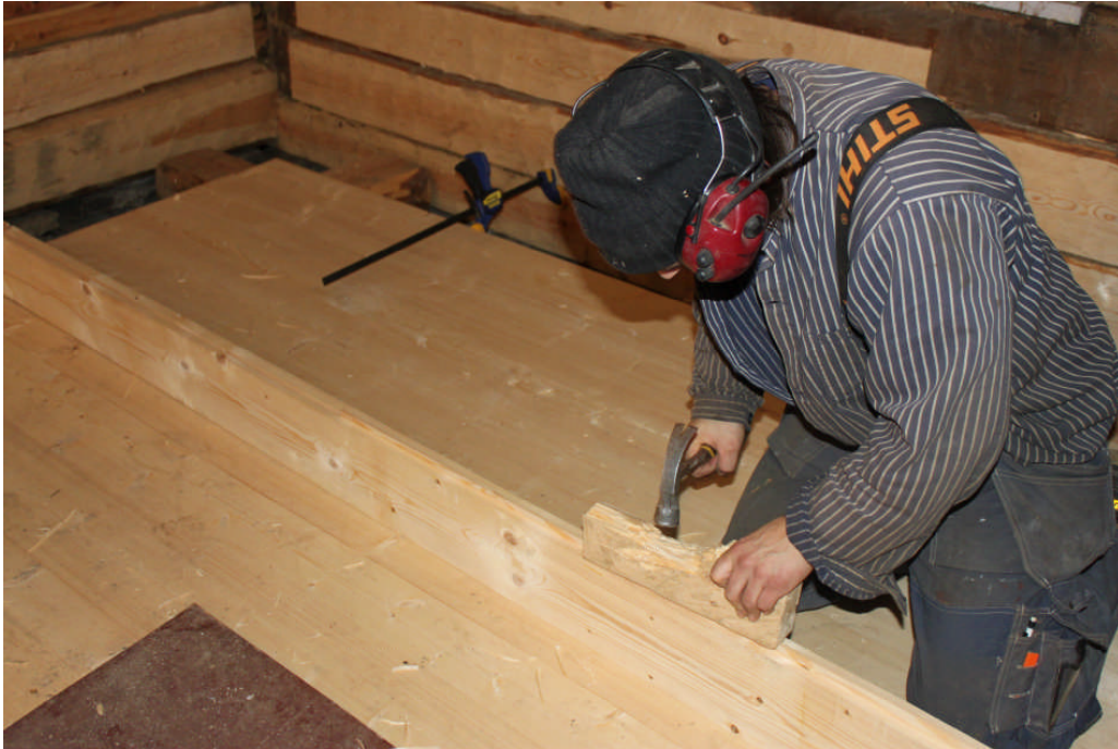
Bild 8. Rum D/sal. Golvet beställdes med fast fjäder men levererades med lös fjäder. Eftersom byggnadsskicket med lös fjäder anses vara äldre än med fast fjäder kan det nuvarande golvet anses som kulturhistoriskt riktigt. IMG_6956
