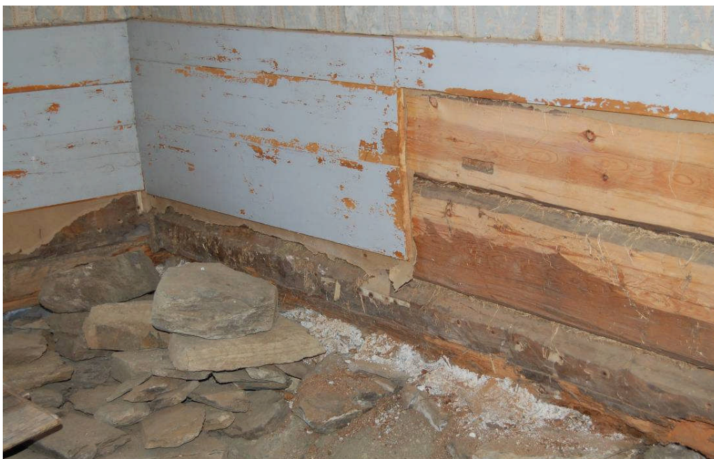
Bild 3. Rum D/sal delar av bröstpanelen har monterats ned. IMG_061
