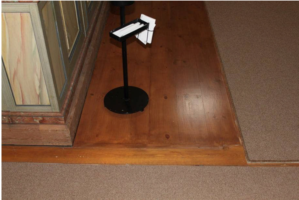
Bild 4. Det nylagda golvet fick en något mörkare kulör än övriga golv. Brädorna lades i samma riktning som tvärgången men skiljer sig från mittgången.
