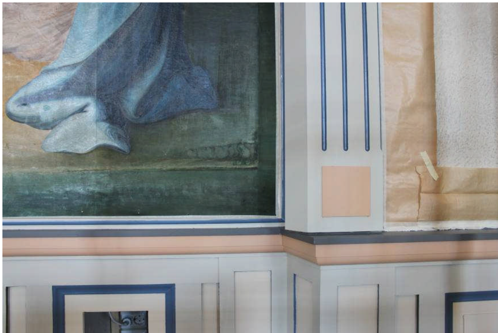
Bild 7. Under arbetets gång när dopaltaret har grundmålats med täckande färg.
