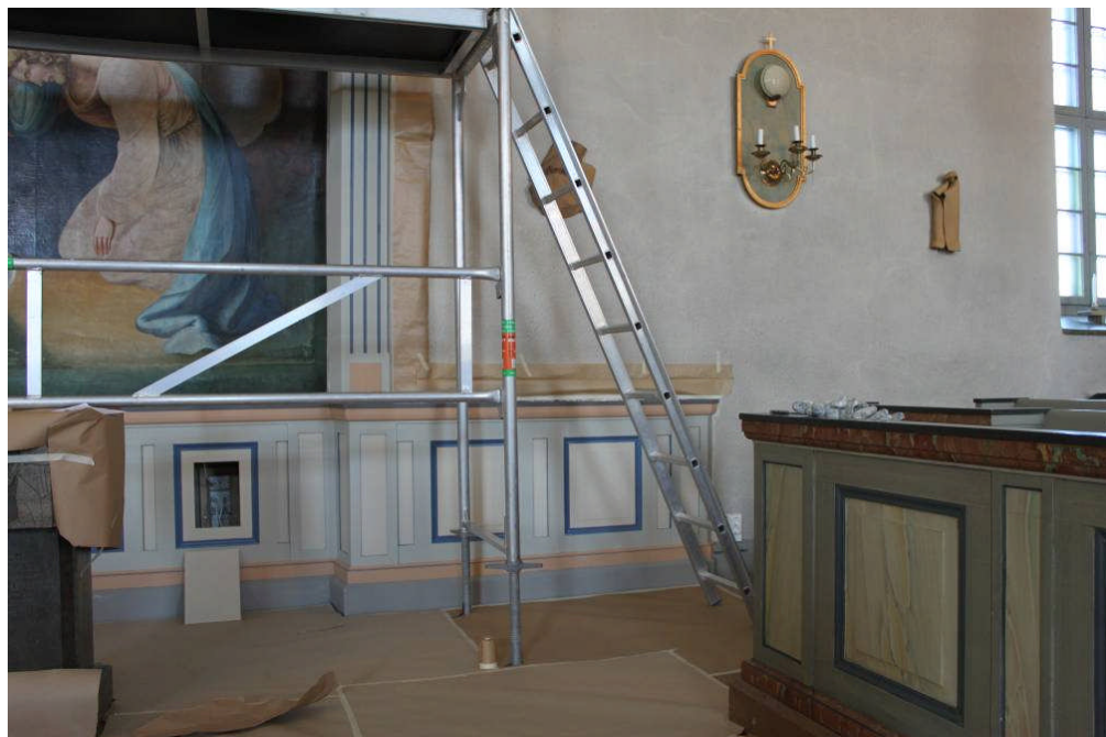
Bild 6. Dopaltaret är färdigbyggt och bröstpanelen stämmer i mått överens med bänkarnas kvartersavskiljningar, varav en syns i förgrunden. Under tavlan syns luckan som döljer elinstallationer. Grundmålning är utförd.
