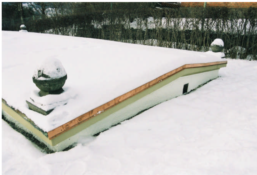
Bild 5. Den utbytt gavelplåten mot öster (bild 05M11/25).
