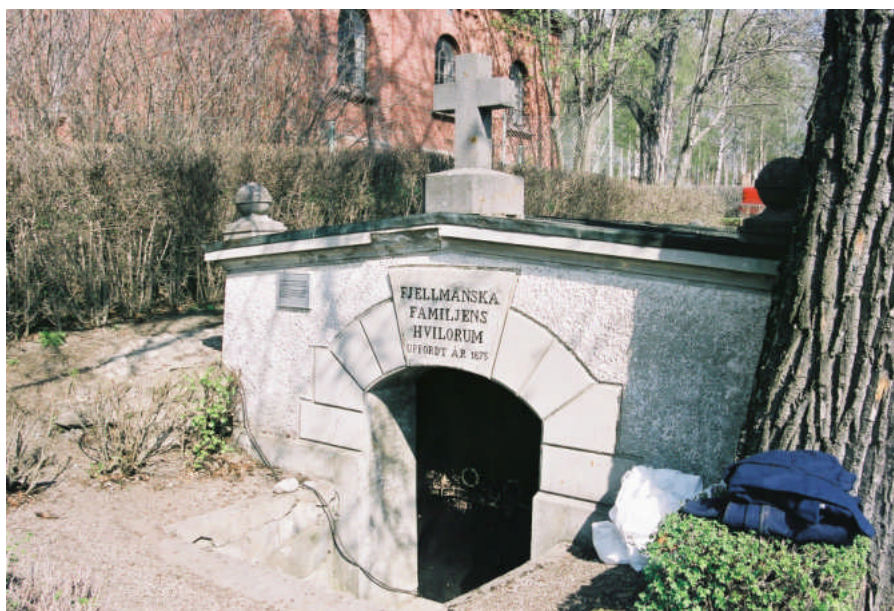
Bild 1. Gravkorets entré innan åtgärd. (bild 04m96/22)
