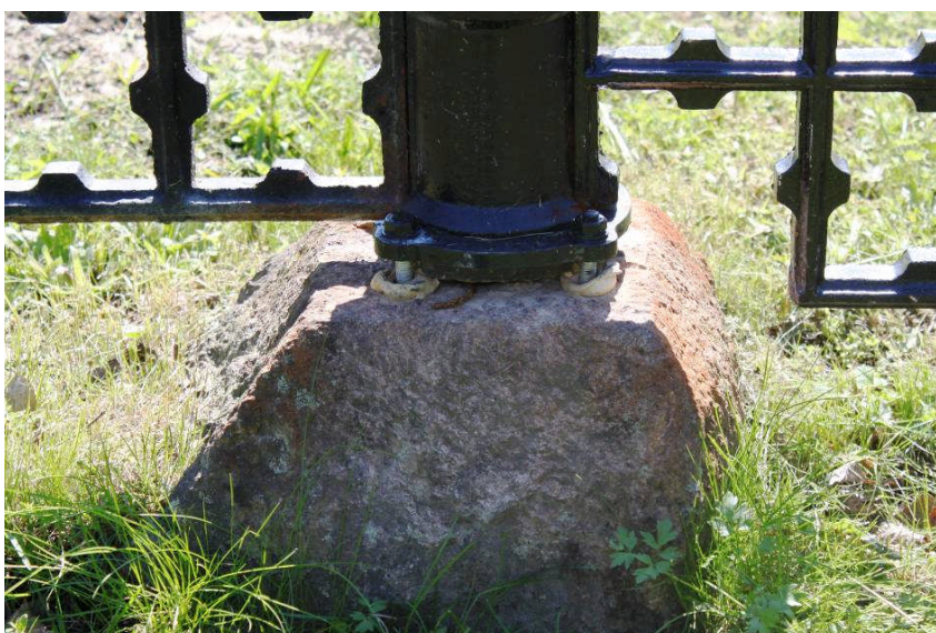
Bild 11. Detaljbild på stolpe som fått ny förankring i stenen. Staketsektionerna som sitter i stolpen har olika höjd eftersom de följer markens lutning.
