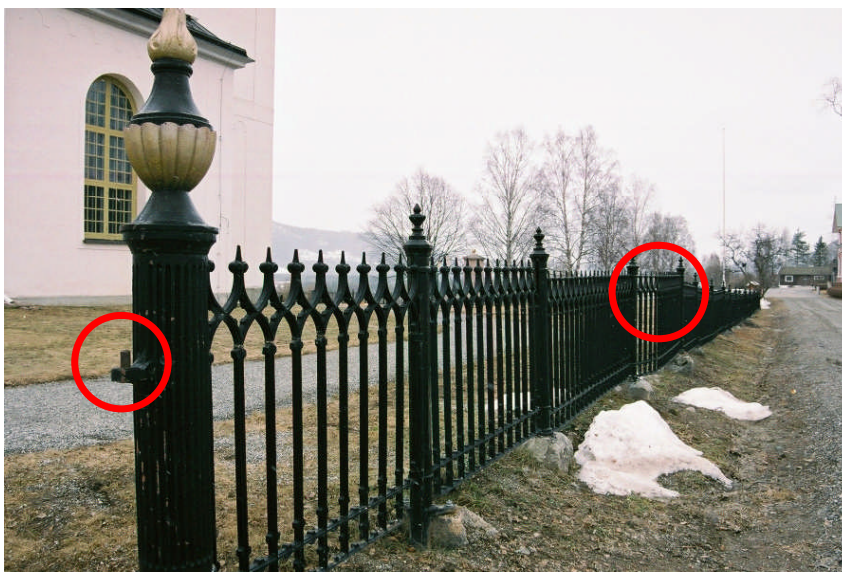
Bild 14. Grinden i grindsektion 2 är nedplockad och tapparna är ännu inte förlängda. Sektion nummer 12:s deformation syns.
