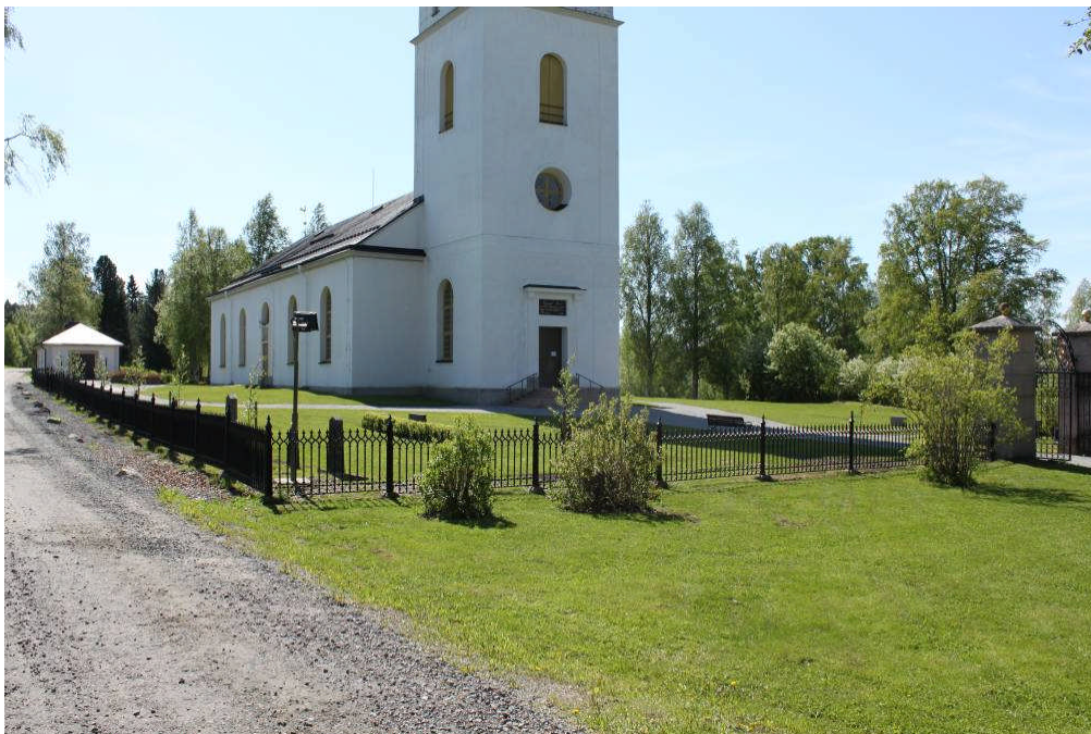
Bild 1. Ragunda nya kyrka efter restaureringen av gjutjärnstaketet. Fotografiet är taget från nordöst. Gjutjärnstaketet omgärdar kyrkogården i öst och norr och i bildens högra kant syns huvudgrinden.
