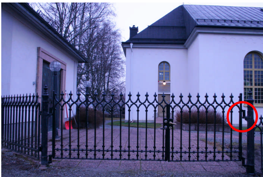
Bild 15. Grindsektion nummer 1 efter restaurering. Grindarna har bytt plats och tapparna förlängts.
