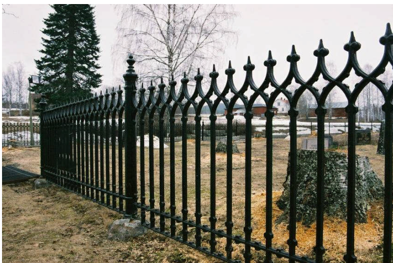
Bild 12. Björkarnas rötter skadade staketet och träden sågades ner och rötterna grävdes upp.
