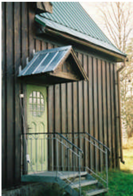
Entrén vid A-vägg fick ny pannplåt (bild nr 04m184/10).
