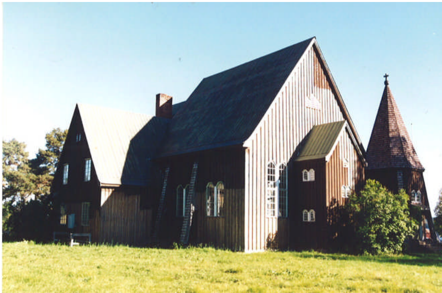
C- och D-vägg (bild nr 02m099/06).
