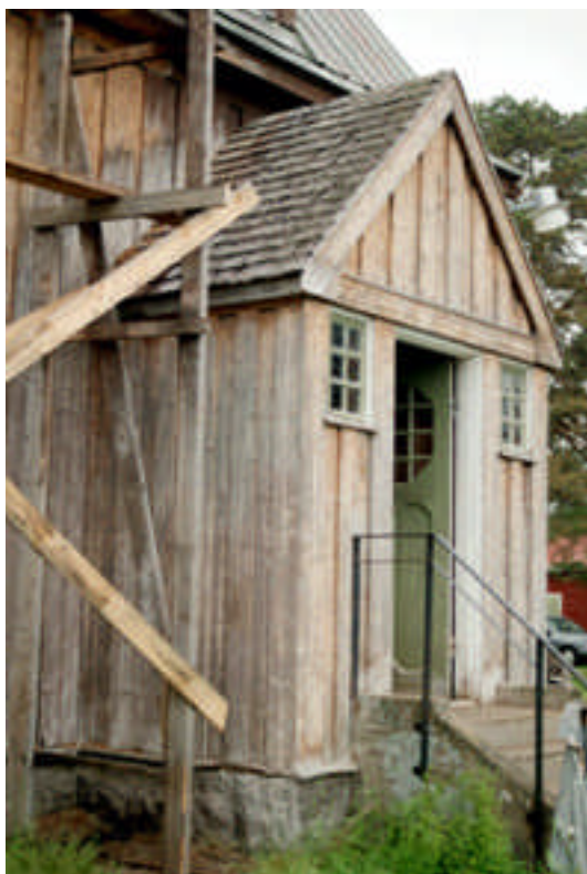
Ingången vid B-vägg vars tak senare lades med pannplåt (bild nr 03m084/04).
