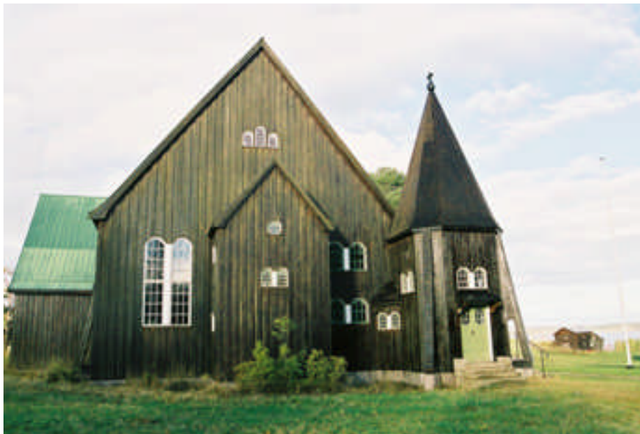
På C-vägg lades nytt spån på skärmtaket över entrén (bild nr 04m184/17).
