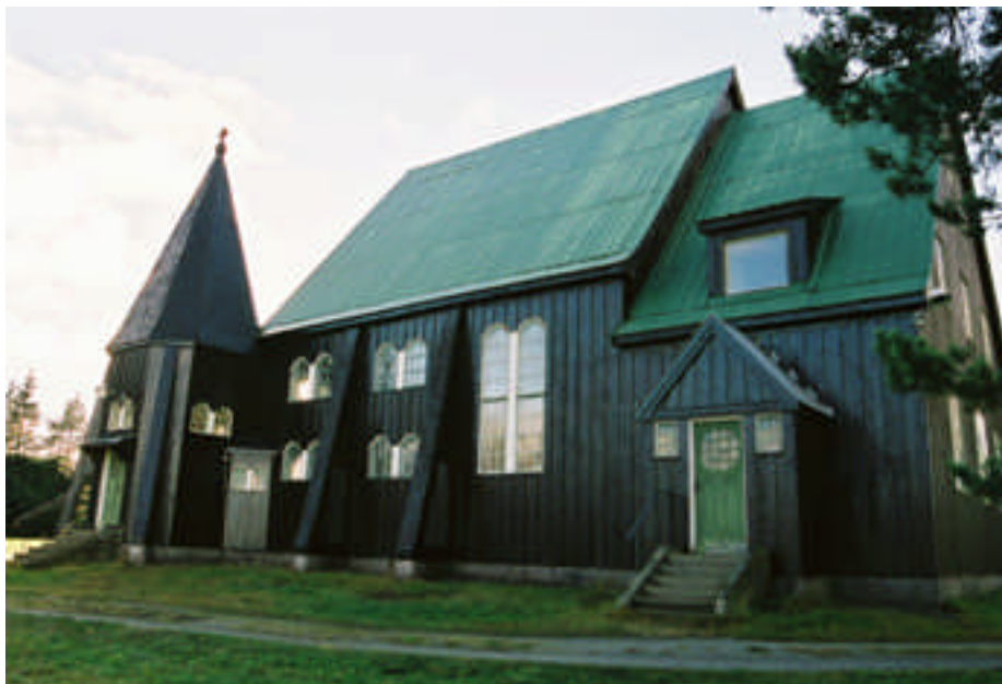
Även den ena entrén vid B-vägg fick ny pannplåt som ersatte spåntaket. Skärmtaket ovan entrén vid tornet fick nytt spåntak istället för plåt (bild nr 04m184/11).
