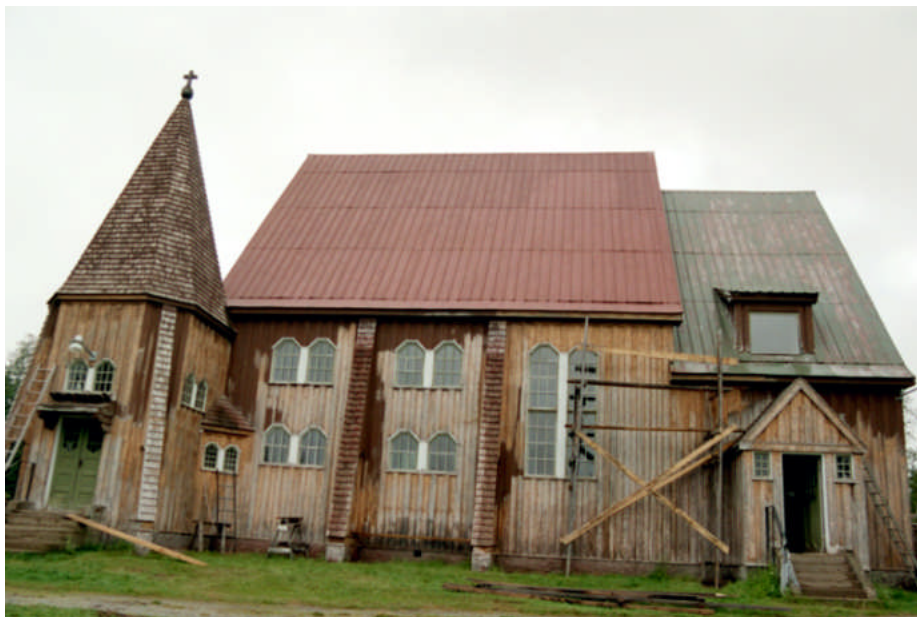
B-vägg efter att taket målats med jämmönja (bild nr 03m084/02).
