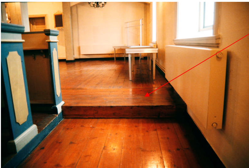
Efter att främsta bänkkvarteret längs mittgången har tagits bort har korgolvet förlängts med plank som löper längs bänkarna. Bilden visar även att det högra/södra bänkkvarteret längst fram i koret är borttaget
