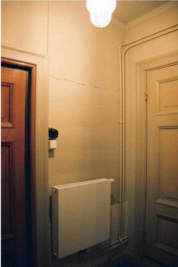
Element i vindfång utanför sakristia (Bild nr Jlm 09m38 -18)
