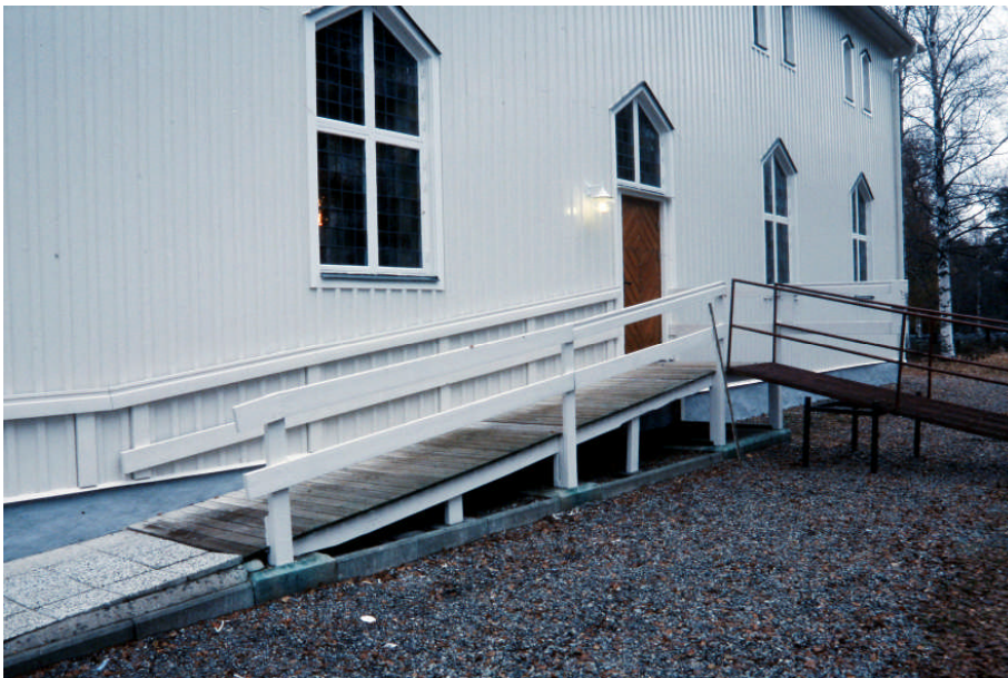
Ramp efter målning. Här syns även den gråmålade sockeln (Bild nr Jlm 09D 0142)
