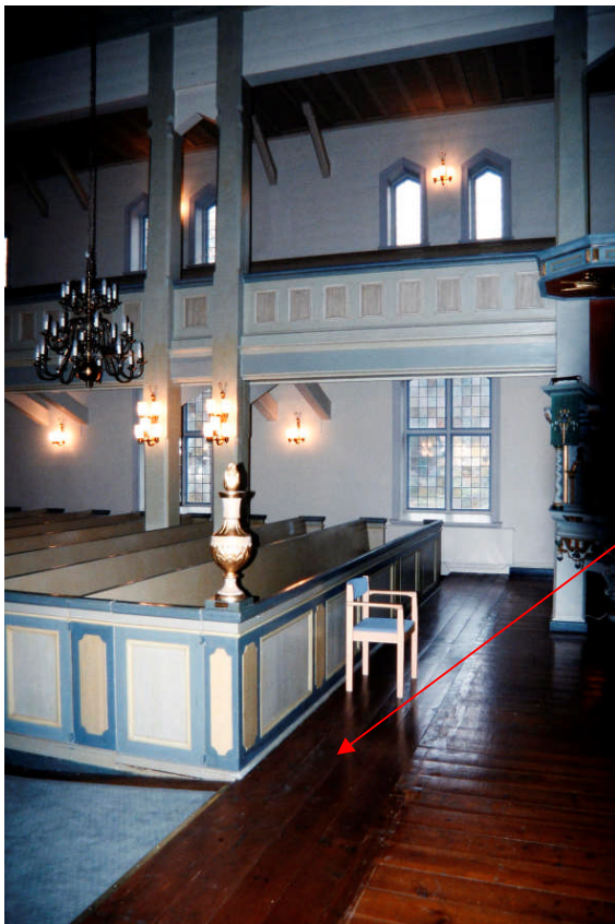
Här syns det fernissade golvet, samt förlängningen av det upphöjda korggolvet (Bild nr Jlm 09D0116)
