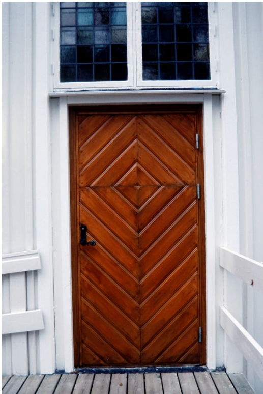
Sidoentré vid handikappramp efter målningsbehandling (Bild nr Jlm 09D0136)
