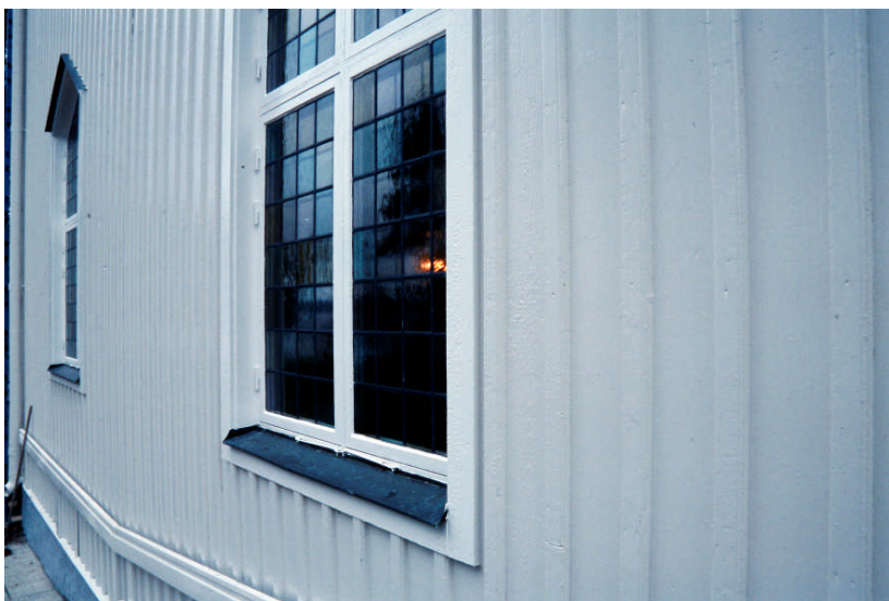
Södra långhusfasaden (Bild nr Jlm 09D0140)
