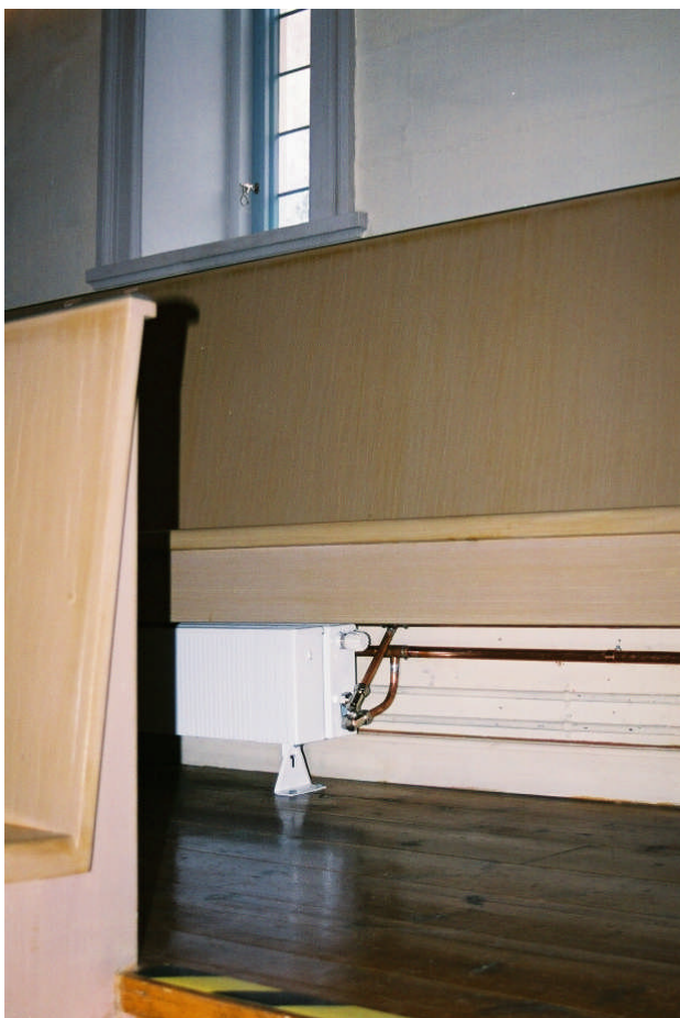
Element under bänk på läktare (Bild nr Jlm 09m38-22)
