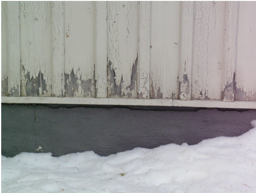
Långhusets nordöstra fasad (Bild från förvaltningsplan)
