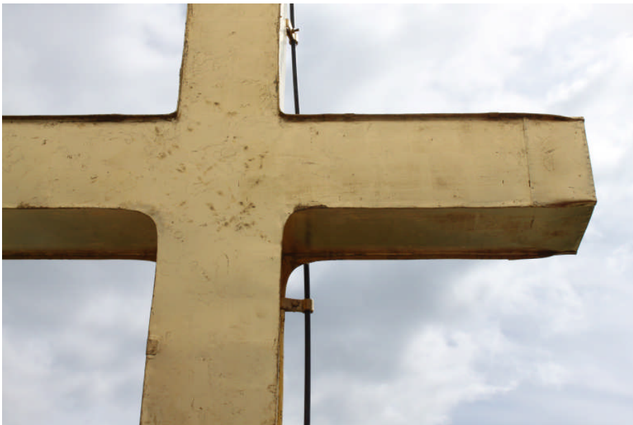
Här syns åskledaren som är monterad i korset
