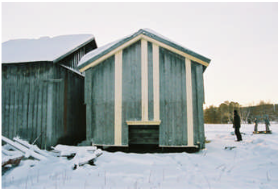
B-vägg efter restaureringen (bild nr 04m172/12).
