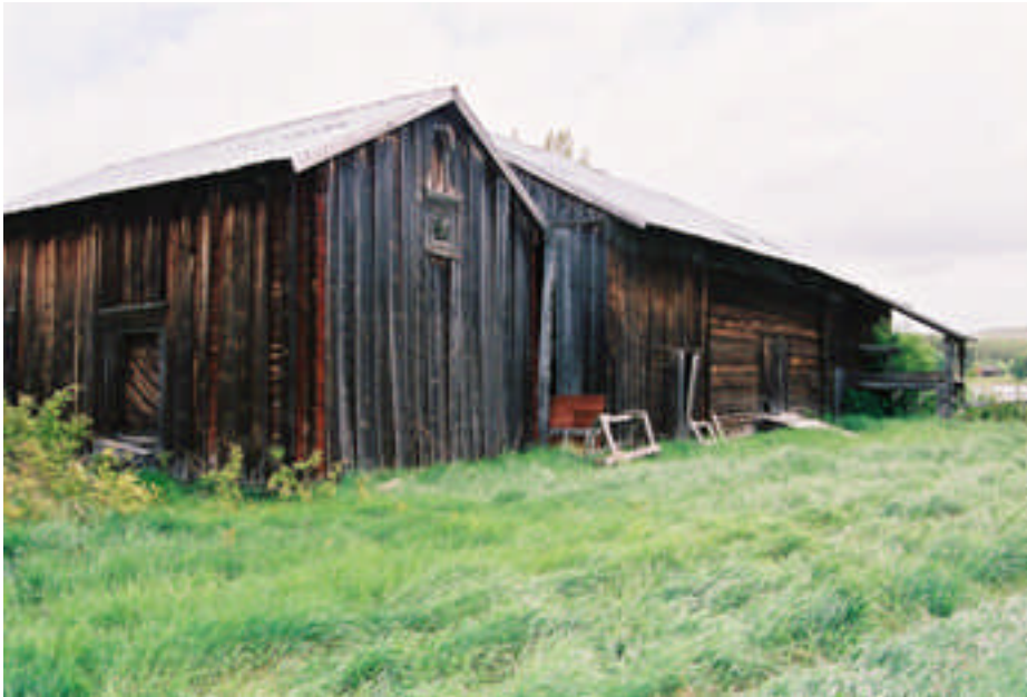
Kornladans D-vägg innan restaurering (bild nr04m 095/24).
