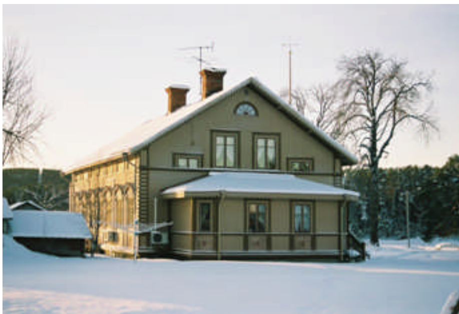
Boningshusets B-vägg efter ommålning (bild nr 04m172/17).
