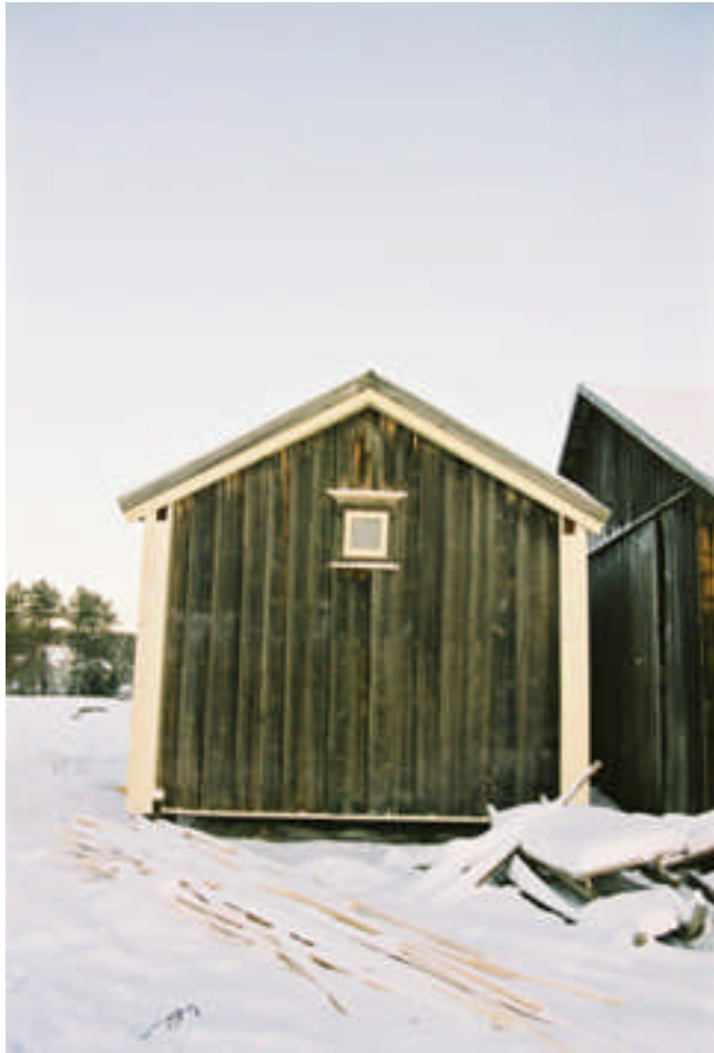
D-vägg efter restaurering (bild nr 04m172/05).
