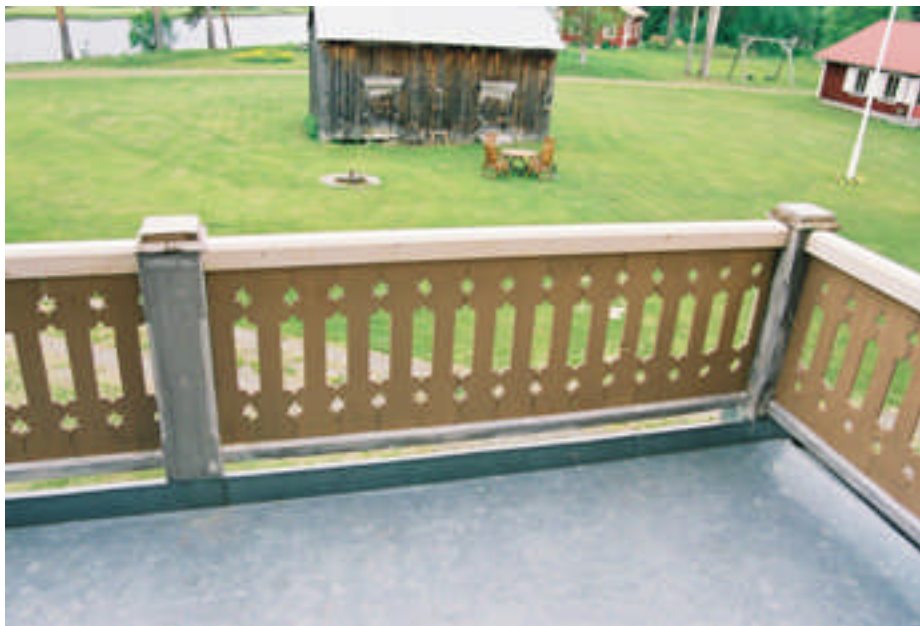
På verandan på A-vägg har tre överliggare bytts i räcket (bild nr 04m095/12).
