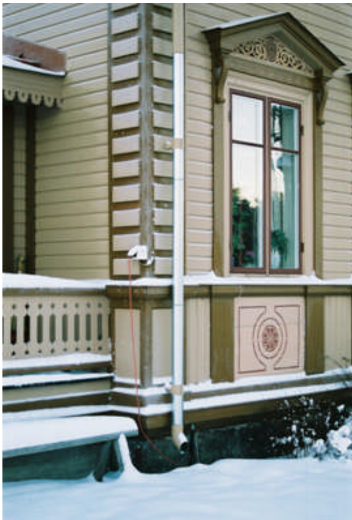
Hömet mellan A- och B-vägg där ”rördelar” bytts. Stupröret har ännu inte målats (bild nr 04m172/19).
