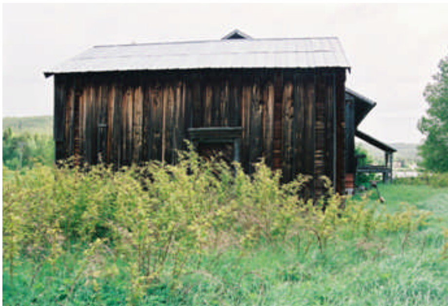
Kornlådans A-vägg innan restaurering (bild nr 04m095/21).
