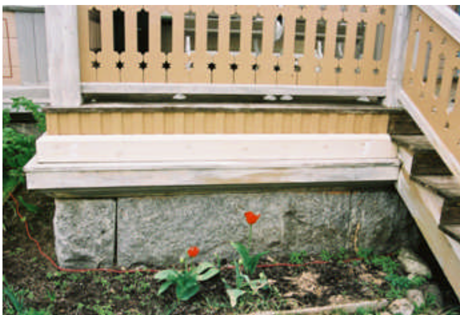
Den bytta listen på verandans nedervåning (bild nr 04m095/19).
