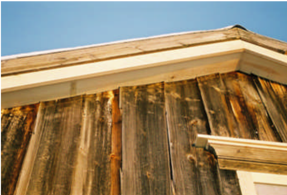
Den inklädda takfoten på D-vägg. På bilden skymtar även den nya fönsterbågen samt dubbla överliggare (bild nr 04m172/15).
