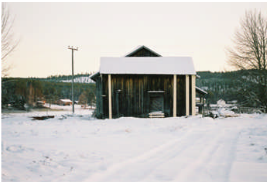
A-väggen har kompletterats med panel och en ny trappa (bild nr 04m172/04).
