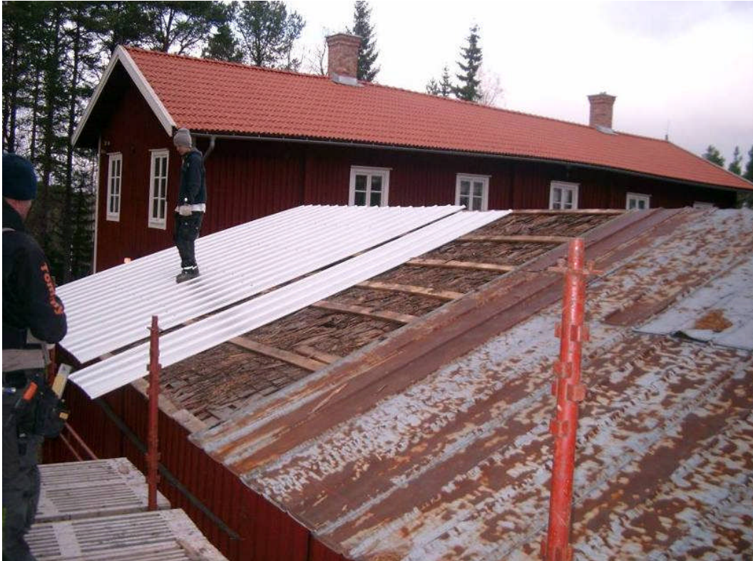
Bild 15. Efter arbetet med tegeltaket påbörjades ekonomibygnadens restaurering där pannplåt byts ut. Under syns att täckningen tidigare varit av spån.
