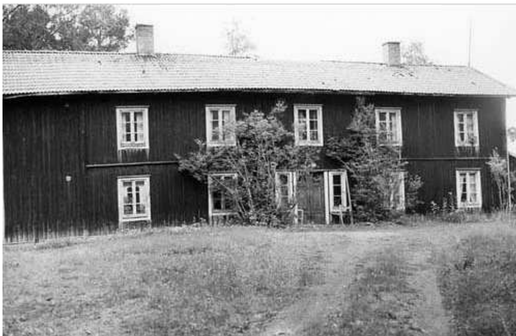
Bild 1. Äldre foto på arbetarbostaden från Jämtlis bildarkiv visar att taket sedan länge varit klätt med tegel.
