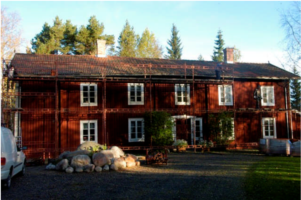
Bild 6. Bostadshuset innan restaureringen när arbetsställningarna är på väg att monteras upp.
