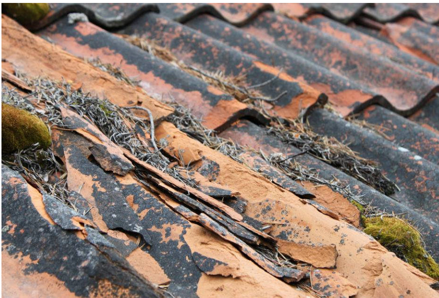
Bild 2. Teglet på arbetarbostadens södra takfall var sprucket och bitar flagade.
