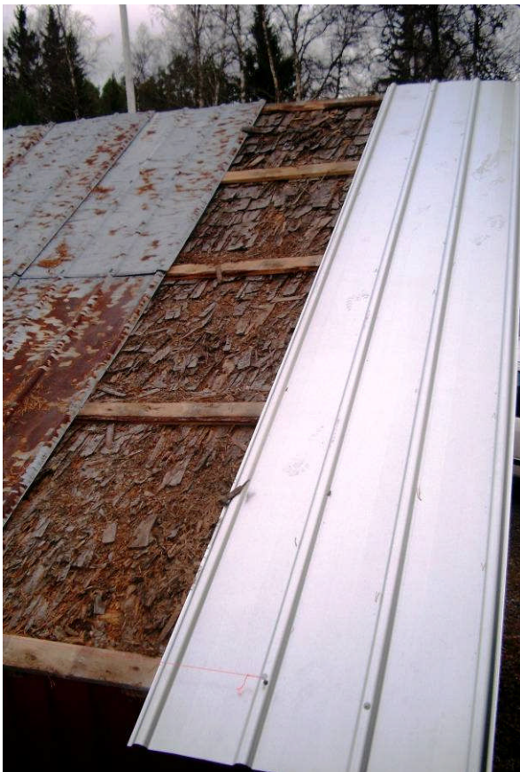
Bild 16. Pannplåt med samma profil som innan användes.
