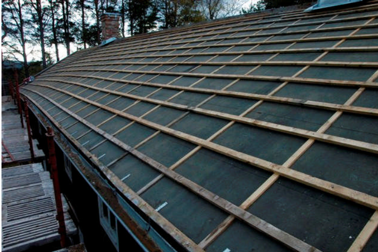
Bild 9. Den frilagda takytan rengjordes och trasig läkt lagades.
