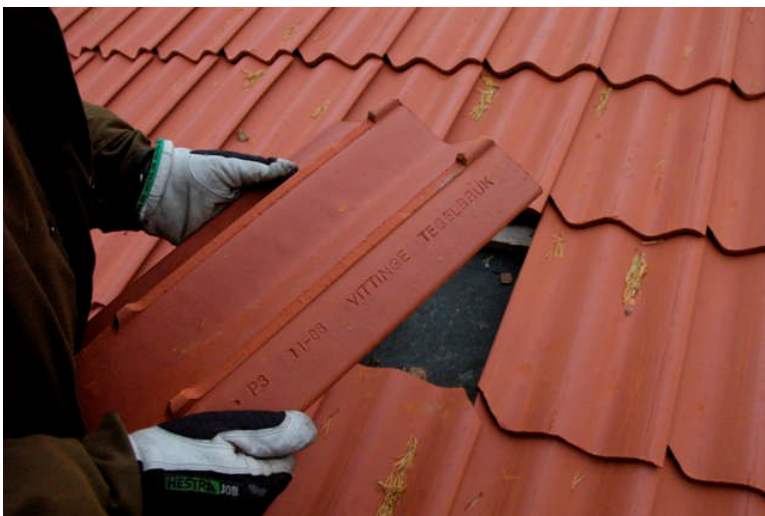
Bild 13. Det tvåkupiga teglet kommer från Vittinge.
