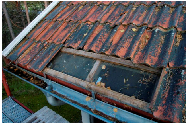
Bild 8. Teglet plockades bort och under ligger papp och på detta strö-och bärläkt.
