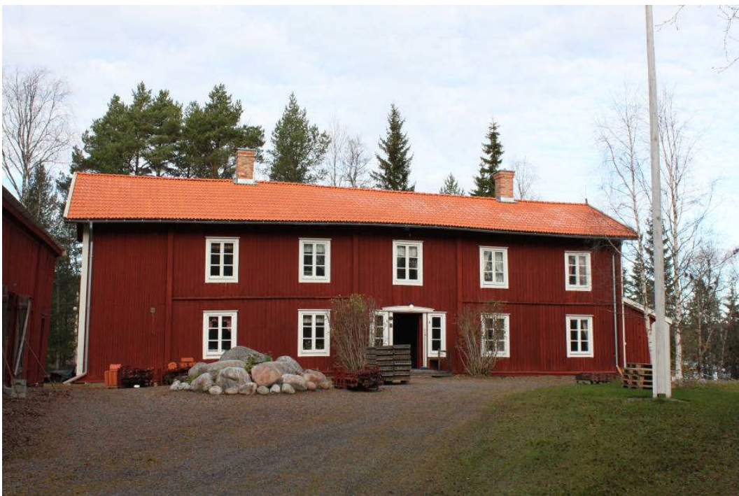
Bild 14. Arbetarbostaden efter restaureringen.
