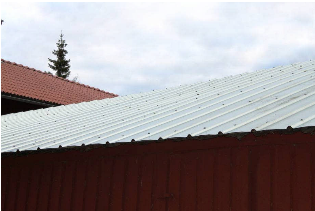
Bild 18. Restaureringen är färdig. Spikarna sattes genom pannplåtens profiltoppar.
