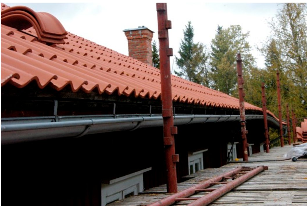
Bild 11. Taket börjar bli klart mennockpannorna ska läggas upp. Takpannorna sticker ut en aning ovanför takfotsbrädan, enligt traditionellt vis.
