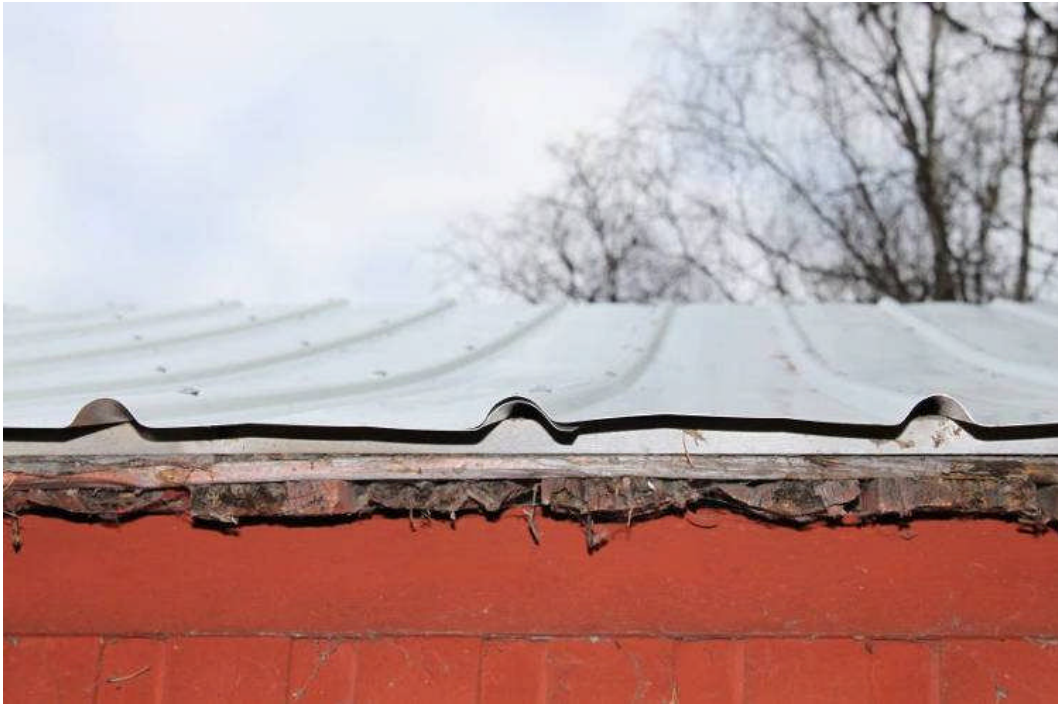
Bild 17. Det underliggande spåntaket bevarades.
