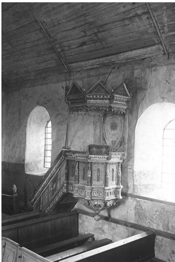
Bild ur Jamtlis arkiv. Fotografiet är med stor sannolikhet taget inför restaureringen av kyrkan på 1920-talet. Här kan vi se att färgskikten på denna takyta nästan är helt borta. Spåren efter de blågrå banden går att tyda.
