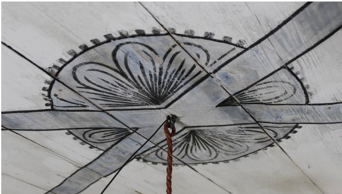
Takrosettens runda form har blivit ifylld samt de diagonala linjerna vid kryssbanden. Blombladen och ringens sågtandade fris har man låtit vara.
