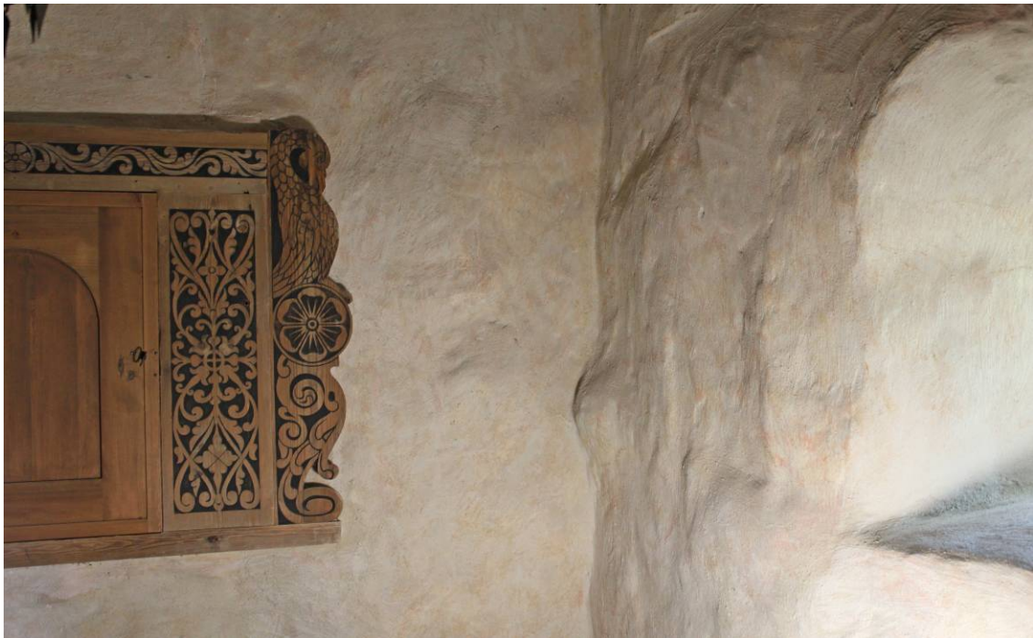
Putslagning är retuscherad med kalkfärg lika övriga väggpartier, norra innerväggen
