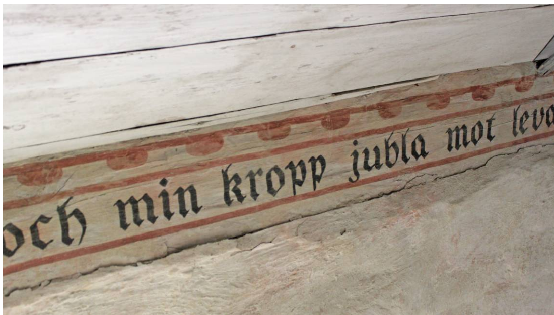
Träfris som löper runt innertakets nederkant. Färgskikten har konsoliderats med gelatin och vatten. Åtgärden är utförd men syns inte för blotta ögat.
