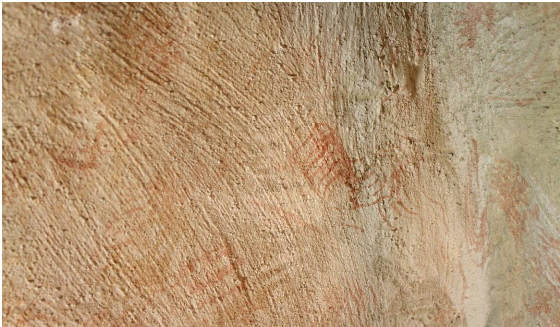
Här ser vi den kvastade putsytan. Kalkavfärgningen är gjord med våtsläckt Kulekalk.
