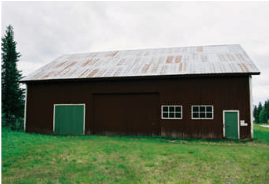
Ladugårdens östra vägg innan åtgärd (bild nr 04m098/25).
