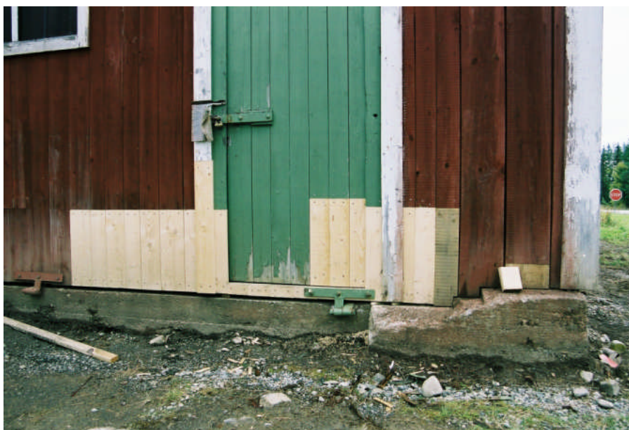
Ilagningar vid enkeldörren vid den östra väggen (bild nr 04m131/21).
