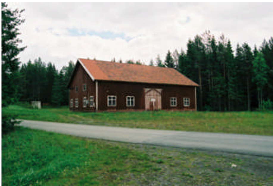
Byggnad 168, ”bostadshuset” innan restaurering (bild nr 04m098/22).
