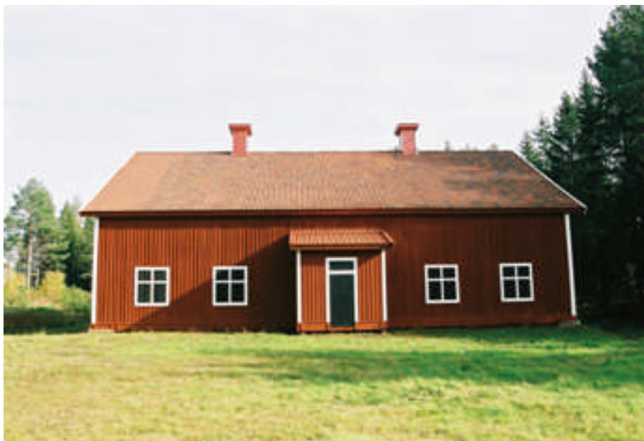
Den västra fasaden efter ommålning (bild nr 05m214/30).
