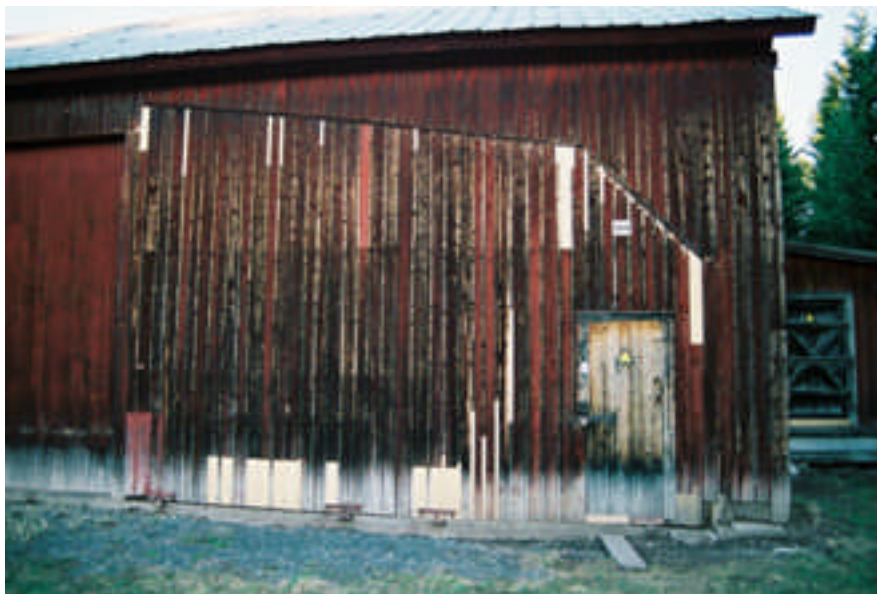
Ilagningar i panelen vid den fällbara södra väggen (bild nr 04m158/06).
