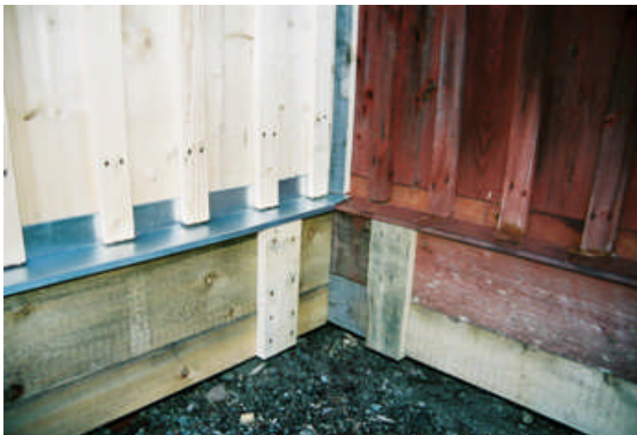
En galvad plåt lades längs sockeln på utbyggnaden (bild nr 04m159/33).
