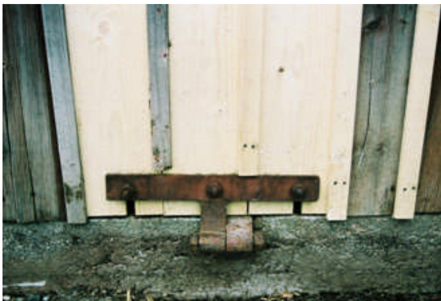
Brädoma fick träs över gångjärnens bultar (bild nr 04m131/18).
