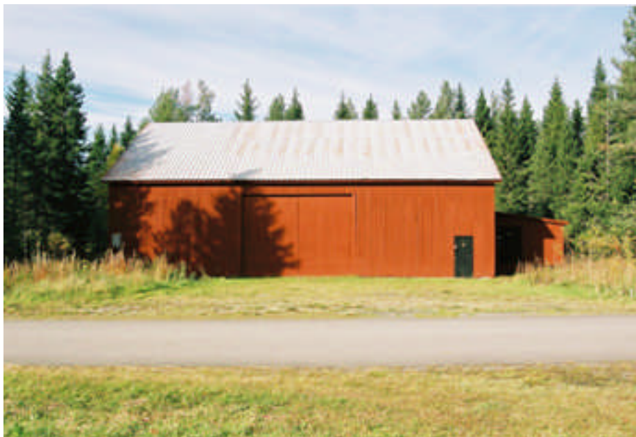
Ladans södra fasad efter ommålning (bild nr 05m214/31).
