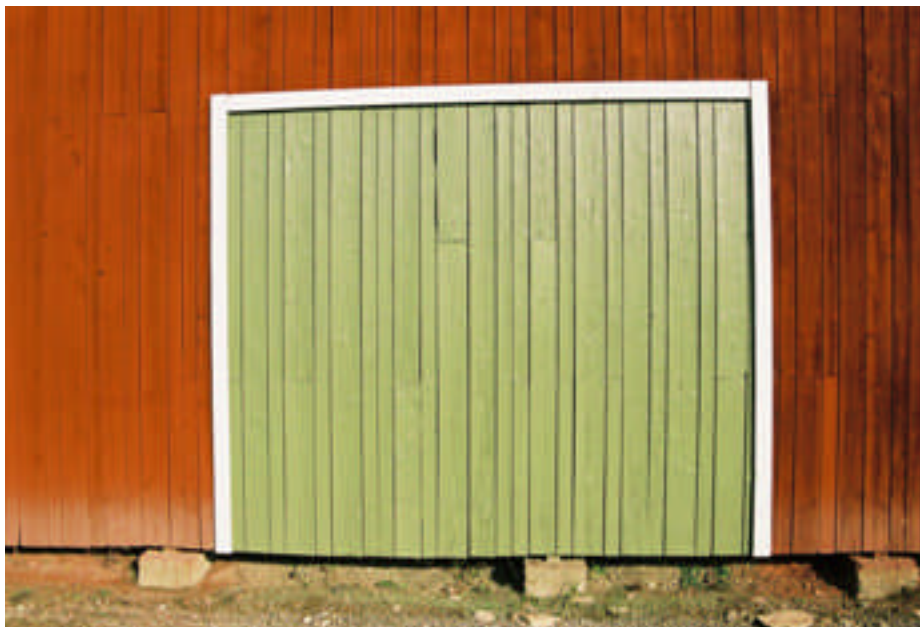
Blindporten på den västra fasaden efter ommålning (bild nr 05m214/35).
