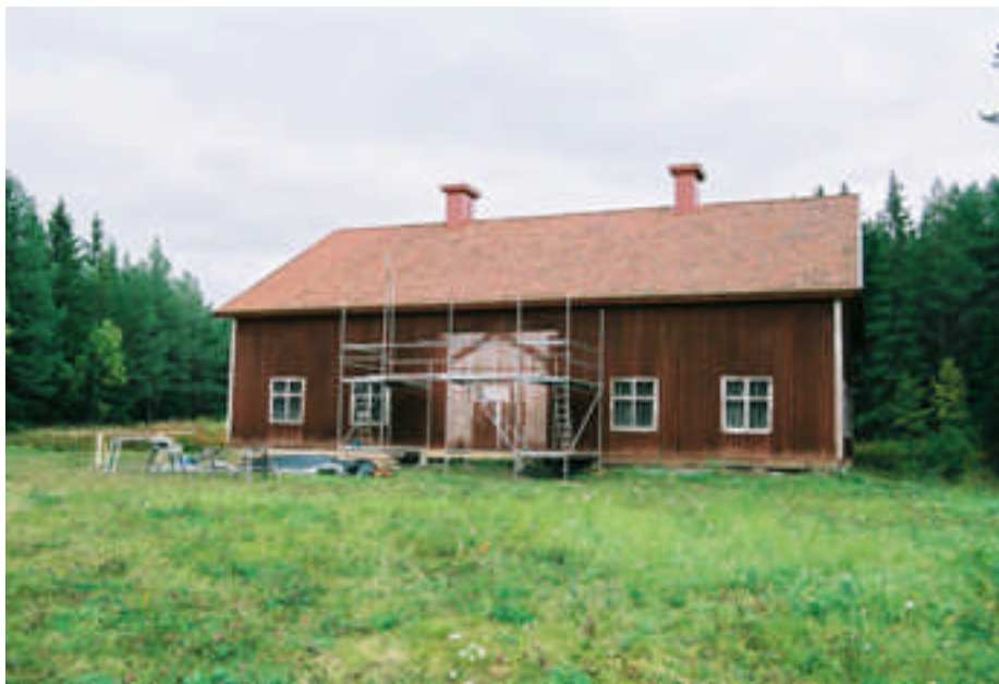
Nya skorstenar och ett nytt entréparti uppfördes på "bostadshusets" västra vägg (bild nr 04m131/34).
