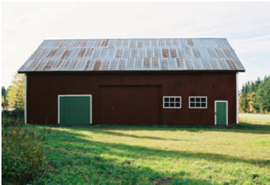
Den östra fasaden efter ommålning (bild nr 05m214/32).
