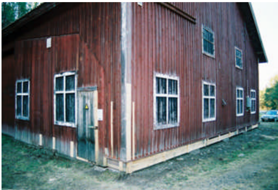
Norra gavelväggen på byggnad 168 efter att en stor del av bräderna i sockeln hade bytts. Runt dörren på östra väggen byttes också en del rötskadad panel (bild nr 04m158/01).
