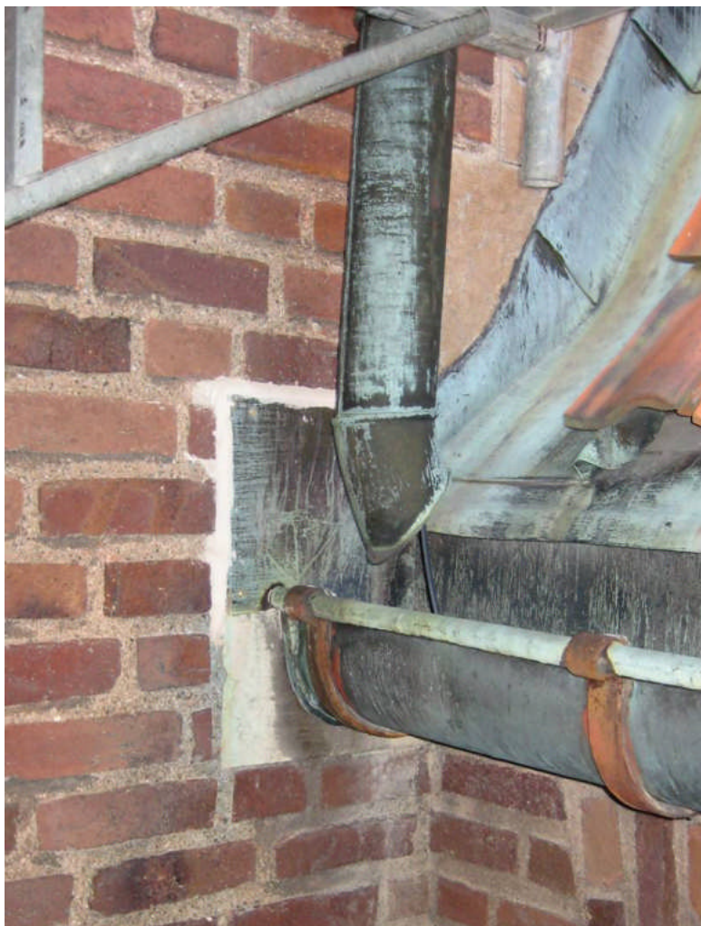
Bild 13. Stuprör, hängrännor, rännalar, bleck är tillverkade av kopparplåt. Hängrännorna bärs upp av konsoler av järn och det ligger bly mellan järn och koppar.
