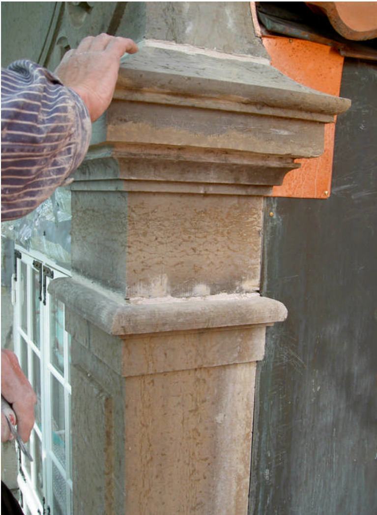
Bild 22. Ny fog av kalkbruk och ilagringar med kalkstenslagningsbruk i underkant av sten utförd.
