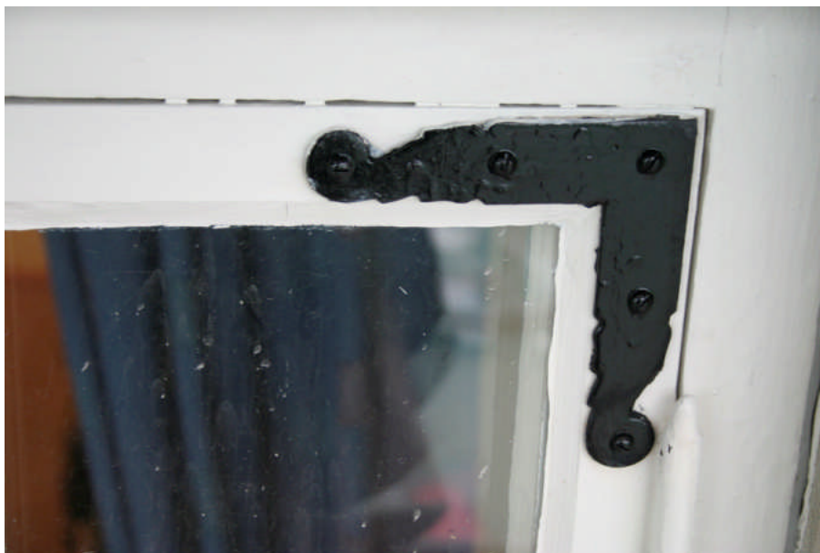
Bild 15. Närbild på fönsterbåge och svartmålade vinkeljärn.
