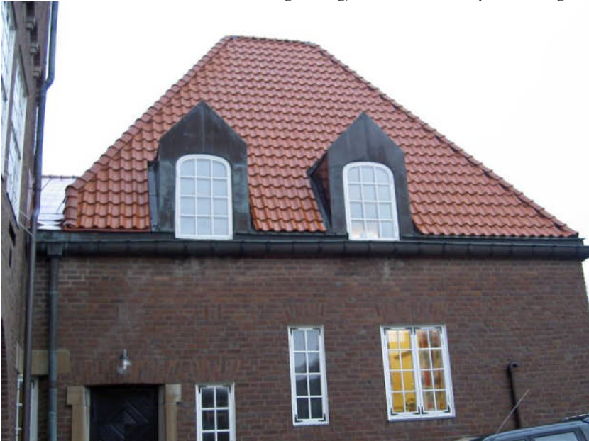
Bild 25. På norra lågflygeln fanns inga större skador. En översyn av hängrännor, stuprör och fönster gjordes.
