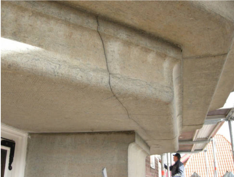
Bild 3. Större spräckor i stenkonsoler och här på burspråket mot öster dubbades med rostfri dubb.
