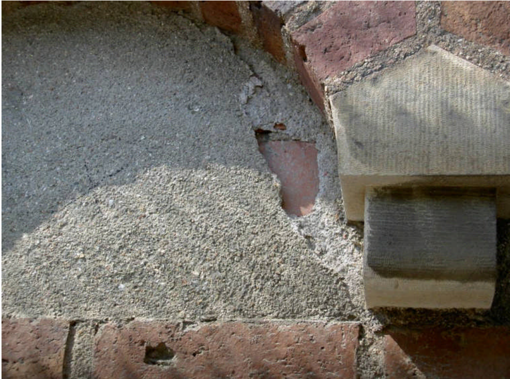
Bild 9. Skadad puts i anslutning till en konsol i den bågformade frisen.
