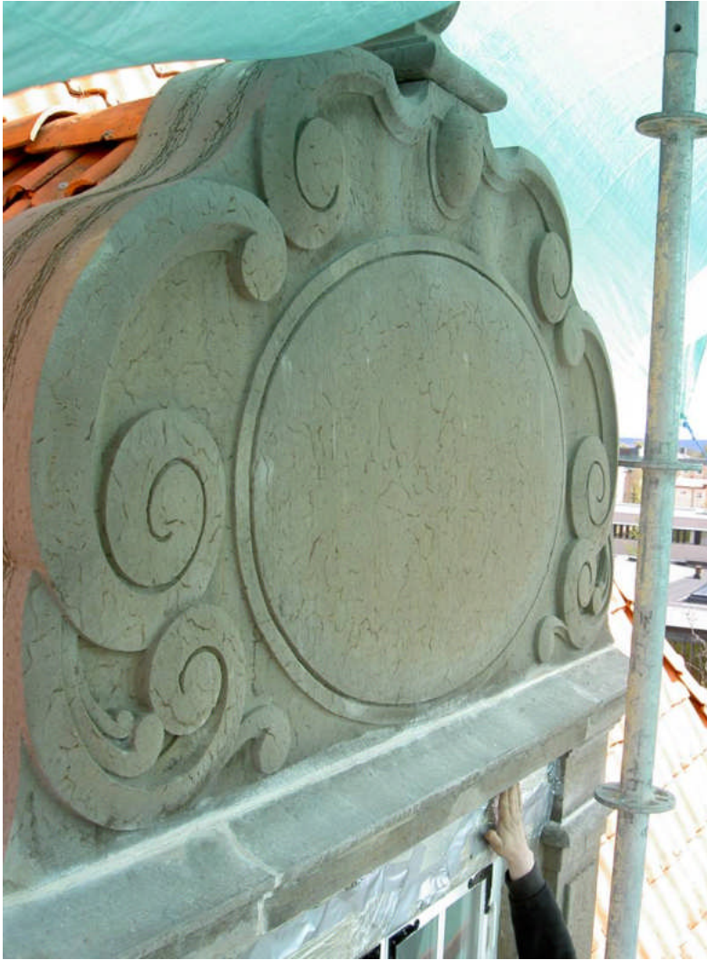
Bild 4. Takkuporna på högflyglarna kröns av en fronton i kalksten. På dessa fanns mossa och smuts, krustbildning, sprickor och materialförluster.
