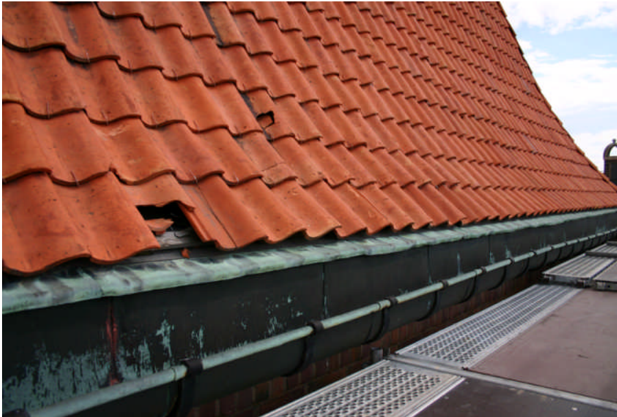
Bild 16. Skadat taktegel som gick att komma åt i anslutning till byggnadsställningarna byttes.
