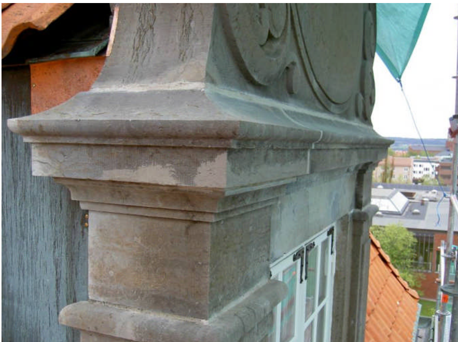
Bild 5. Fogarna mellan kalkstenarna hade vittrat och på vissa ställen ersatts av silikonfogar. Dessa togs bort och ersattes med kalkbruk. Materialförluster och sprickor ilagades med kalkstenlagningsbruk.
