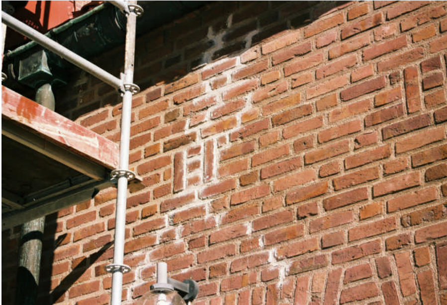
Bild 11. På norra högflygelns fasad fanns i anslutning till hängrännan missfärgningar orsakat av läckage.
