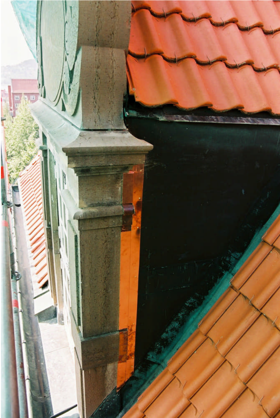
Bild 18. Samma takkupa efter åtgärd. En kompletterande plåtlist av koppar sattes runt hörnet på stenfronten för att förhindra inträngning av vatten och undvika lagningar med moderna material såsom gummiliknande massor.
