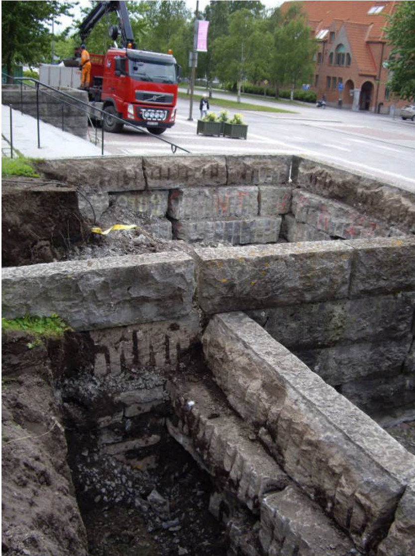
Det ena utskjutande partiet på den västra sidan efter att jorden bakom stenarna har tagits bort (foto Östersunds kommun, IMG1960).
