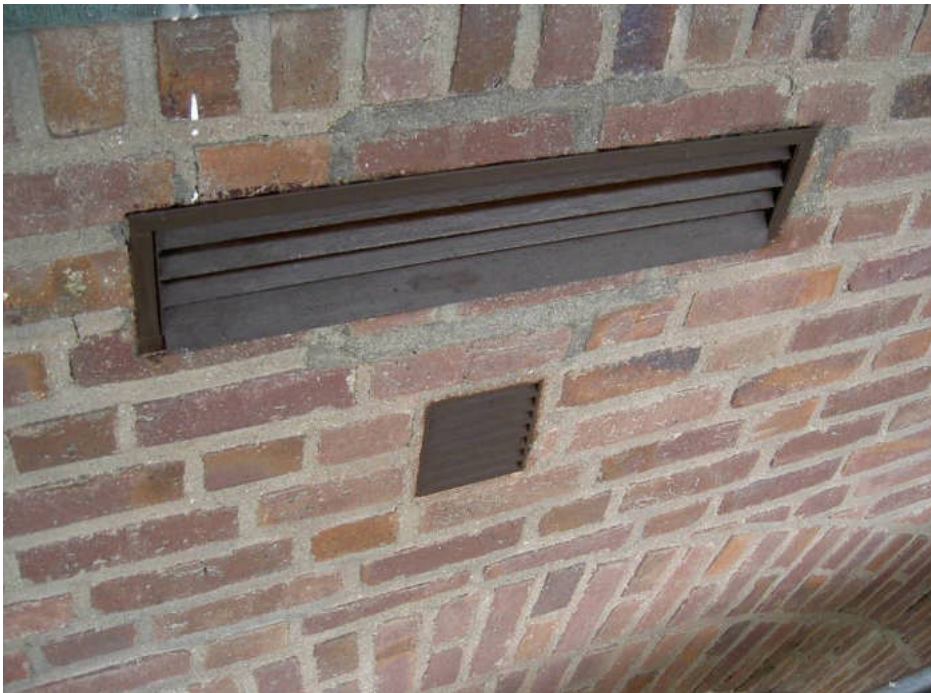
Bild 6. Ventilationsgaller i järn finns på olika ställen på fasaderna.
