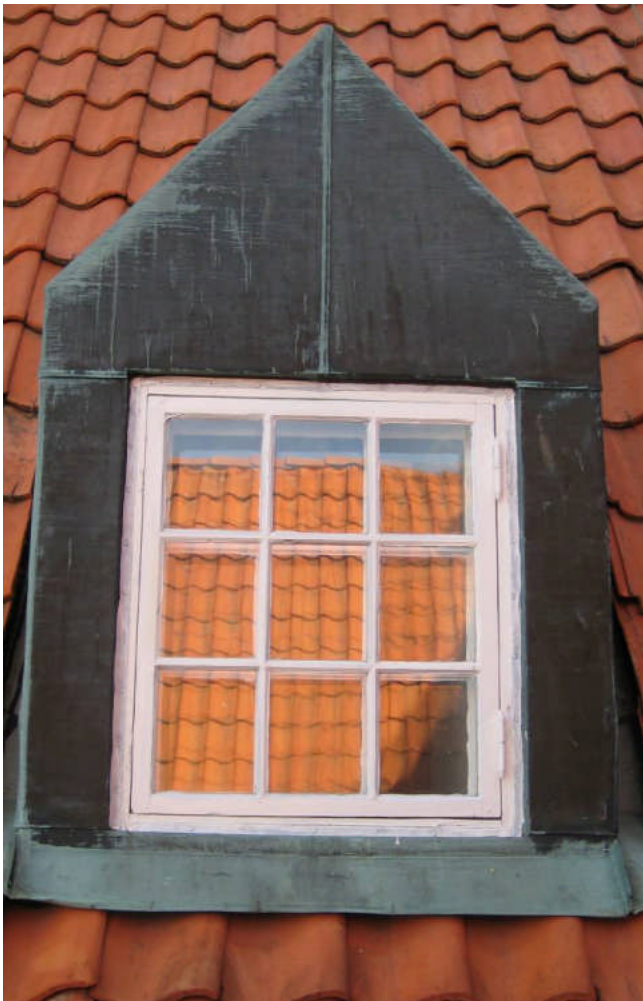
Bild 20. En av takkuporna som är täckta av kopparplåt.
