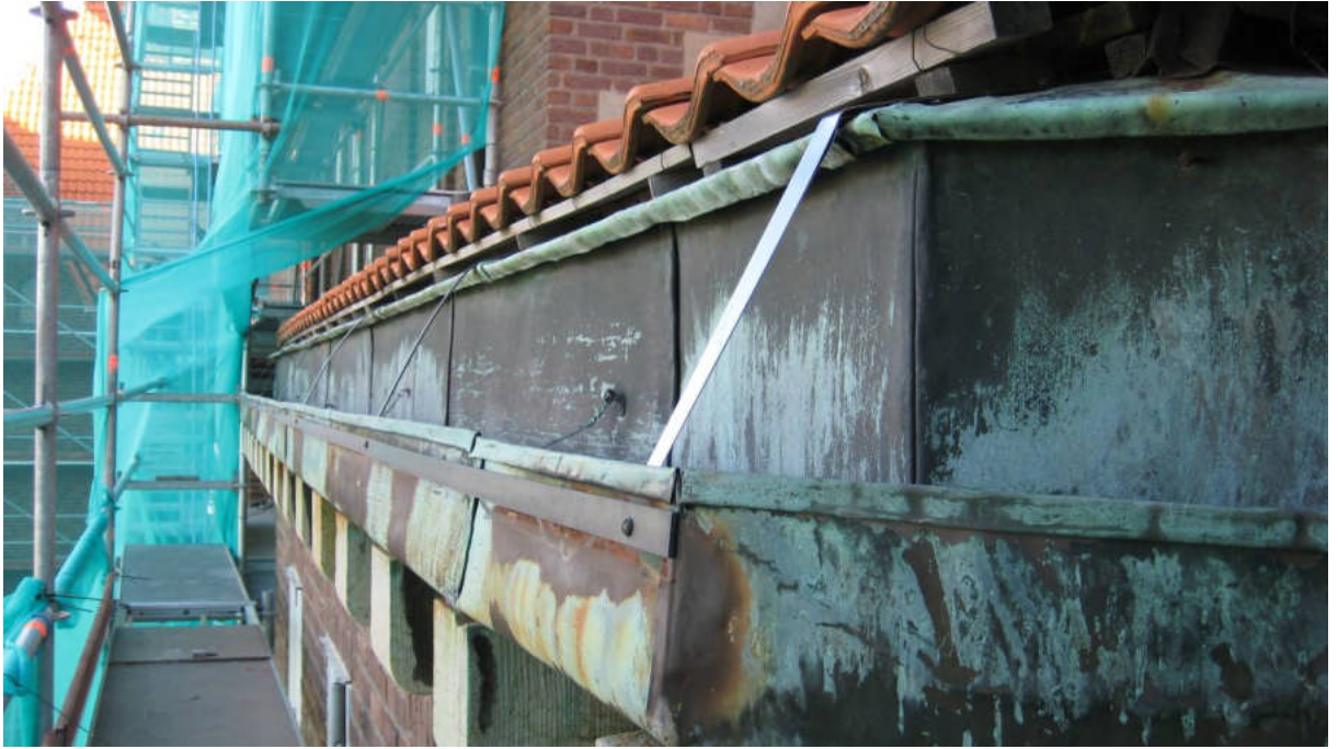
Bild 19. Komplettering med ett fäste av rostfritt stål vid rännan på huvudfasaden mot väster.
