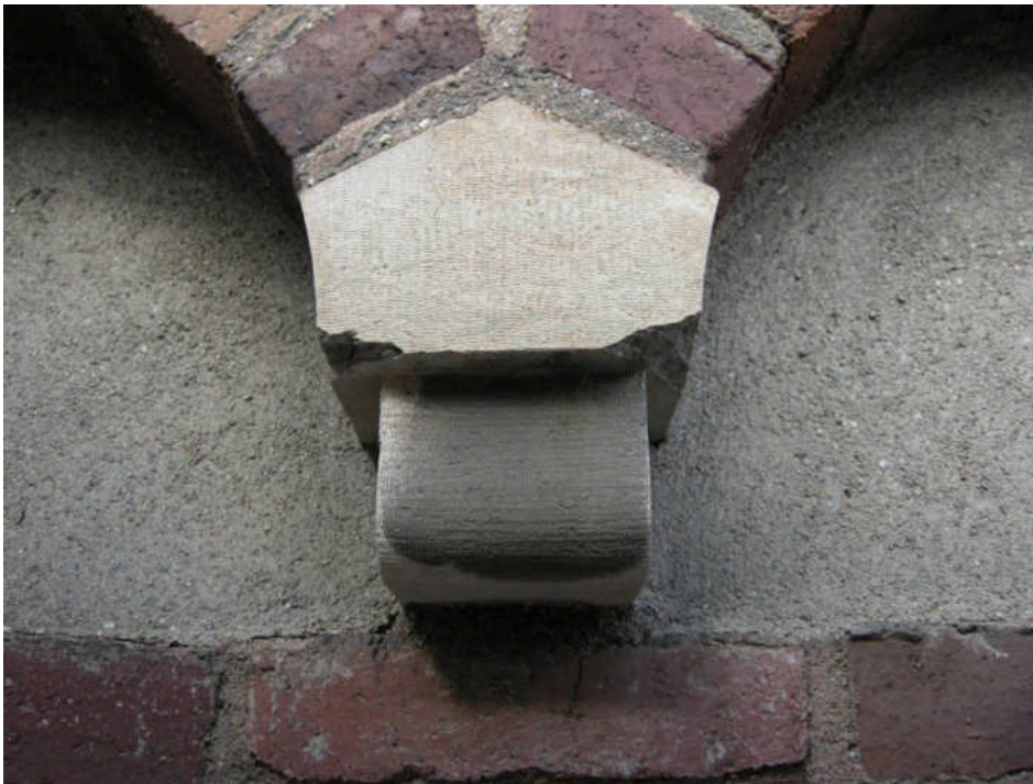
Bild 2. En av konsolerna i den bågformade frisen. En typisk skada var bortfall av sten på hörnen och sprickor.
