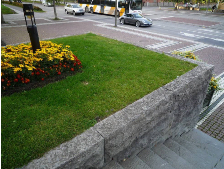
Ett av de utskjutande partierna vid trappan, efter åtgärd (digital bild nr P1020469).
