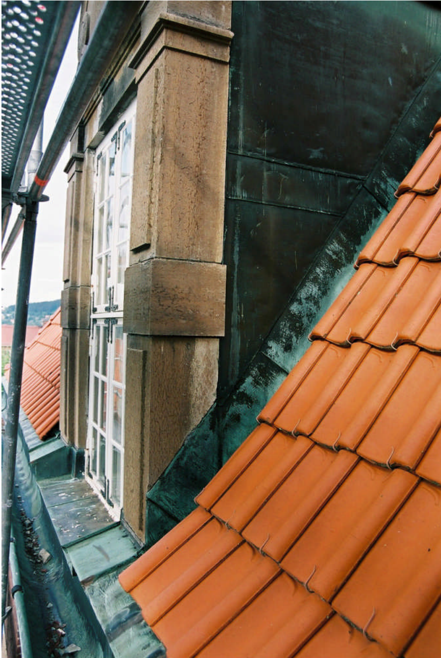
Bild 17. Takkupa på södra fasaden innan åtgärd.
