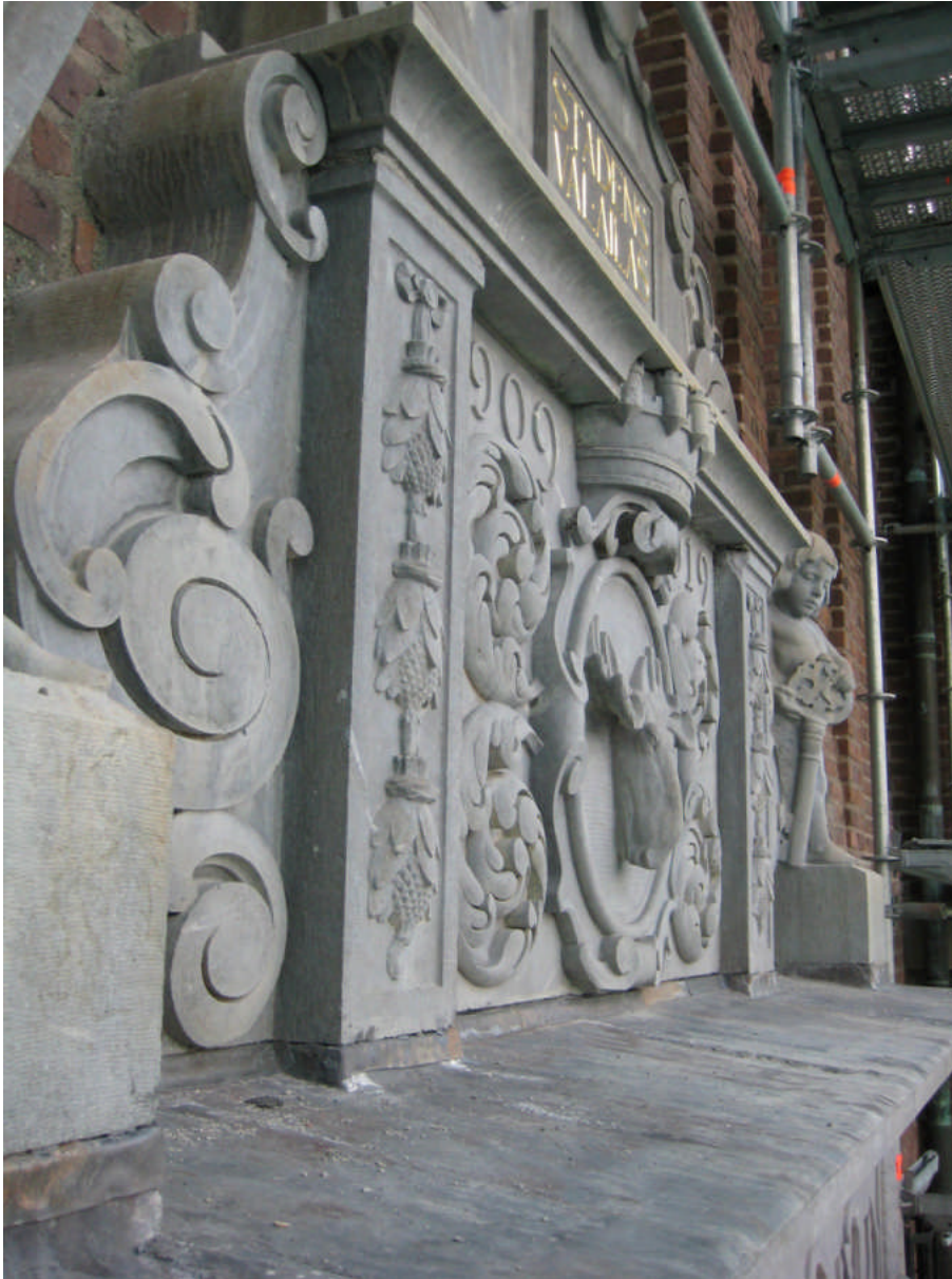
Bild 21. Figurfrišen ovanför huvudentrén. Portalomfattningens listverk täcks av en blyplåt som hade glidit fram. En kompletterande plåt drevs in med bly för att täta vilket syns på bilden.
