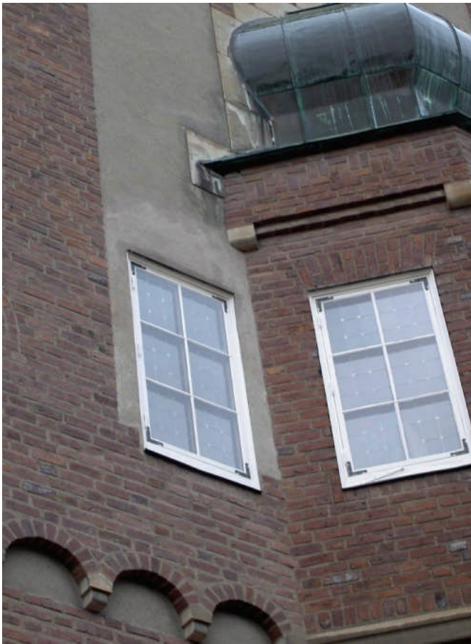
Bild 24. Ilagningar med nytt bruk runt fönster på östra fasaden.
