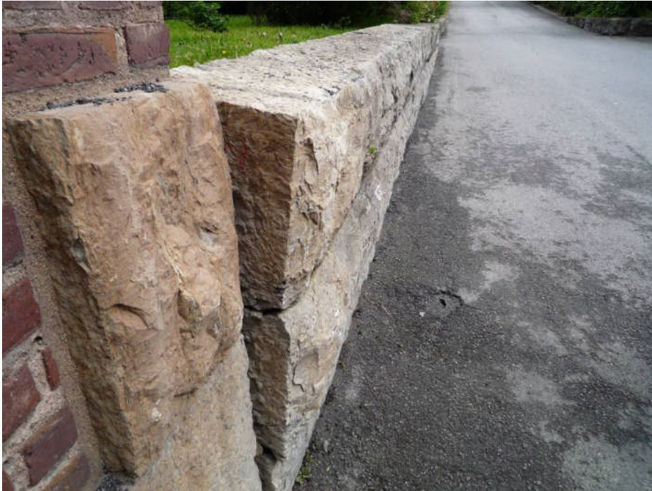
Mur på den östra sidan som lutar kraftigt utåt (digital bild nr P1010078).
