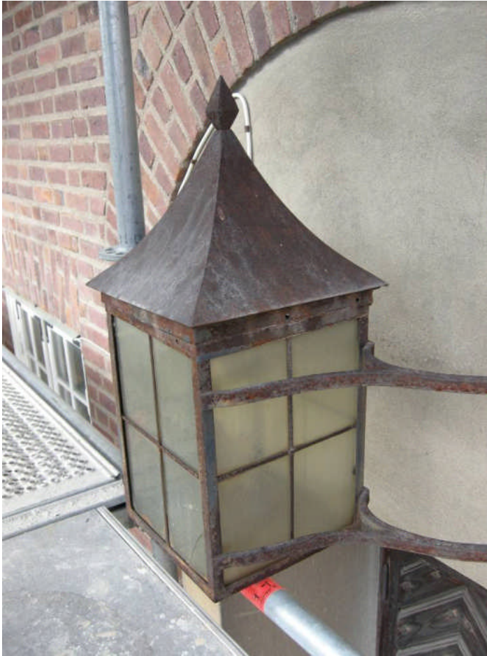
Bild 7. Armatur på östra fasaden i smide innan åtgärd. Rostskyddsbehandling gjordes med rå linolja pigmenterad med bränd terra och brun umbra.
