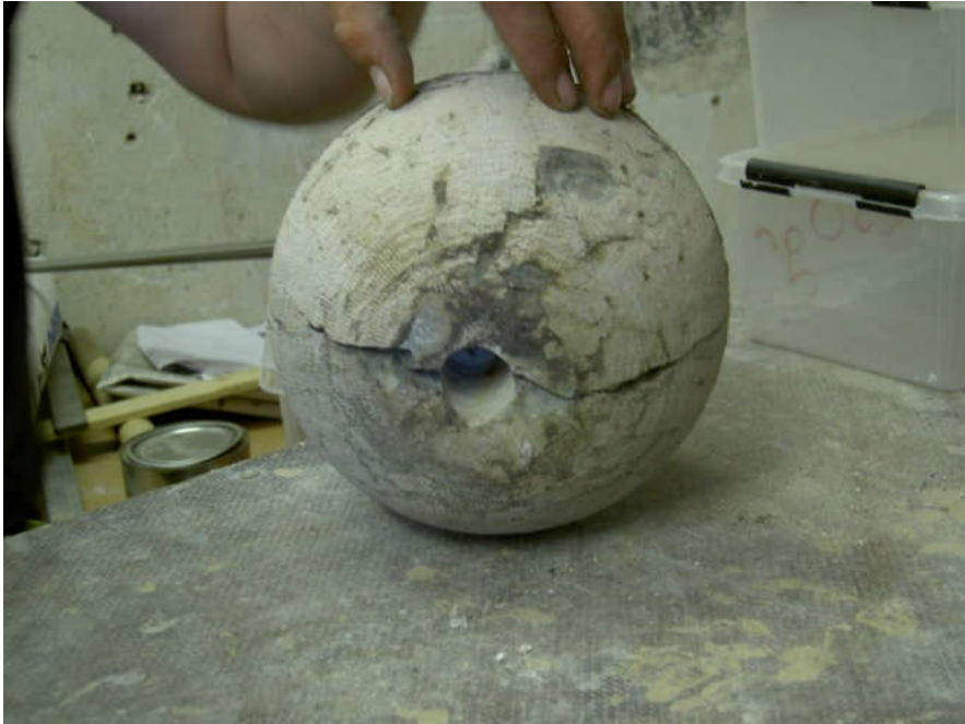
Bild 26. En av kulorna på skorstensbågarna var halv och togs därför ner vid besiktningen från skylift. Den andra halvan hittades under arbetet med att åtgärda skorstenarna och kunde således dubbas, limmas ihop och återanvändas.
