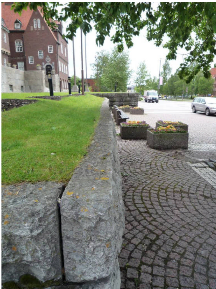
Muren i väster, juni 2009. Stora mellanrum fanns mellan stenarna och de låg mycket ojämnt (digital bild nr 1010079).
