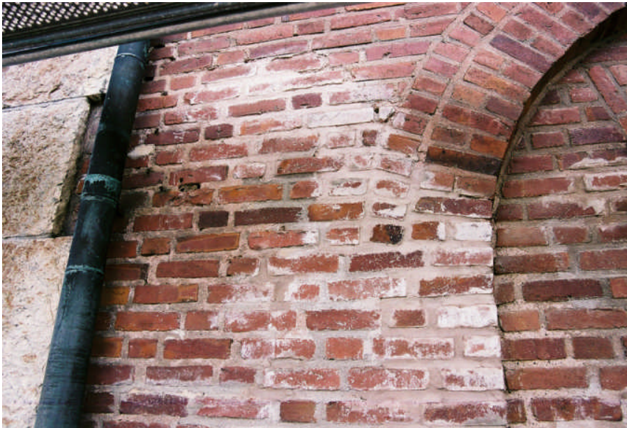
Bild 12. På västra fasaden på södra högflygelns fanns missfärgningar på tegel och fogbruk orsakat av läckande stuprör. Omfogning utfördes men missfärgningarna på teglet tvättades inte bort.
