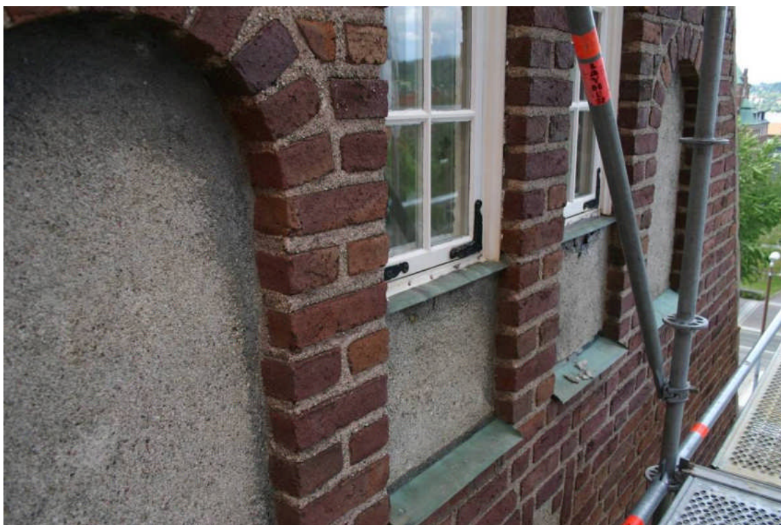
Bild 8. Putsen i nischerna hade framförallt skador i anslutning till plåtbleck och fönsteröppningar.
