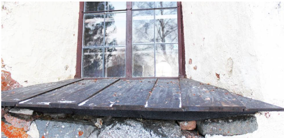
Ny solbänk på södra långväggen.
