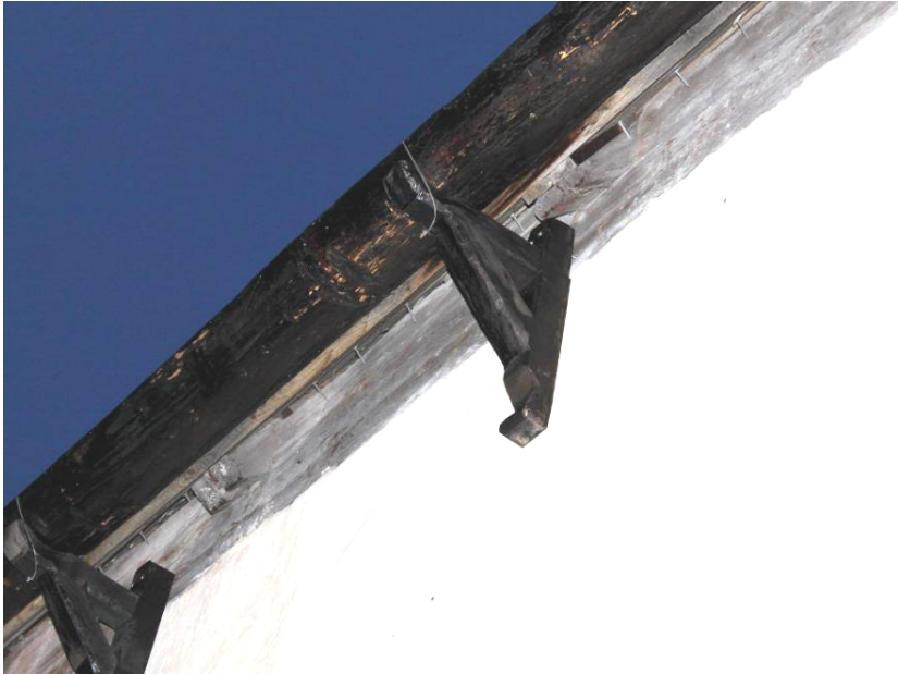
En av de nya hängrännorna med konsoler fästa i hammarbandet.
