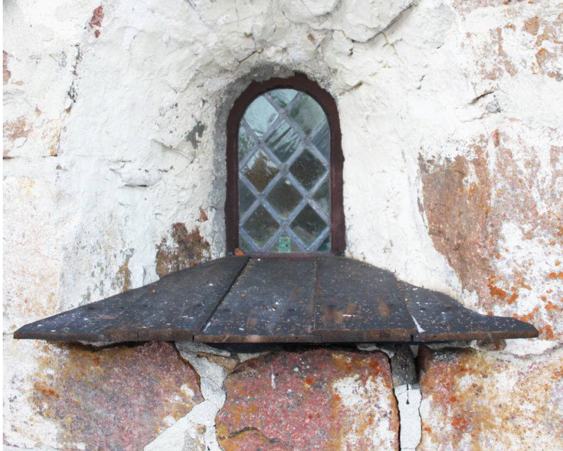
Sakristians fönster målat och med ny solbänk.
