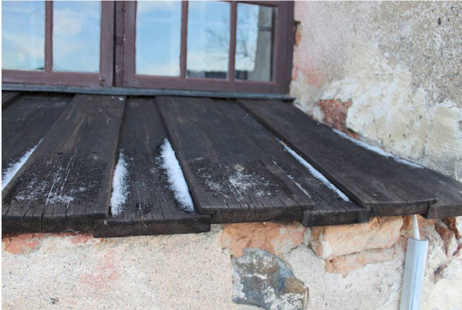
Detalj av den äldre solbänken.
