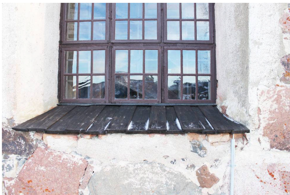
Den äldre solbänken av trä på västra gaveln som varit förebild för de nya solbänkarna.
