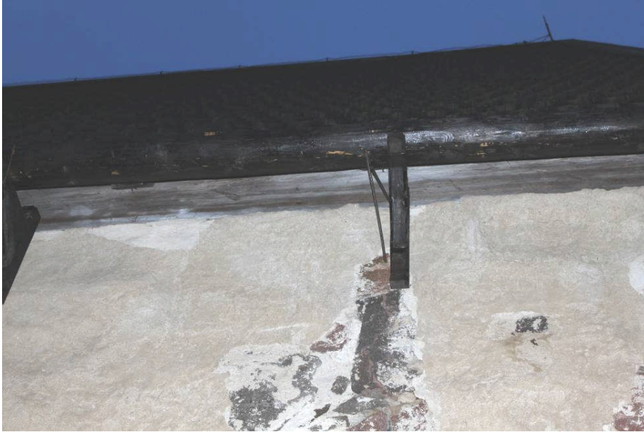
En äldre konsol av järn har fått sitta kvar.
