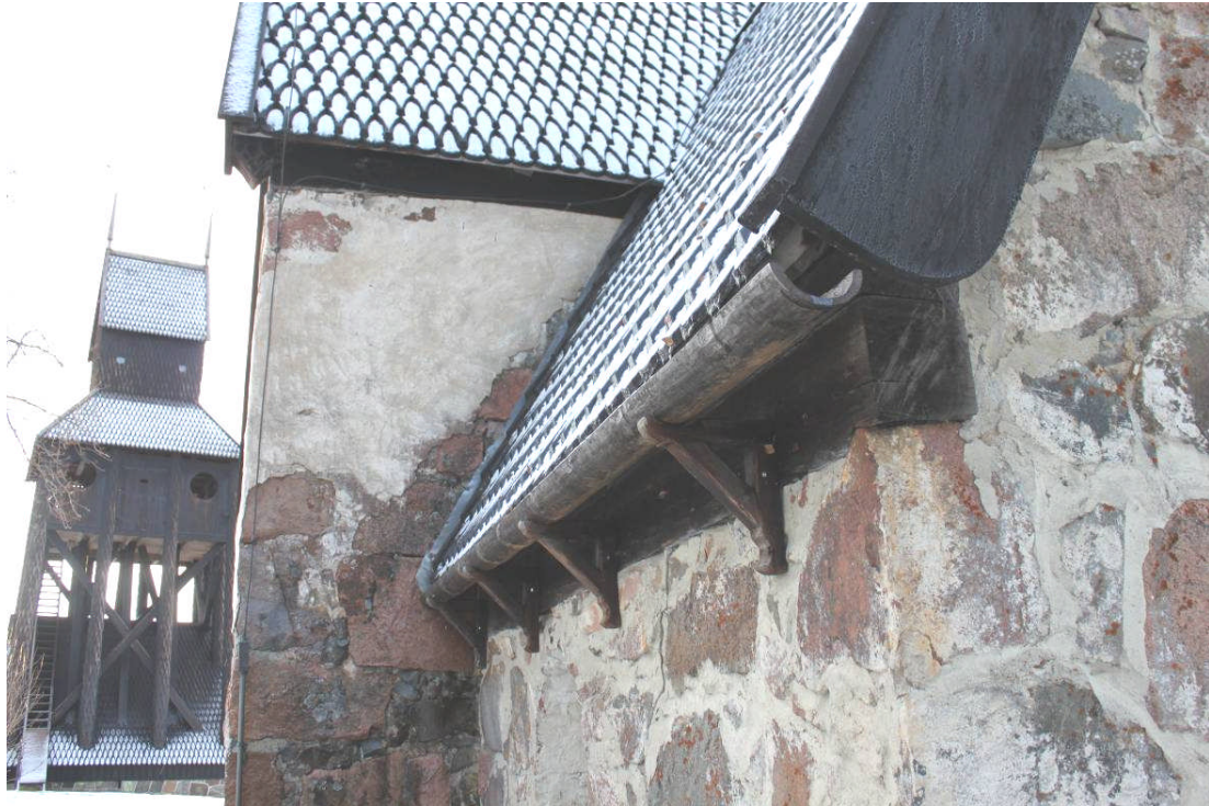
Hängränna i trä på träkonsoler som är förebild för de nya hängränorna på långhuset.
