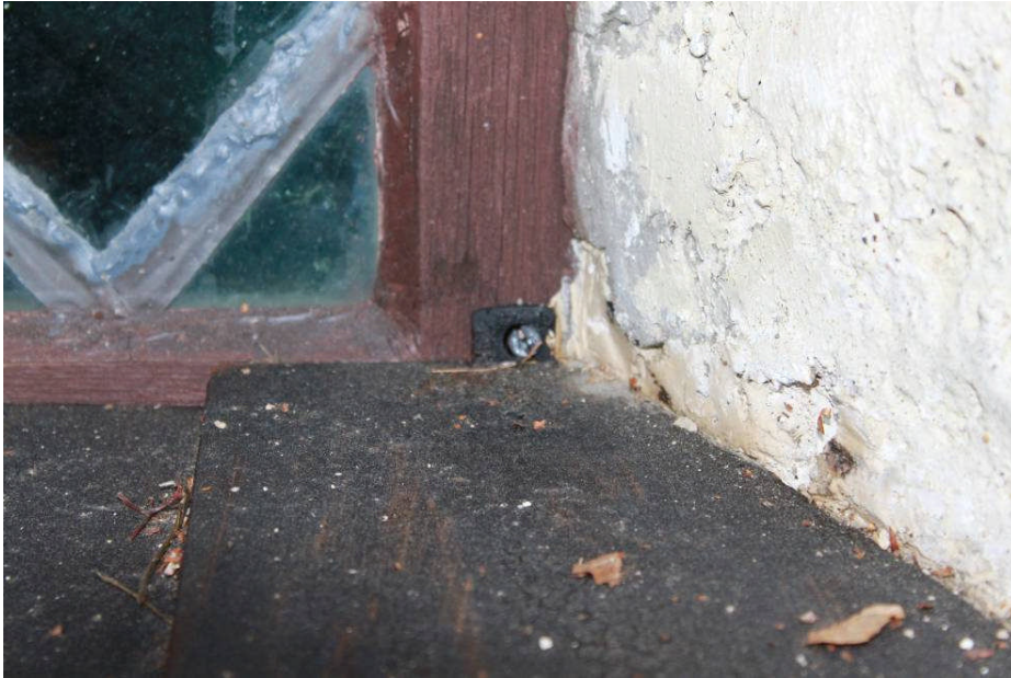
Solbänkarna har fästs med skruv i fönsterkarmen.
