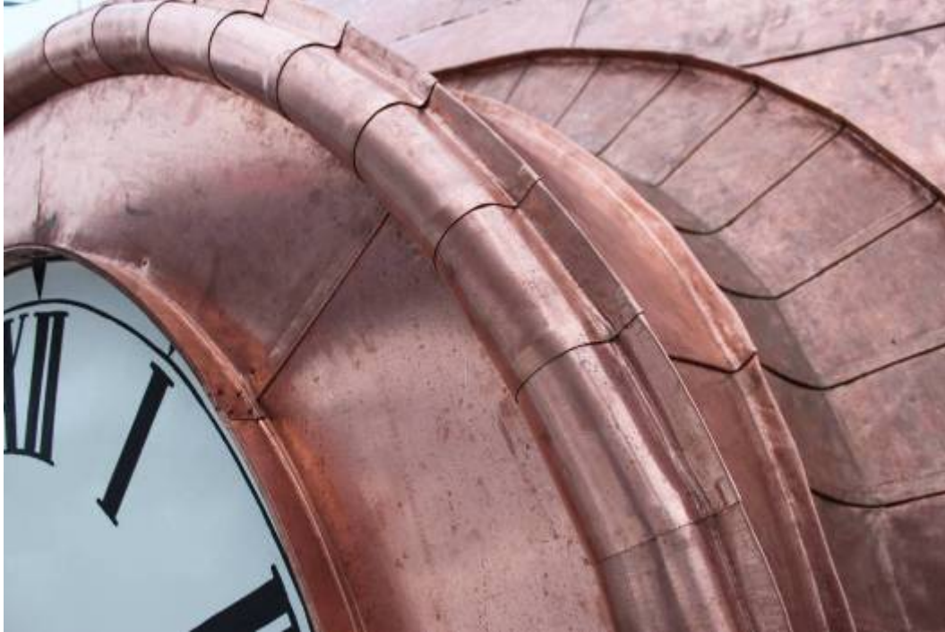
Solfjäderstäckning av tornuren
