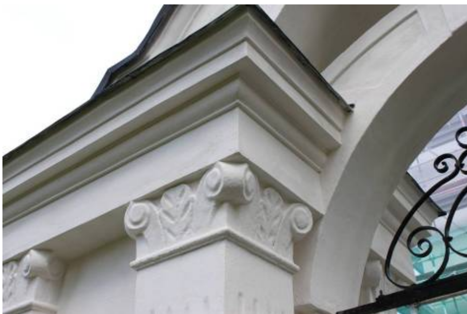
Detalj av stigport, avfärgning är utförd
