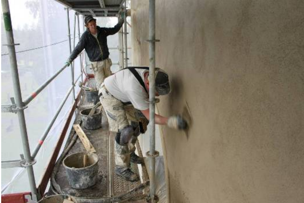
Västra tornfasaden. Slutligen användes en mindre rivbräda för att få till den slutliga putsytan
