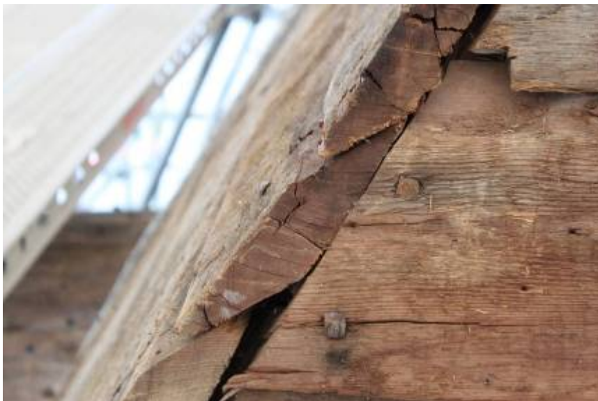
Här syns rotebrädornas fasade kanter och hur de ligger omlott.
