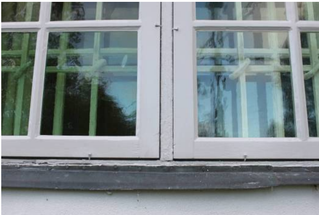
Fönsterbågar långhusets södra fasadsida. Bågarna har fästs med hästkosöm.
