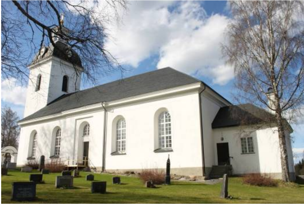
Långhusets och sakristians södra fasader
