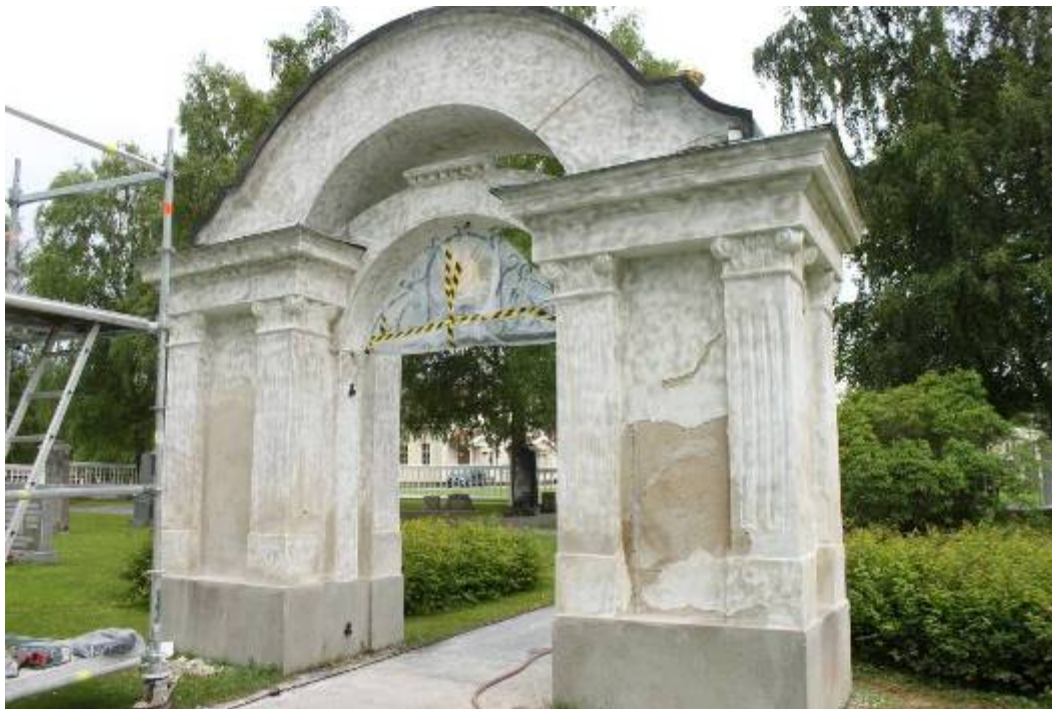
Stigport, fasad mot öster
