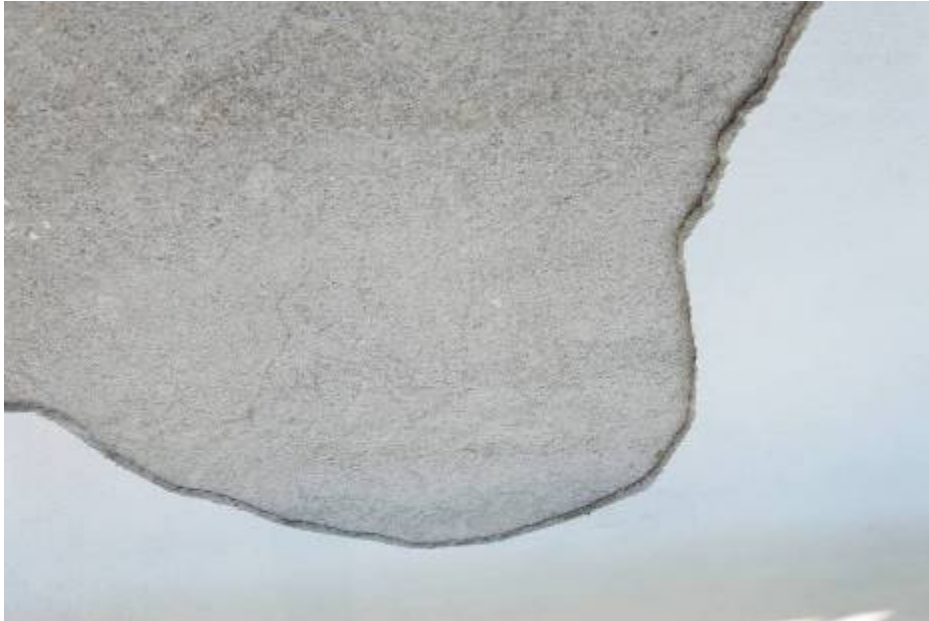
Här syns delar av putsskiktet som spjälkats loss från tornets västra fasad
