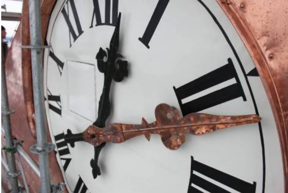
Urtavlan har restaurerats på verkstad. En ny visare har tillverkats av kopparplåt lika den äldre. Fasad mot norr.
