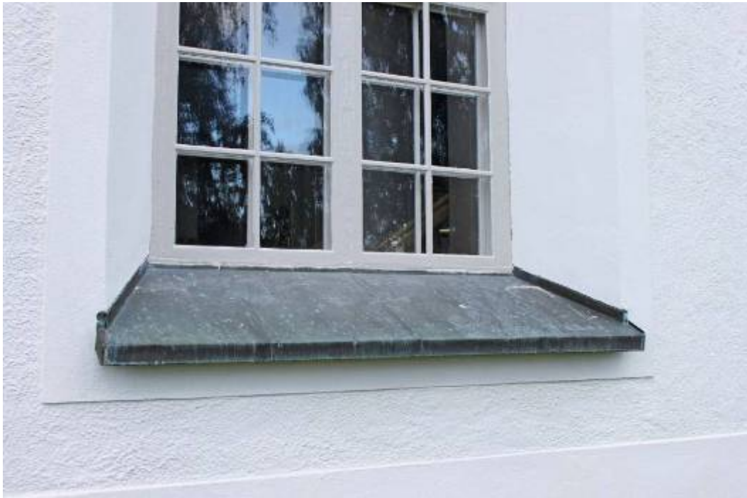
Fönsterbågar på långhusets fasadsida mot norr, målningsåtgärder är slutförda
