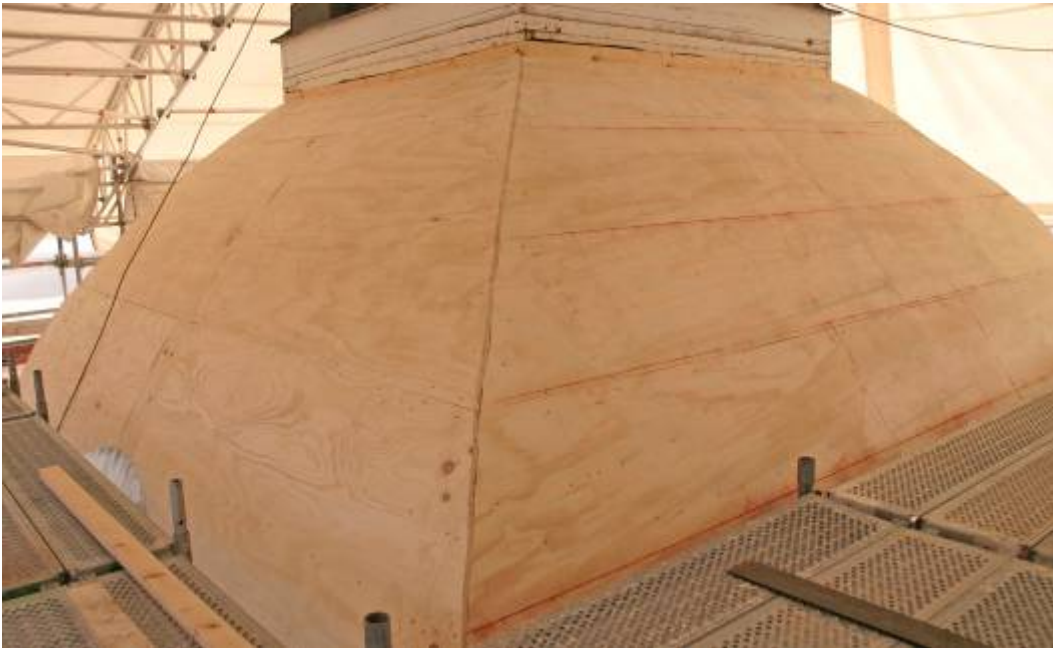
Hela tornhuven är har blivit klädd med plywoodskivor
