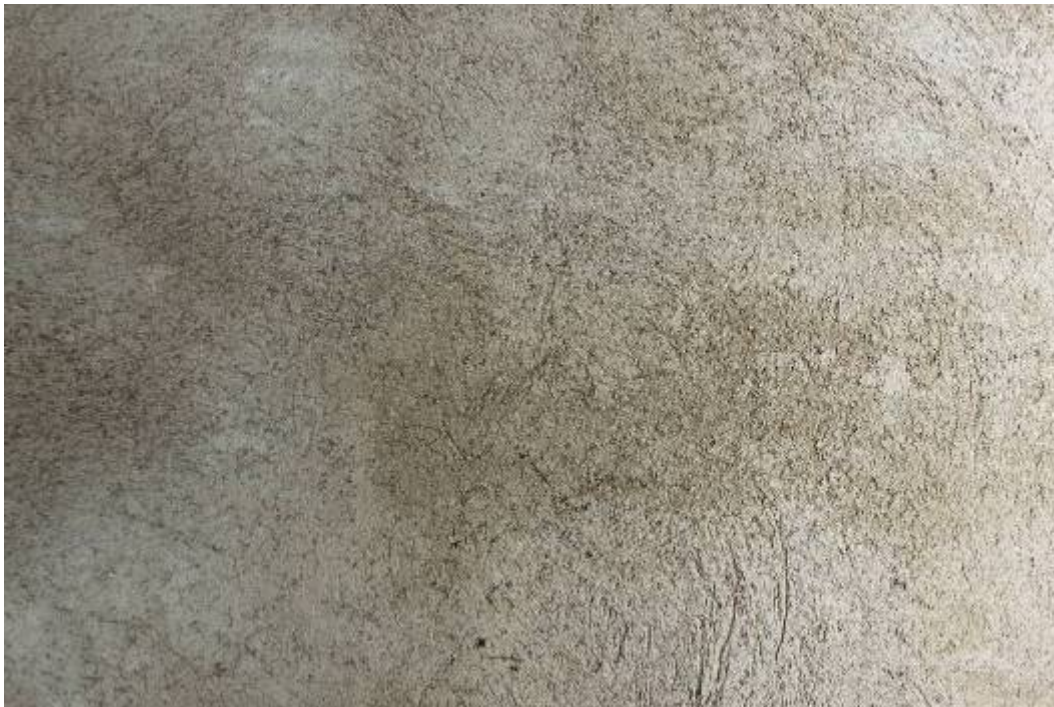
Ytputsens på tornets västra fasadsida är klar
