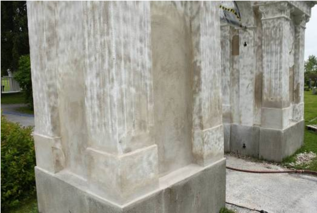
Lagningar utförda på stigportens södra och östra fasadsidor
