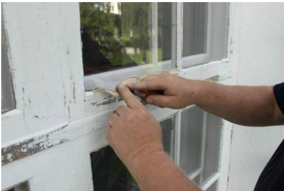
Royne Norrman lägger på kitt på falsen med kittkniven
