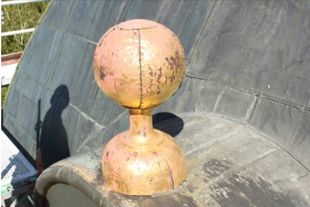
En rosaröd kulör skymtar fram partivis, vilket troligen är den kredering som förgyllningen fästs på.
