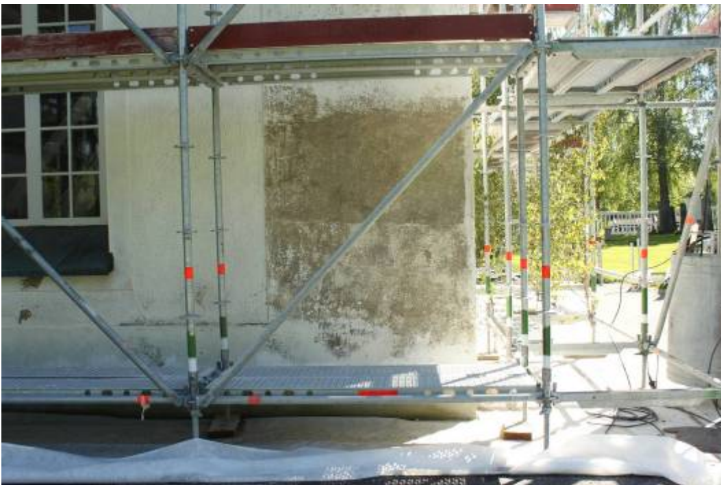
Högtryckstvättad yta på tornets norra fasad, nedre delen mer varsamt gjord än övre delen
