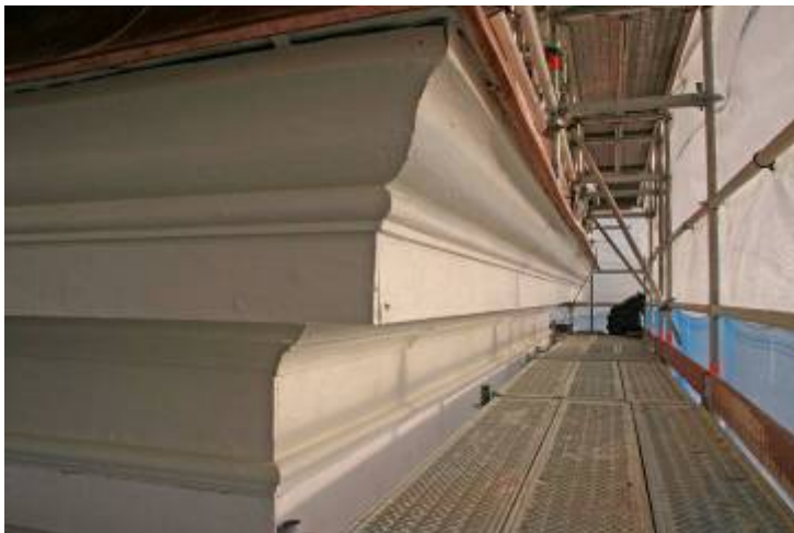
Takfotslist under tornhuv, åtgärder är utförda
