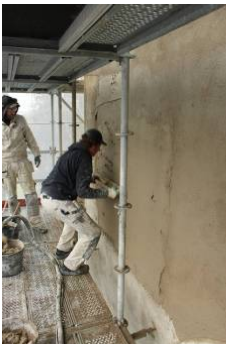
Västra tornfasaden. Putsbruket sprutas på fasaden. Bruket slätas sedan till med en större bräda
