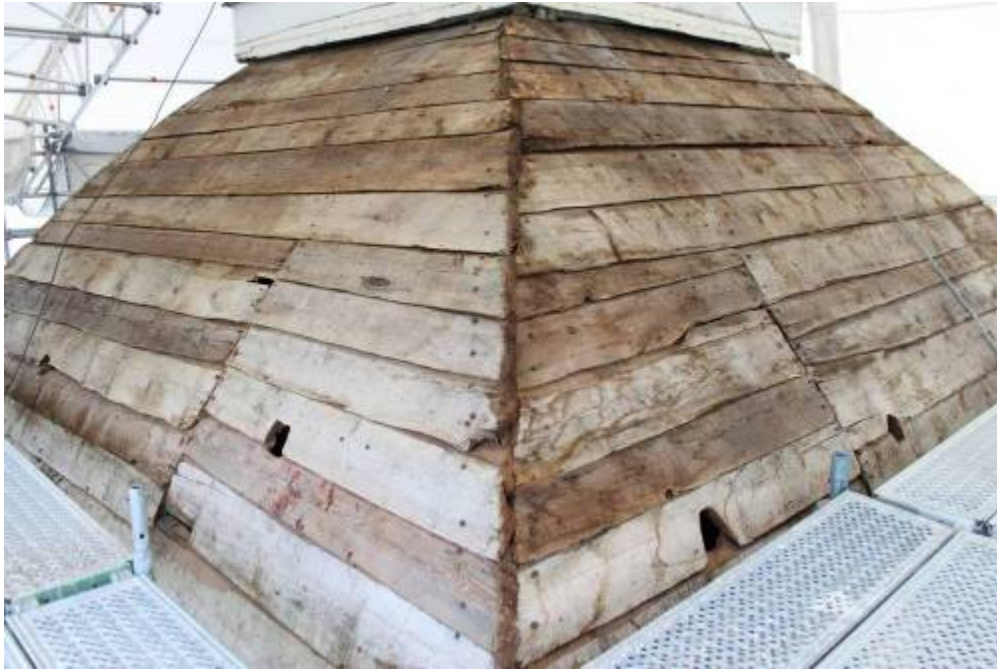
Här syns de hål som är upptagna i rotebrädorna, möjligen är de kvar efter äldre ställningsbygge
