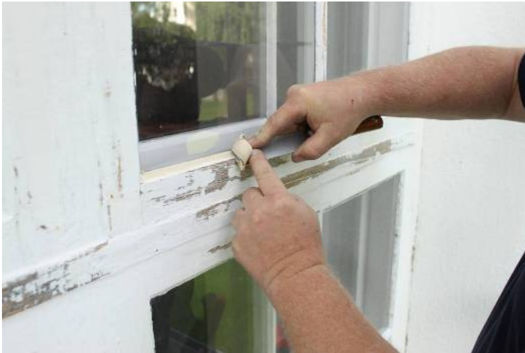
Kittfalsen formas sedan med kniven och överflödigt kitt tas bort
