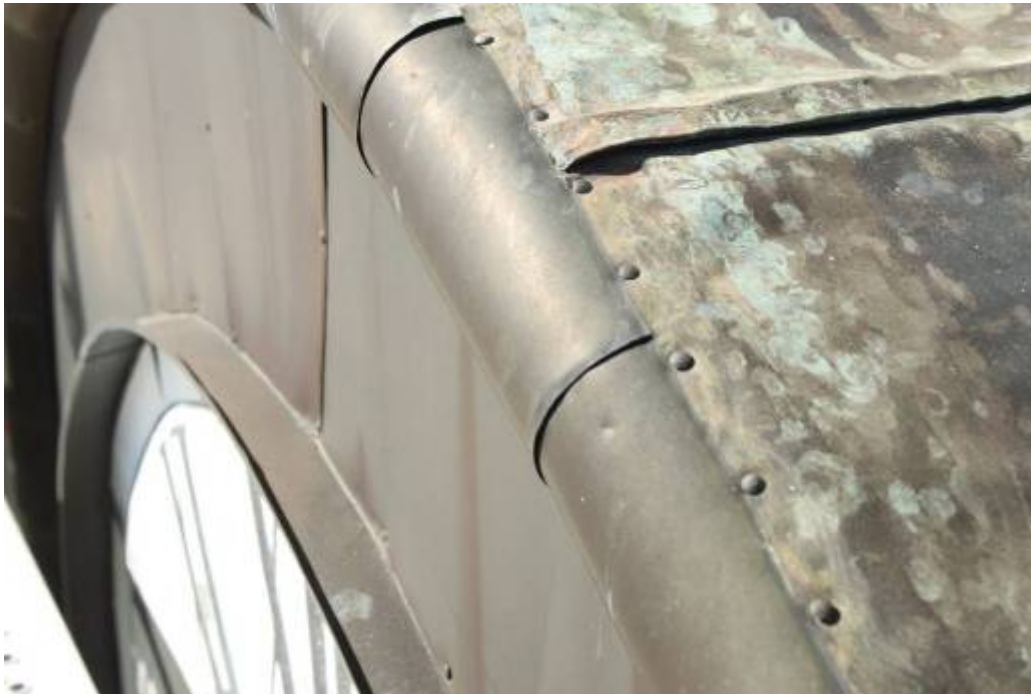
Plåttäckningen kring själva urtavlan är från 1975
