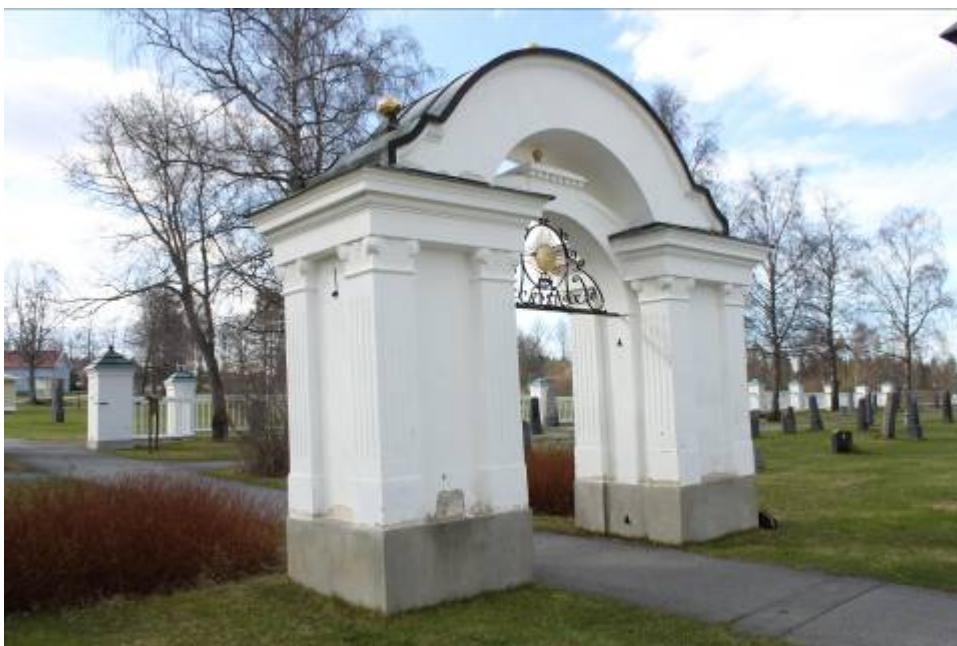
Stigport, fasad mot öster
