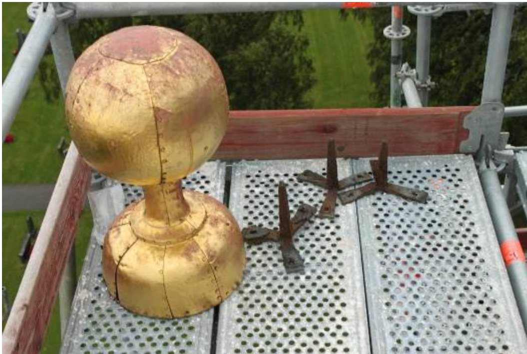
Till höger om kulan står de järnfästen som fäst kulan mot tornurens ovansida
