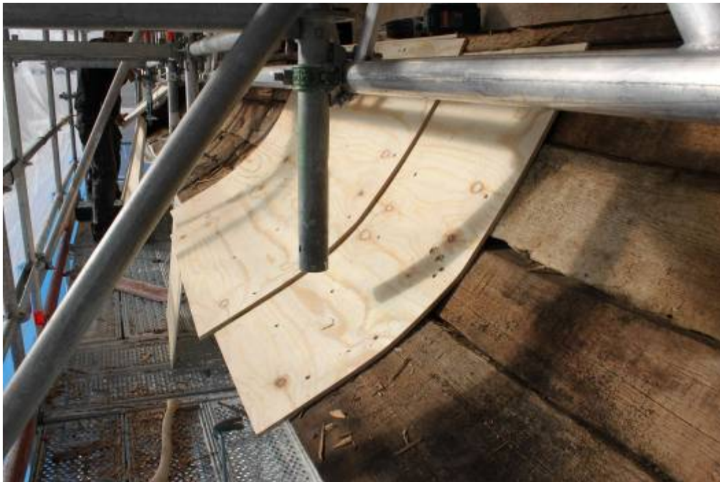
Plywoodskivor har provmonterats tornfasad mot söder
