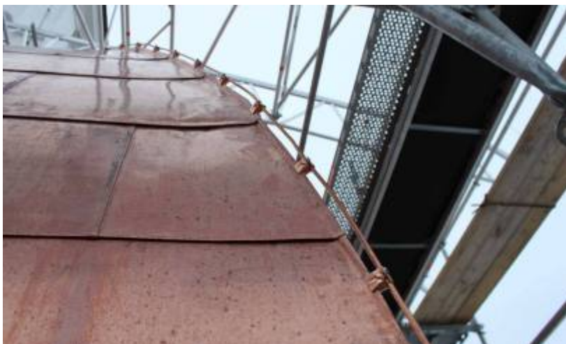
Åskledaren är fäst i de stående hörnfalserna mot nord- och sydöst
