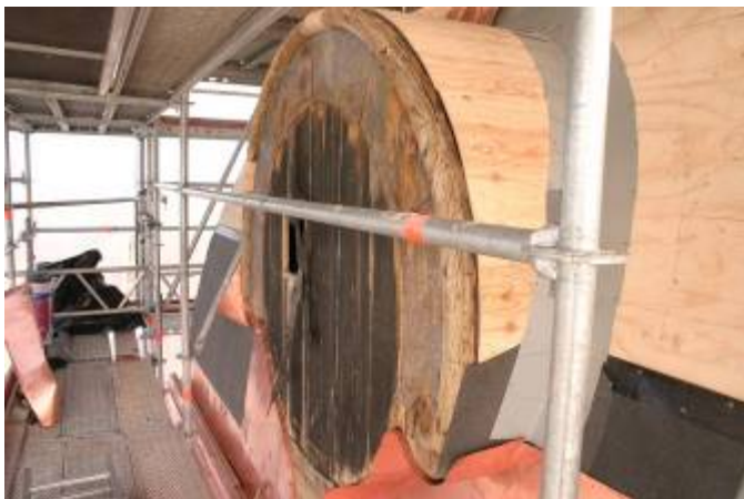
Urtavlan mot väster har demonterats. Bakom denna skymtar vi den ursprungliga urtavlan som är målad direkt på träkonstruktionen.
