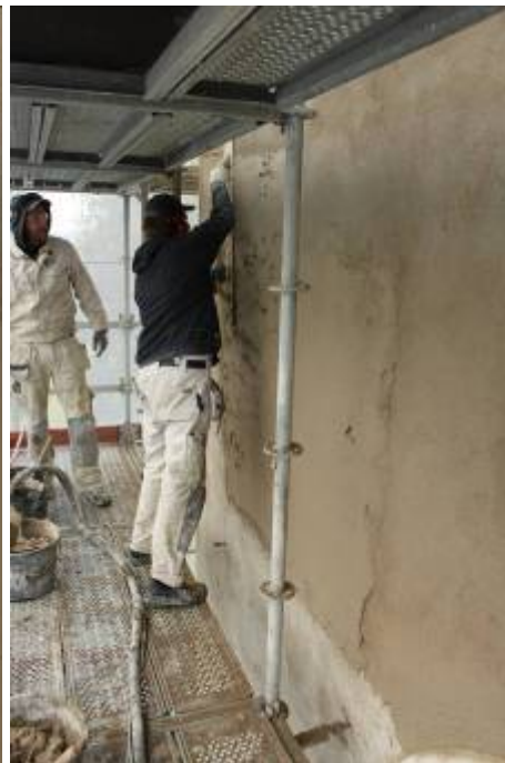
Västra tornfasaden. Putsbruket sprutas på fasaden. Bruket slätas sedan till med en större bräda
