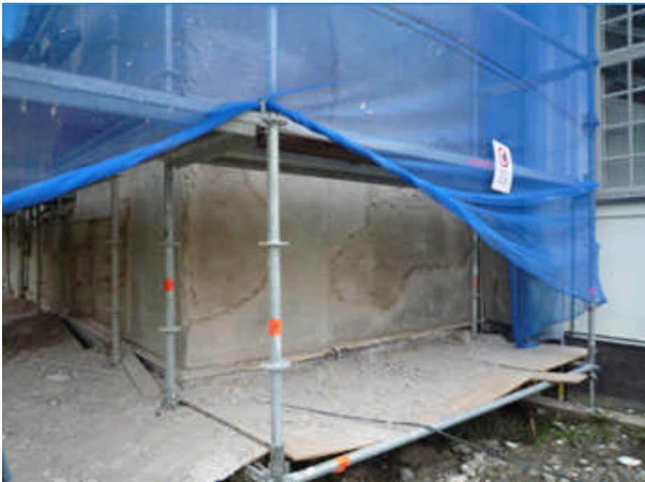
Putslagningar vid den västra fasaden, intill tornet (digital bild nr 1010037).
