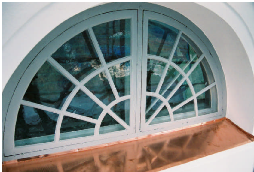
En av de nya vattbrädorna i kopparplåt (bild nr 09m30/05).
