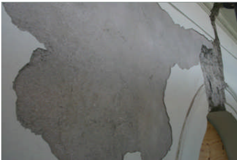
På den norra sidan fanns ett yttre lager med tunnare, nyare puts. Under den syns sprickor (digital bild nr IMG2141).
