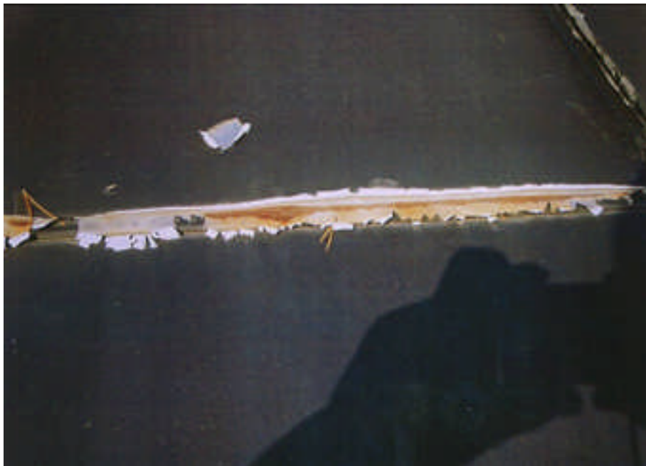
Taket flagnade kraftigt och rostade på flera ställen. Foto från församlingen (digital bild nr 20091106092917_00002).
