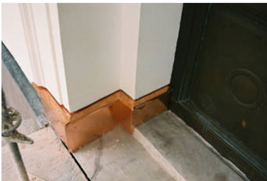
Ny kopparplåt vid den södra ingången (bild nr 09m30/22).
