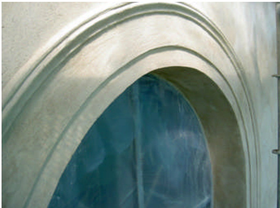
En av de omputsade putslisterna kring fönstren (digital bild nr PICT8643).
