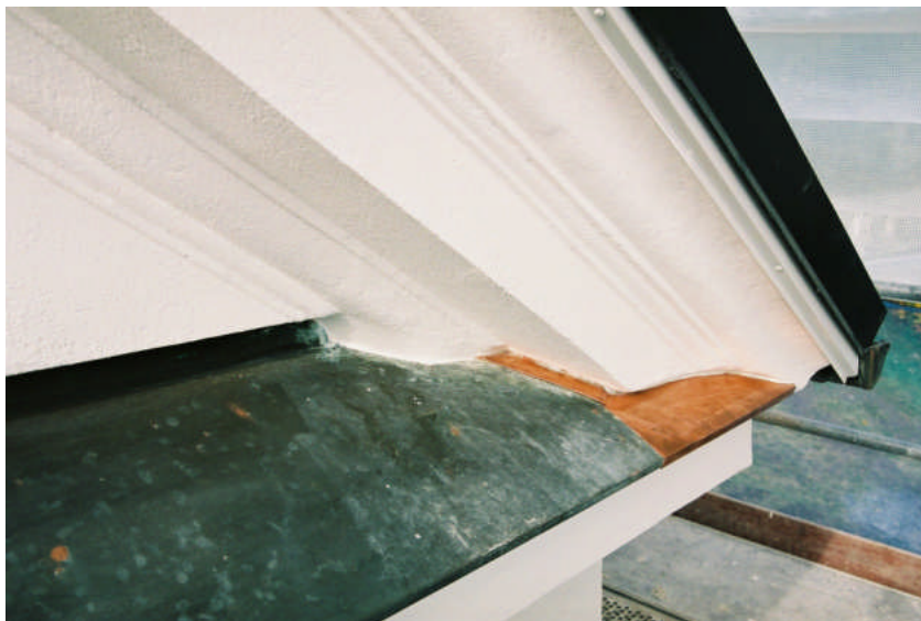
Den ilagade plåtavtäckningen vid den östra fasadens gavelfält (bild nr 09m031/34).
