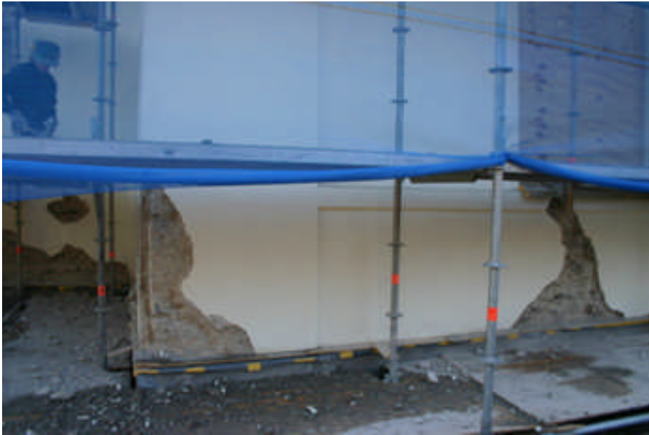
Upphuggna sprickor på den norra fasaden (digital bild nr IMG2136).
