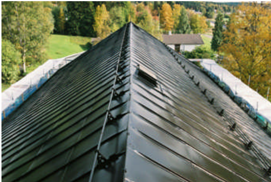
Taket efter att det målats ochnockräcke samt snörasskydd satts upp (bild nr 09m033/05).
