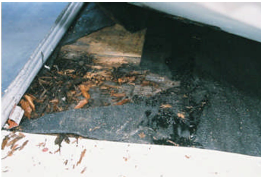
Rötskador fanns i takrotet under några av plåtarna (bild nr 09m021/31).
