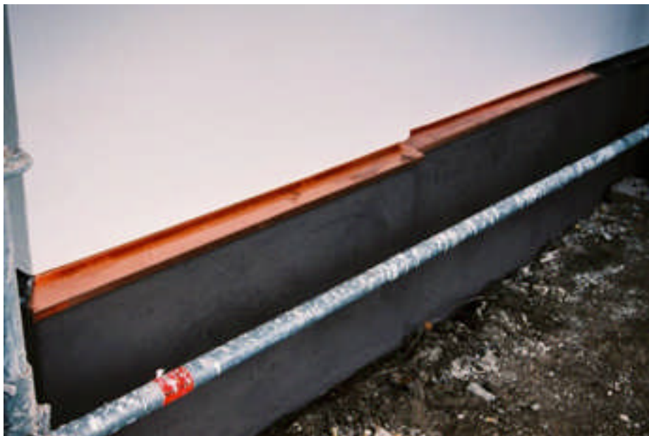
Ny plåttäckning vid den västra fasaden (bild nr 09m030/17).
