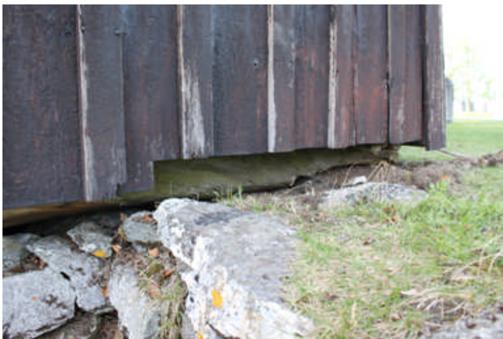
Bild 10: Hörnet C/D-vägg där en offerbräda skall monteras för
