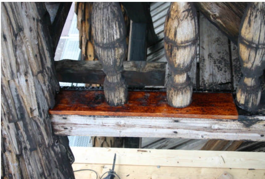
Bild 5: Iskarvad bräda av fura vid balusterdockorna.
