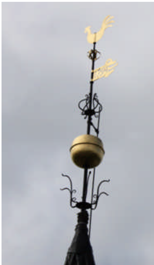
Bild 11: Spiran efter montering.
