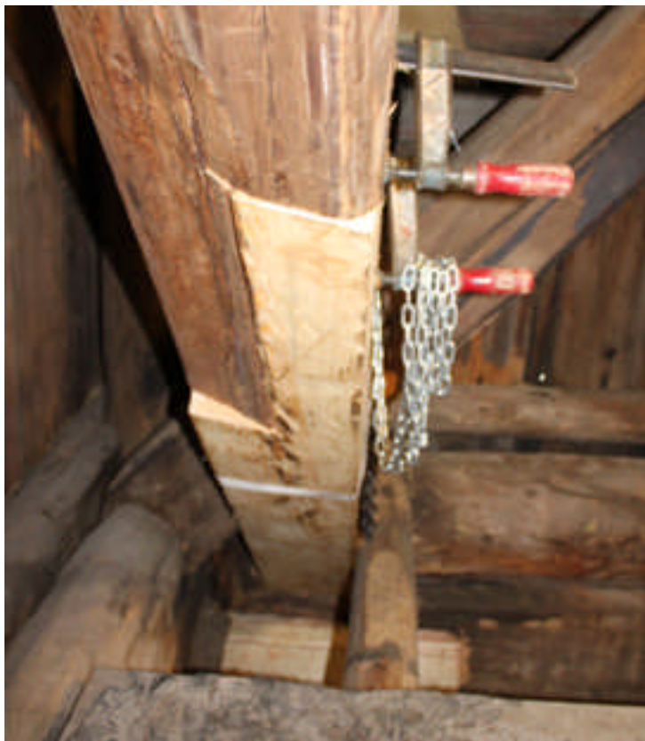
Bild 9: Bild x: Snedsträvan vid A/B-hörm skarvades.
