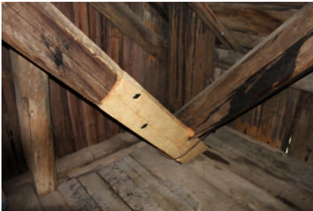
Bild 10: Snedsträvan efternitning och golvets åtemontering
