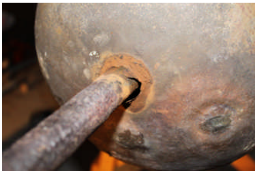
Bild 6: Spirans klot innan reparationer.
