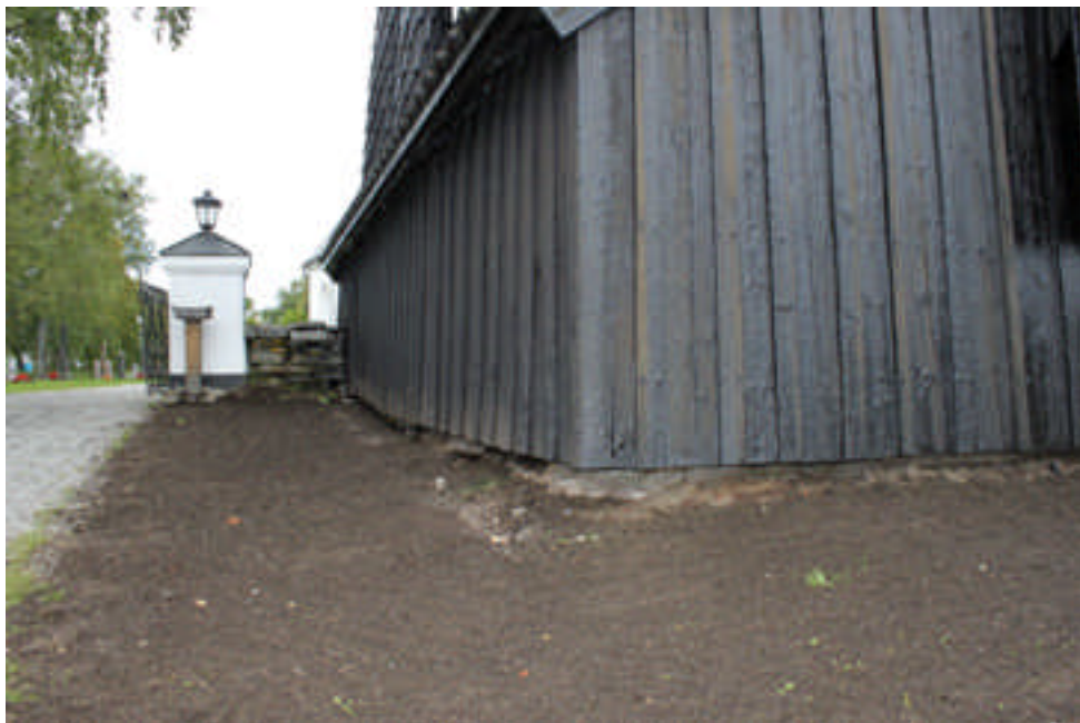
Bild 9. Hörnet vid A/B-vägg släntades för bättre avrinning.
