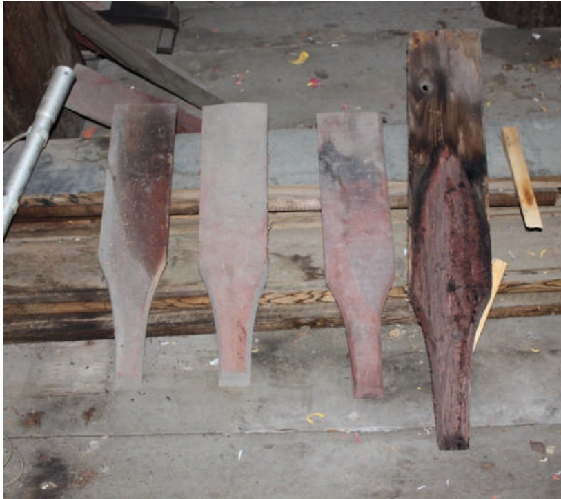
Bild 7: Sparade spån från klockbodens reservlager samt ett nödplockat stolpspån.
