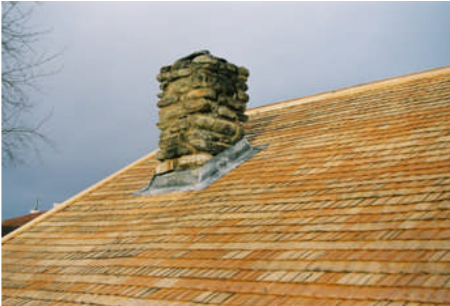
Den nya blyplåten vid skorstenen (04m167/19)
