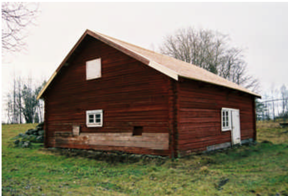
D-väggens vindskivor skarvades (bild nr 04m167/25).
