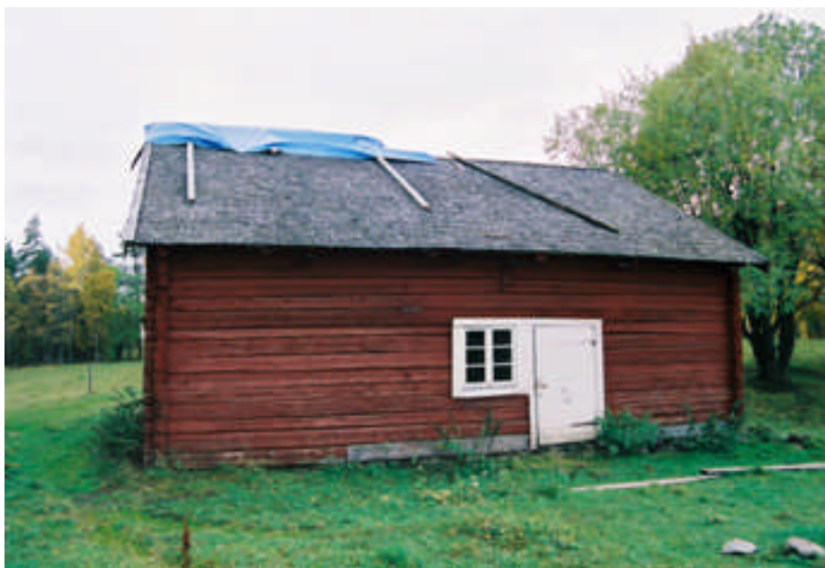
Det norra takfallet var i bättre skick än det södra innan omläggningen (bild nr 04M139/33).
