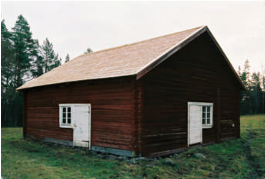
Det norra takfallet efter åtgärd (bild nr 04m167/28).
