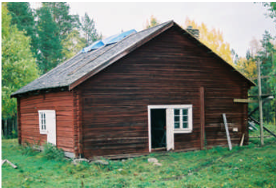
Ladugårdens B- och C-vägg samt det norra takfallet (bild nr 04m139/37).
