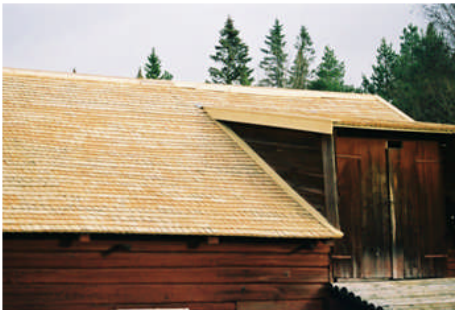
Det södra takfallet vid gällbron (bild nr 04m167/22).
