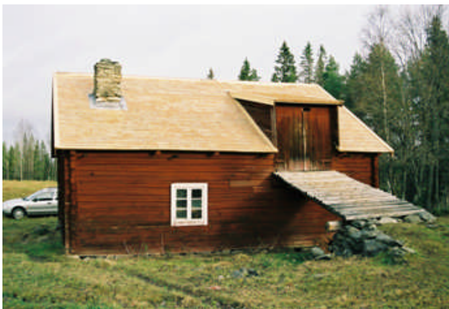
Det södra takfallet efter åtgärd (bild nr 04m167/21).
