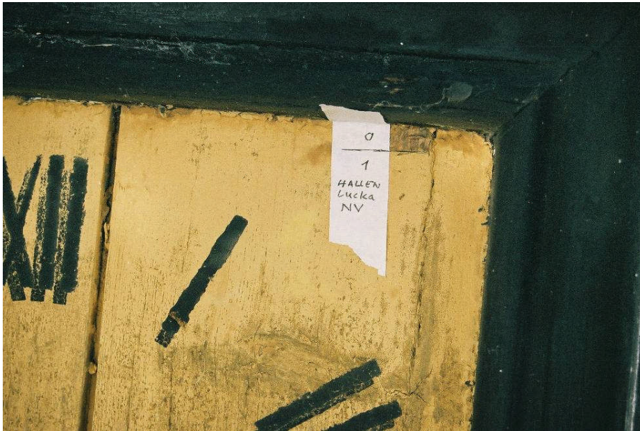
Bild 14. Vid skrapning på plats framkom enbart ett lager med gul färg på ljudluckan (bild nr 09m035/07).
