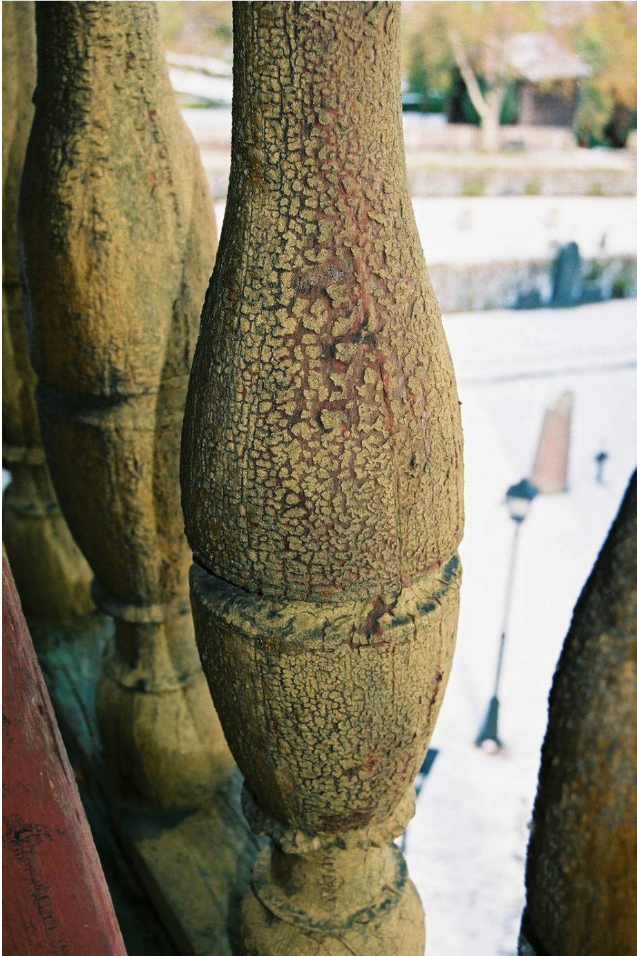
Bild 9. Den rödpigmenterade tjäran syns tydligt under balusterdockornas gula färg (bild nr 09m035/05).
