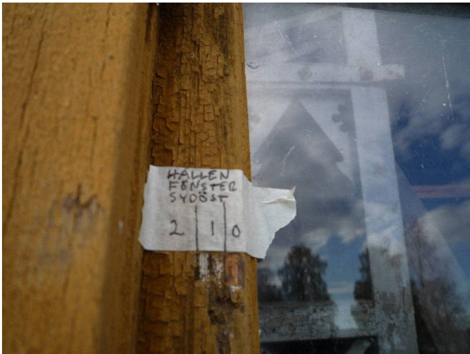
Bild 12. Färgstege på klockbodens fönsterbåge. Under den gula färgen finns en vit färg (digital bild nr 1020540).
