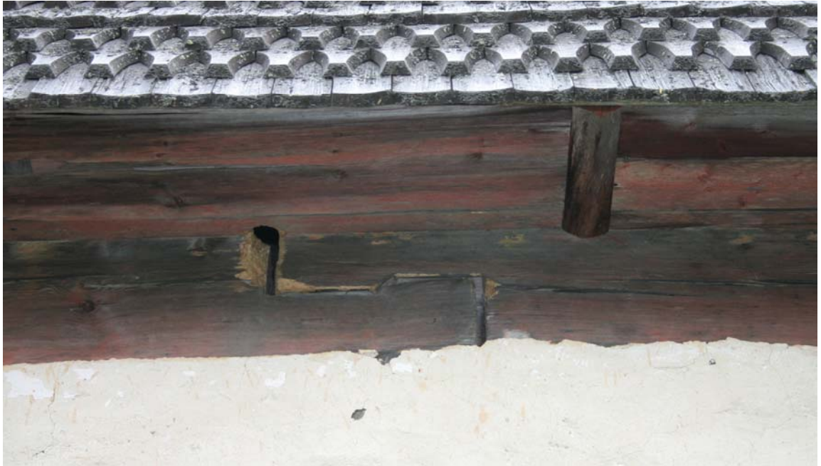
Bild 9, ovan: Skarv på murremman på långhusets norra vägg. I skarvens vänstra ände har fåglar hackat upp ett större hål.
