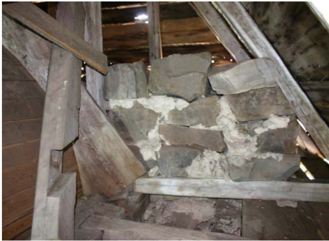
Bild 6. Vy mot öster vid kyrkans sydöstra hörn. Murkrönet i öster är högre än de övriga väggarna. Murremmarna i bildens nederkant går in i muren och de två takstolarna längst i öster står på var sida om den förhöjda muren. Till vänster skymtar det karnisformade valvet och den kraftiga, profilerade bjälken som valvets träbrädor fästs emot.
