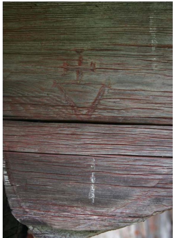
Bild 10-11, nedan: Västra änden på norra väggens murrem. Änden har profilerats och på norra sidan finns ett kors inskuret.
