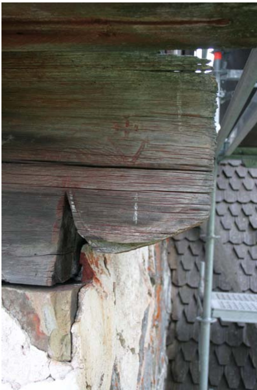
Bild 10-11, nedan: Västra änden på norra väggens murrem. Änden har profilerats och på norra sidan finns ett kors inskuret.
