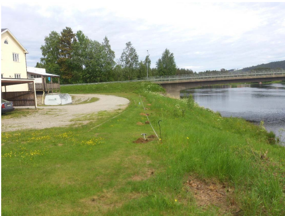
Fig. 3. Provgropar och den nuvarande bron. Bilden tagen mot NNÖ.
