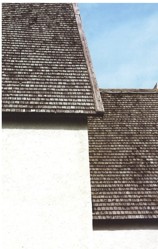
Det södra takfallet på långhuset och korets södra takfall Jlm 2002m79
