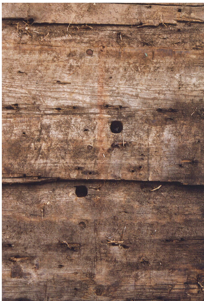
Närbild av två brädor på det södra takfallet som har borrarade hål. Jlm 2002m94/3
