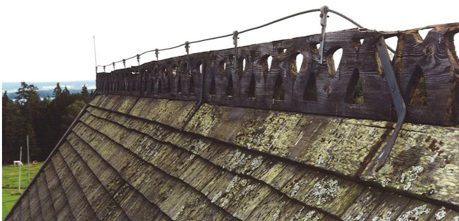
Den östra delen av takryttaren innan demontering. Denna del var tillverkad i ett stycke. Jlm 2002m79
