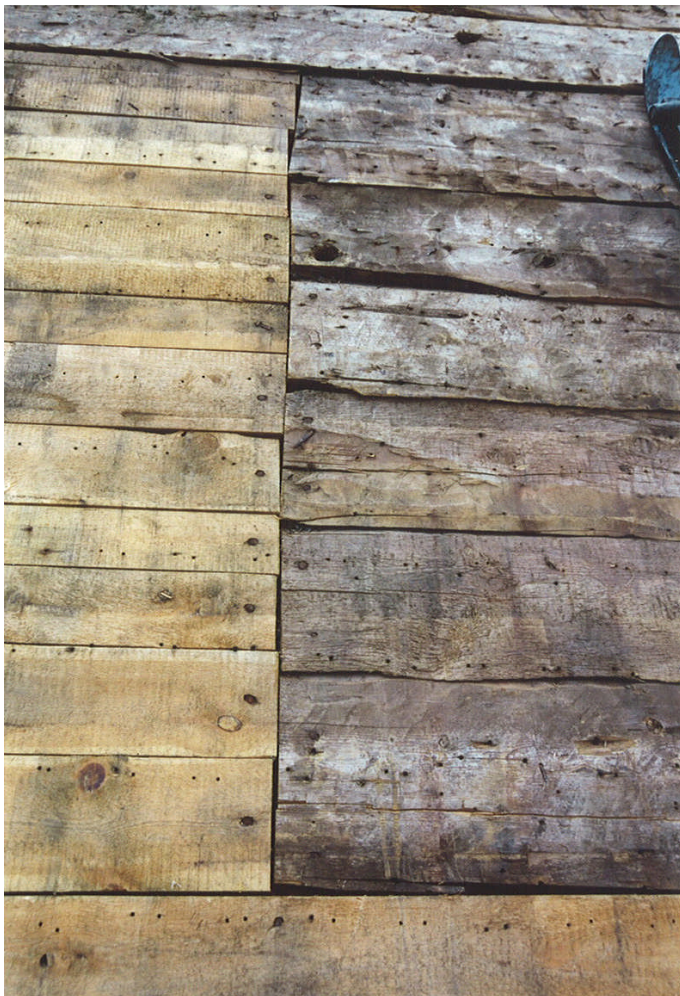
Till vänster syns sågade brädor från takomläggningen 1909 och till höger spräckta, huggna brädor. Jlm2002m79
