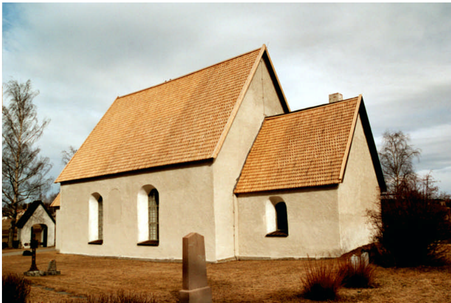
Norderö kyrka med ny spåntäckning från 2002/2003
