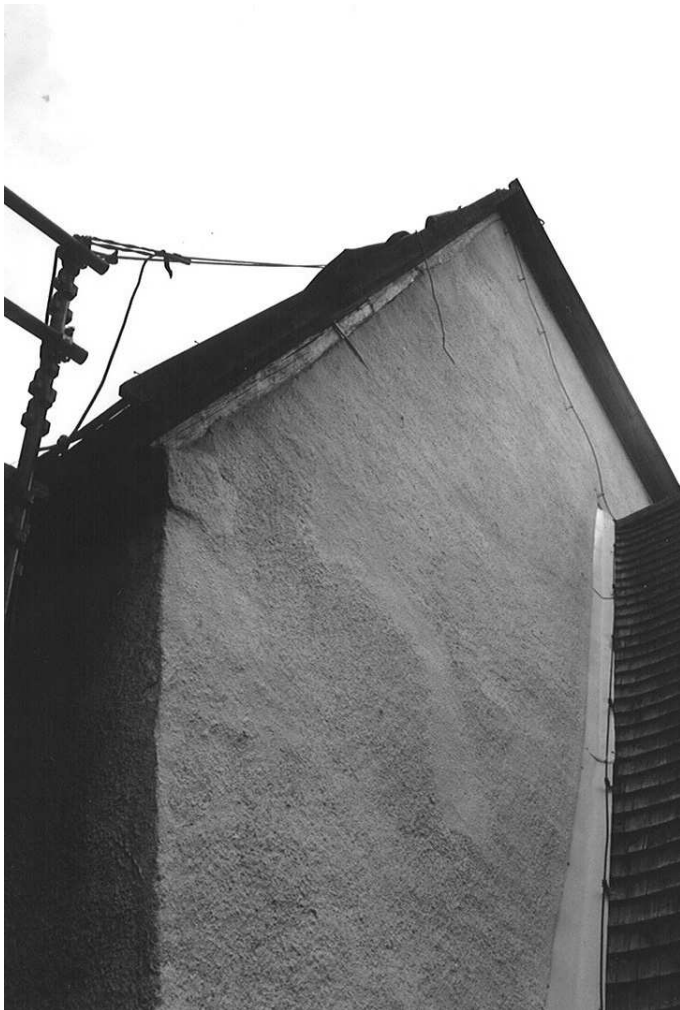
Anslutningen mellan långhuset och vapenhuset sett från norr. Jlm 2002m79
