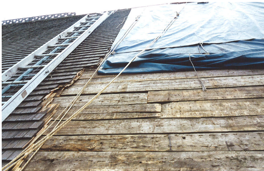
Borttagning av spån började på det norra takfallet på långhuset. En stor del av den gamla rotningen var kvar. Jlm 2002m79
