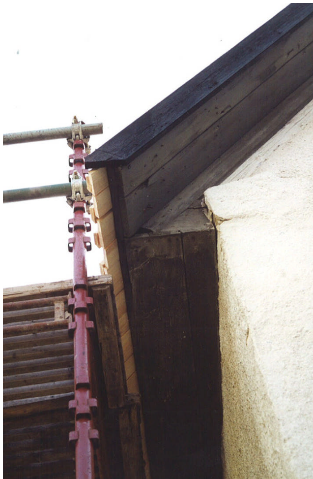
Den nedersta spånraden sticker ut ca 60 mm utanför rotningen. Jlm 2002m100/10
