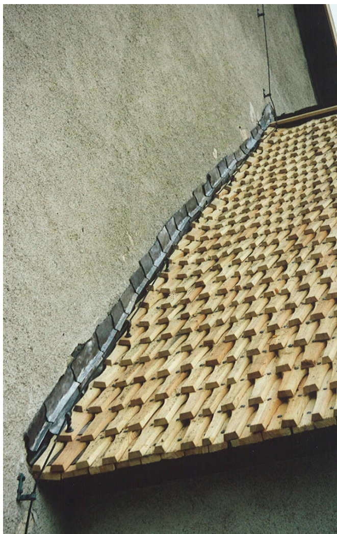
Sakristians södra takfall med blyplåten mot långhusväggen. Jlm 2002m105
