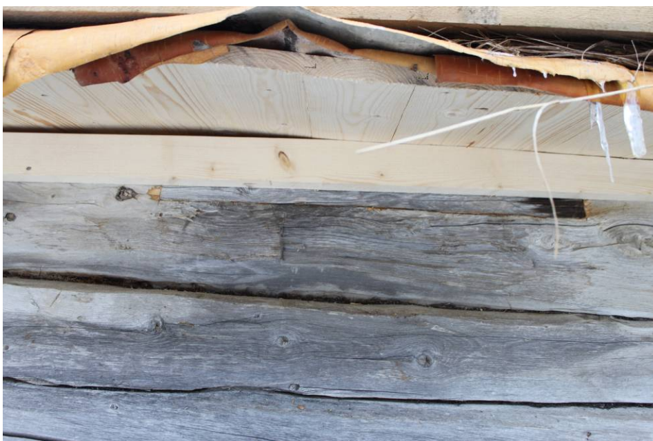
Takfoten efter åtgärd. Lägg märke till ilagningen i stock D9, samt listen vid väggbandet som döljer den gamla rotningens ändar.
