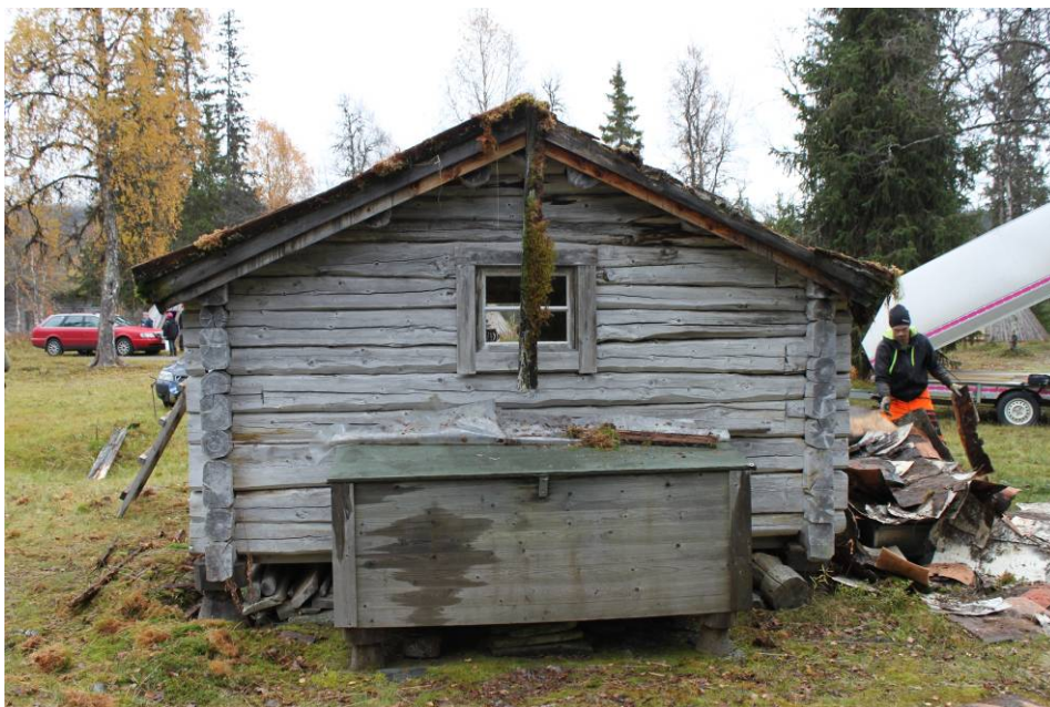
C-väggen i samband med att arbetena påbörjats
