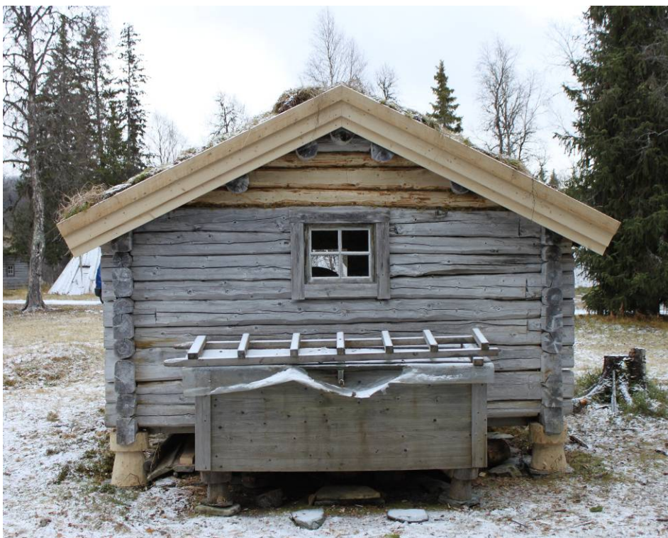
C-väggen efter genomförda åtgärder
