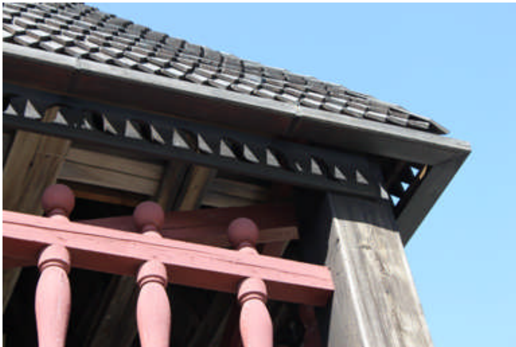
Bild 5: Balusterräcket och kryssträvorna är idag målade i samma kulör till skillnad från tidigare färgsättning.
