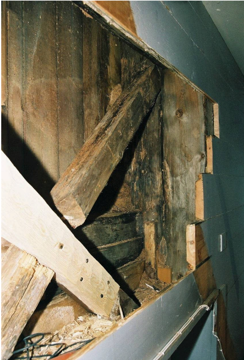
Bild 12. Lagning av den yttre strävan i tornets innervägg. Sågspånet i väggen togs bort (07M029/04).
