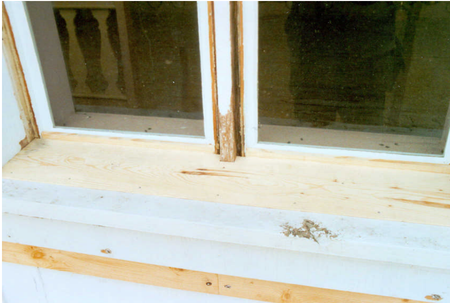
Bild 10. Fönsterbräda efter att solbänken byggts upp (foto Stig Nilsson).
