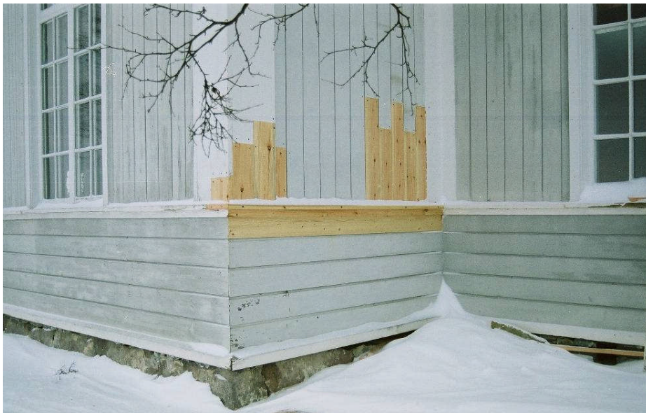
Bild 4. Utbytt panel på långhusets NO-vägg. Till höger syns sakristian (neg nr 07M020/02).
