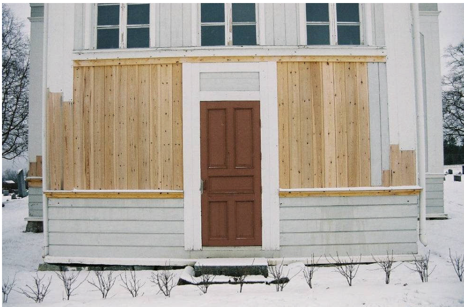
Bild 6. Utbytt panel på sakristians norra vägg (neg nr 08M001/14).
