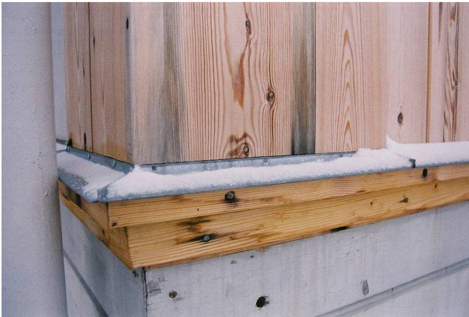
Bild 8. Detalj av den utbytta panelen och listverket vid sakristians knut mot NO samt den nya plättäckningen (08M001/16).
