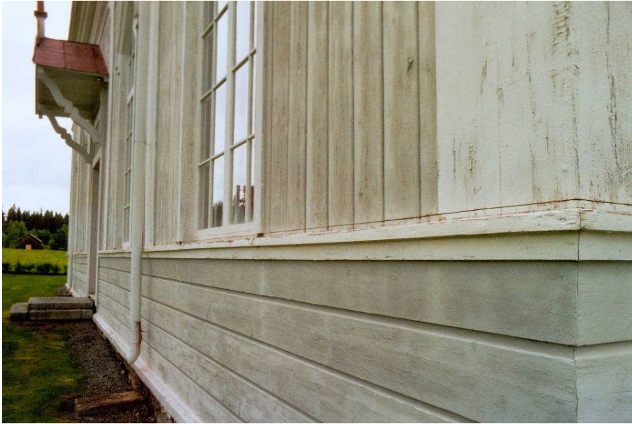
Bild 7. Ett spår sågades upp längs hela fasaden för att kunna fästa ett plåtbleck över mittbandslisten (foto Stig Nilsson).
