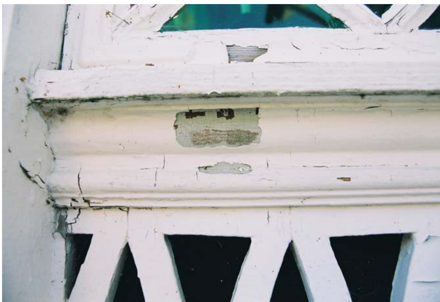
Skrapprov på verandans överliggare. Färgsättningen förefaller vara densamma som på fasadens fönster- och hörnfoder. JLM neg 04M159
