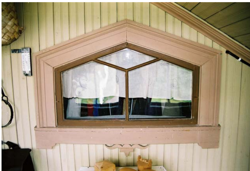
Fönster på verandans innervägg mot vindsutrymmet. Skrapning av pärlspontpanelen, fönsterfodret och fönsterbågen visade endast två lager av färg. JLM neg 05M121
