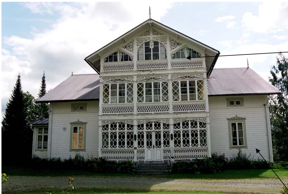
Huvudbyggnadens A-vägg (Neg nr. 03M115/34)
