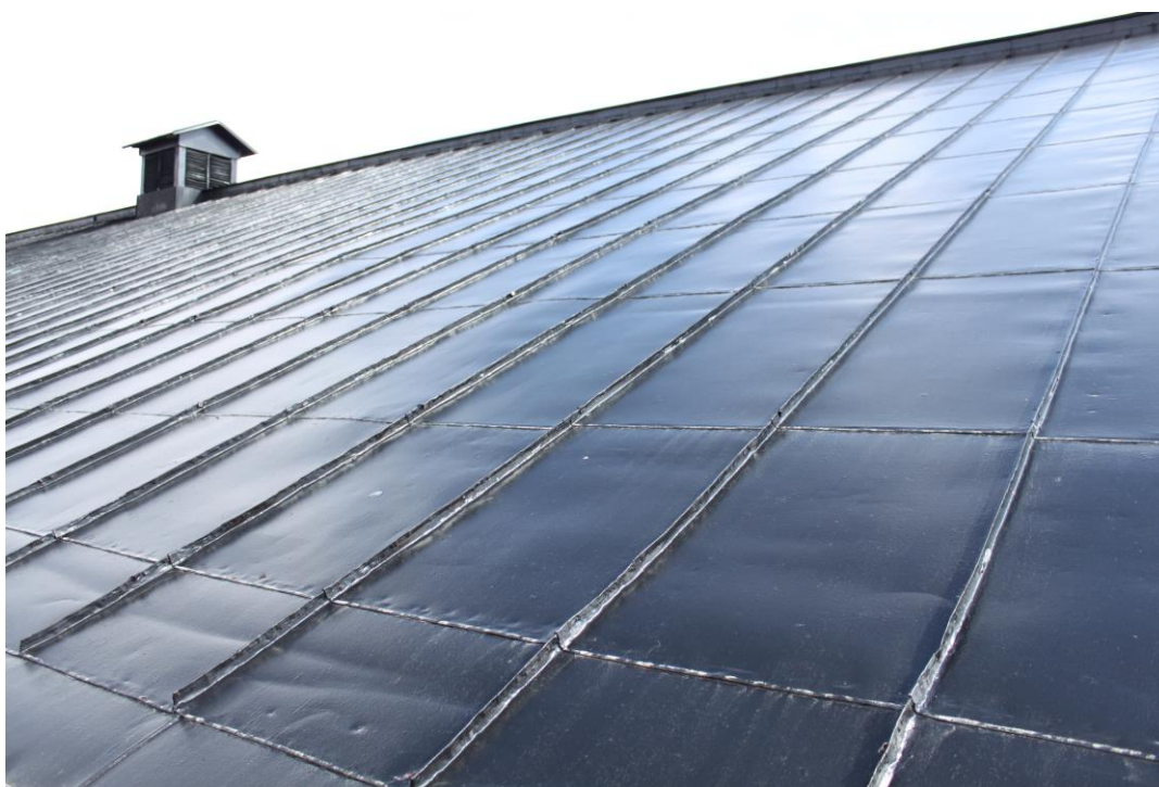
Före åtgärder, befintlig äldre taktäckning
