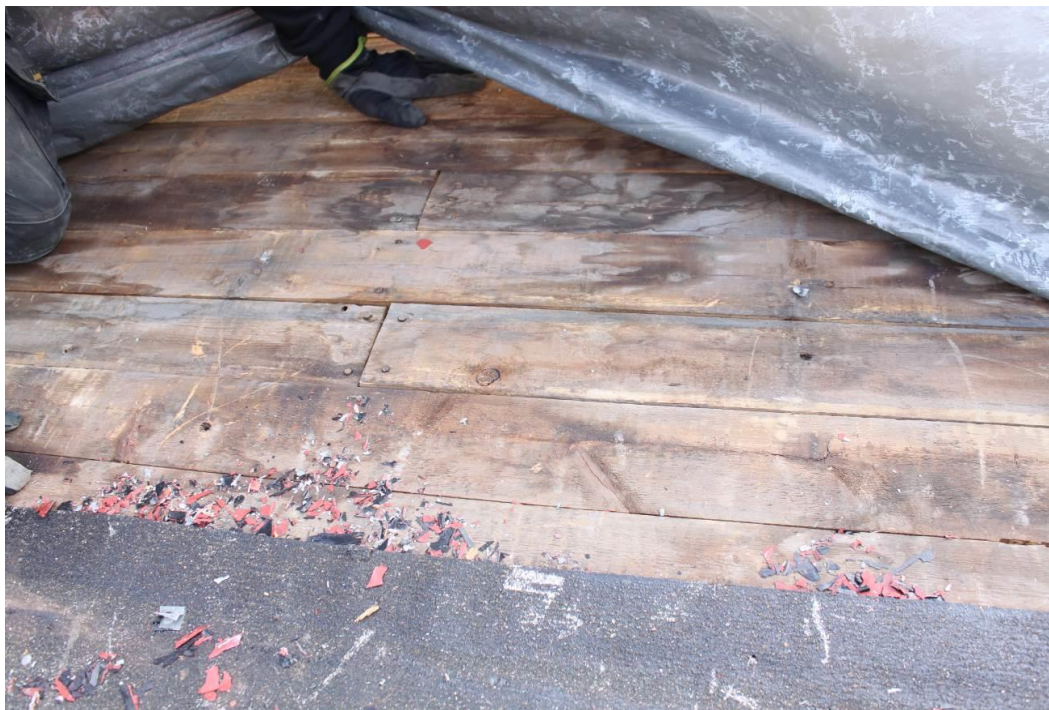
Takrotet var ramsågat, längd, bredd och tjocklek varierade.
