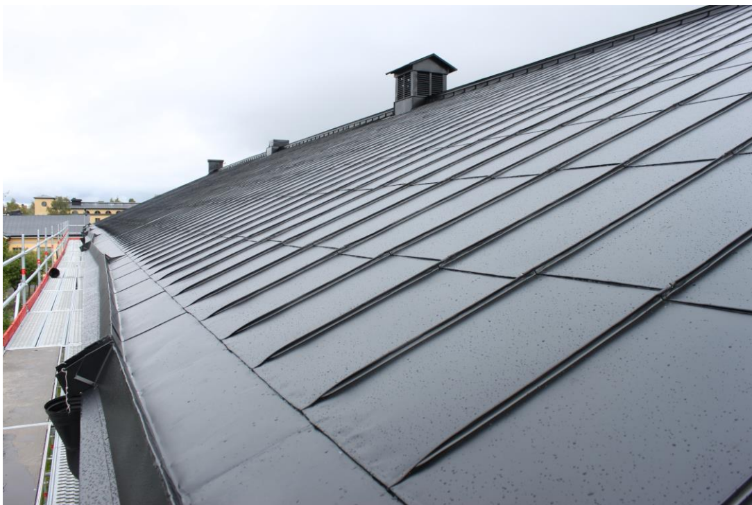
Hela takfallet har fått ny plåttäckning
