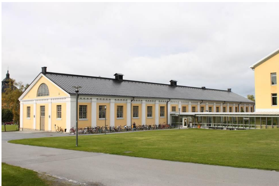
Byggnad 9, södra och östra fasaderna, foto från 2012
