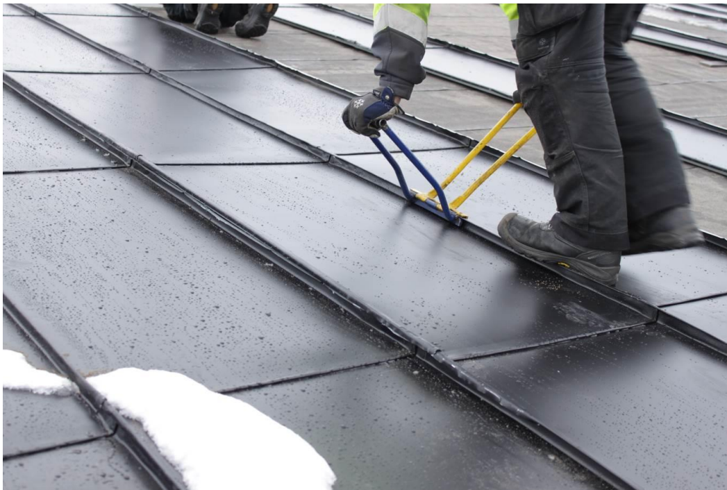
Plåten dubbelfalsas för hand. Med hjälp av dubbelfalsförslutare viks plåtarna omlott i tre omgångar.
