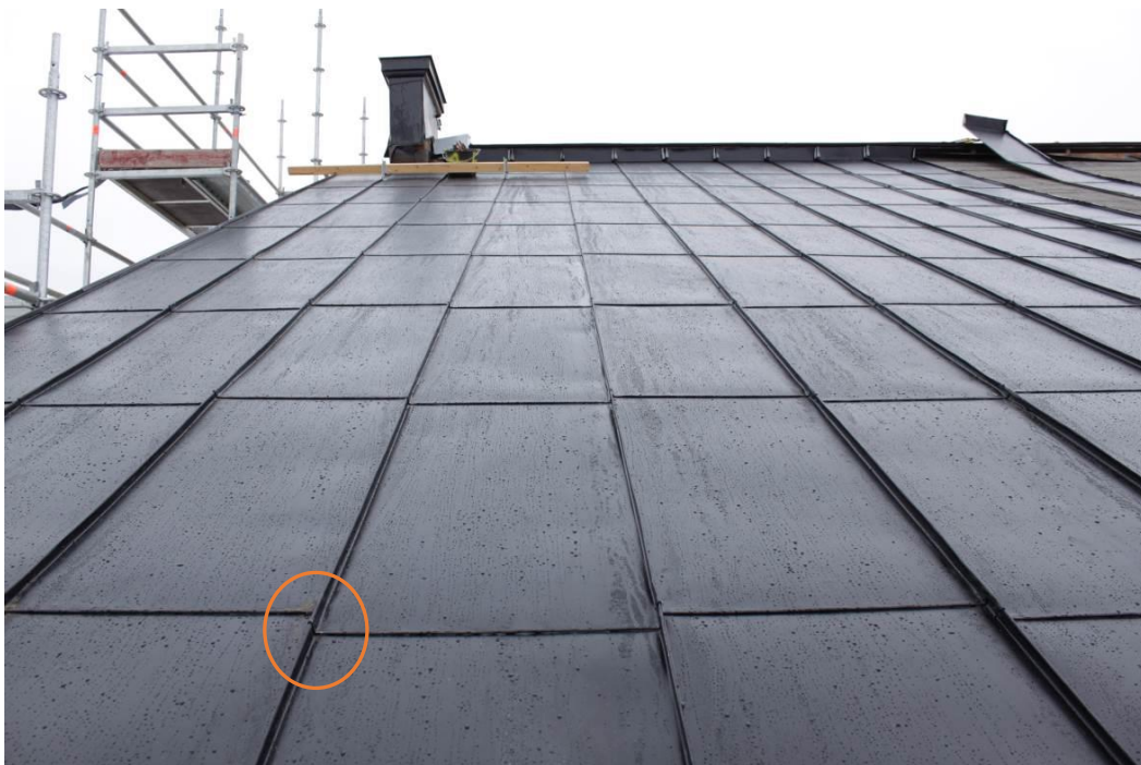
Den nya täckningen. Skivorna har förskjutits några centimetrar för att mötet mellan hakfalsarna inte ska bli för knöligt.
