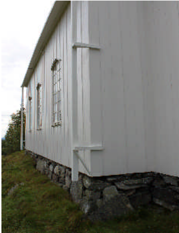
Bild 11: Stuprör på nora långsidan efter rekonstruktion.
