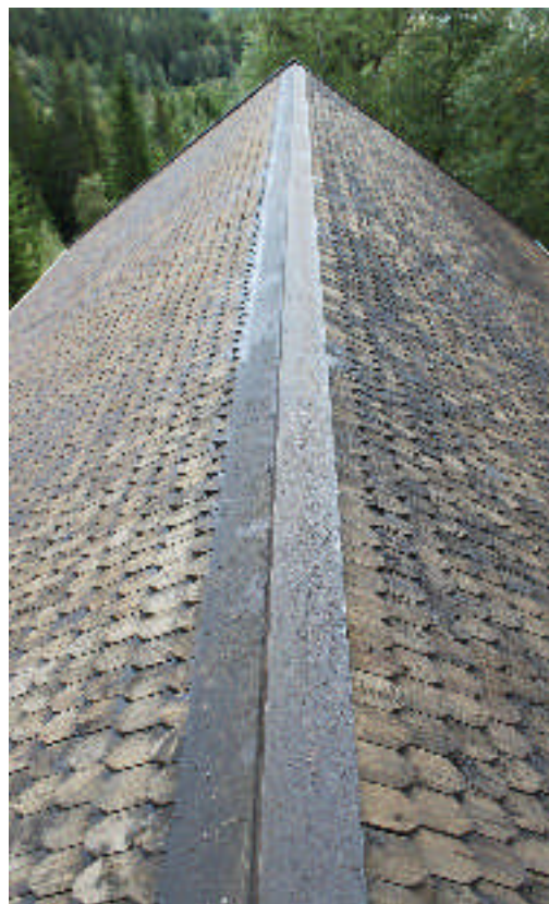
Bild 9: Nya nockbrädor på långhusets tak.
