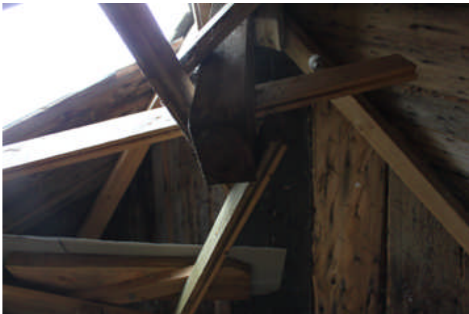
Bild 3: Korsglobens infästning av återanvänd spântpanel.
