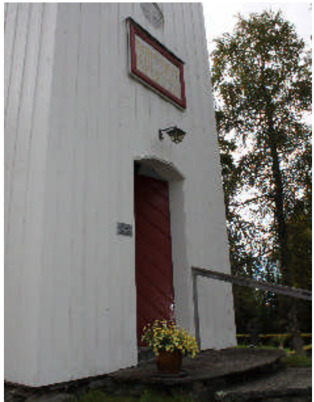
Bild 12: Entré med inskriptionstavla samt dörr. Båda har bättringsmålats i kulör lika befintlig.
