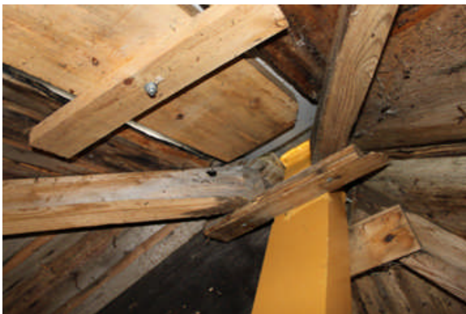
Bild 4: Den nya korsglobens infästning.
