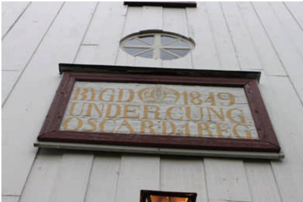
Bild 10: Ramen runt inskriptionstavlan över entrén kompletteringsmålades.
