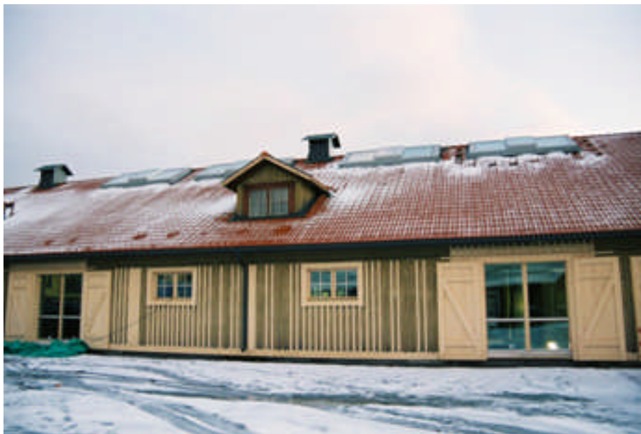
Den västra fasaden (bild nr 07m03/25).
