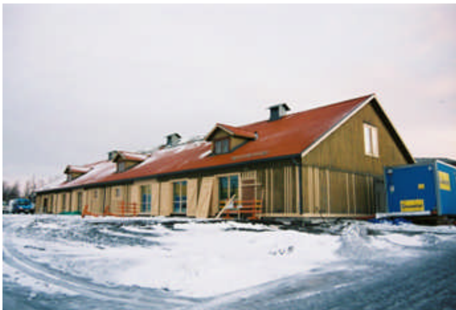
Panelen har delvis lagats (bild nr 07m03/27).
