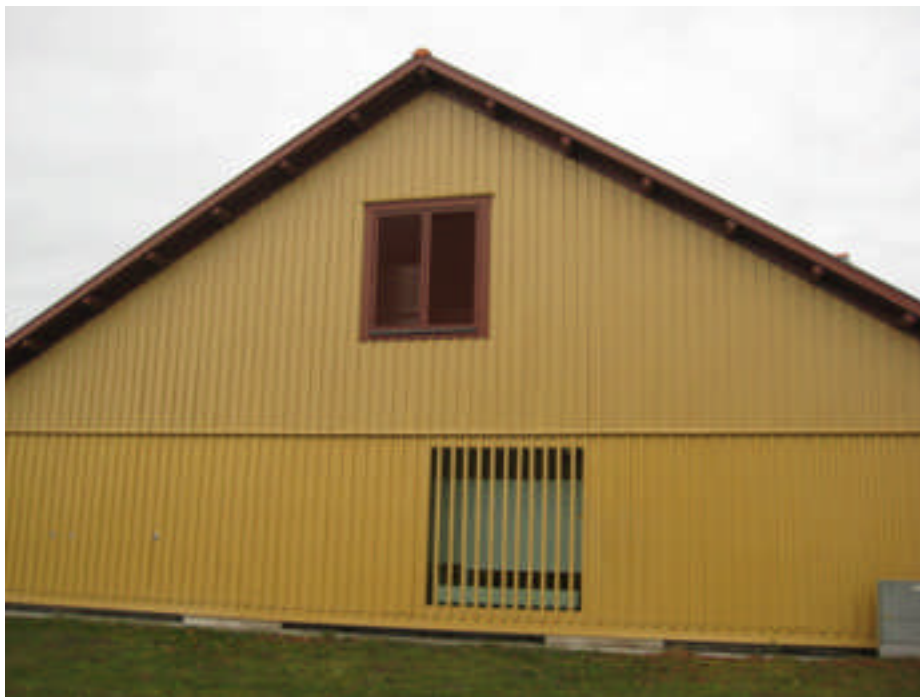
Den södra fasaden efter åtgärd (bild nr 0880).
