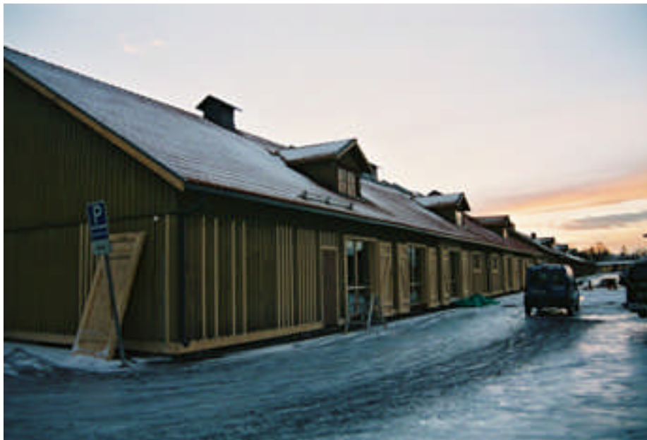
Byggnad 32 under pågående ombyggnad (bild nr 07m03/23).
