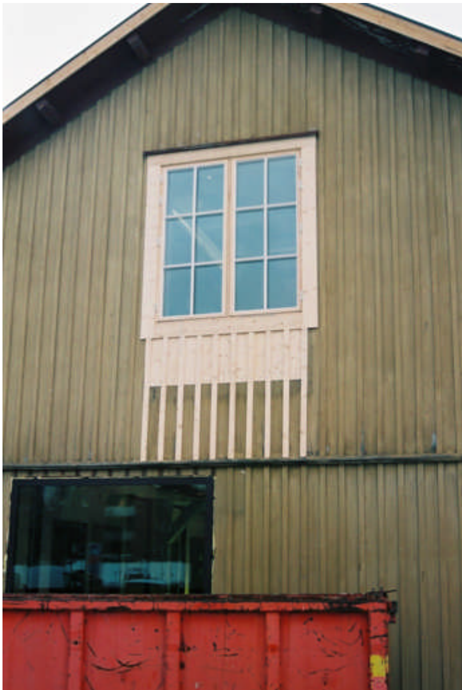
Den norra fasaden med nytillverkat fönster och glasyta som senare täcktes med träribbor som på bilden ovan (bild nr 07m03/22).
