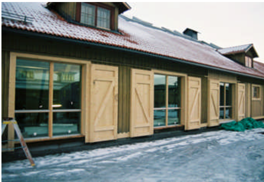
Nya portöppningar med glaspartier på den västra sidan (bild nr 07m03/24).
