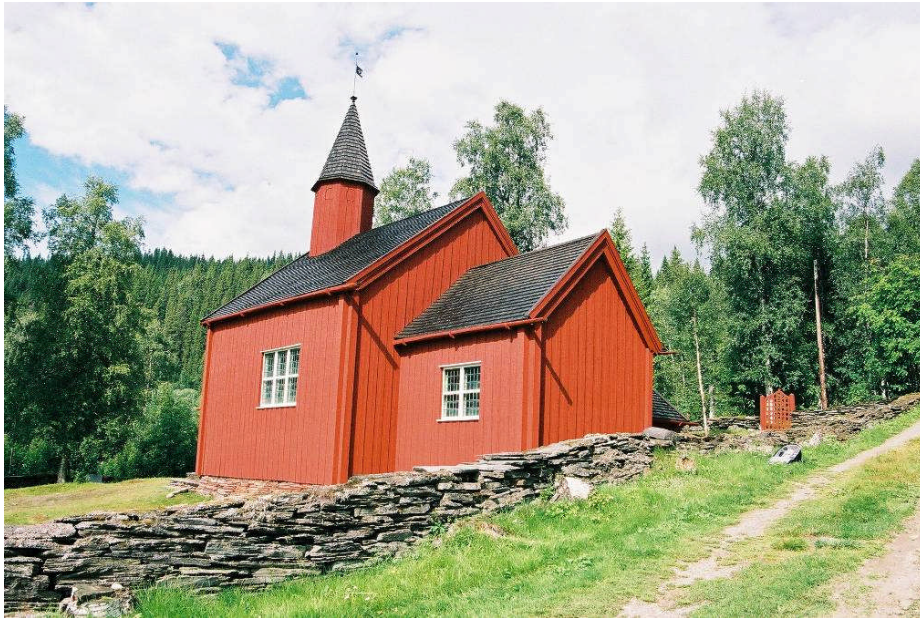
De nya hängrännorna leder bort vattnet längre från fasaden (digital bild nr 2335).
