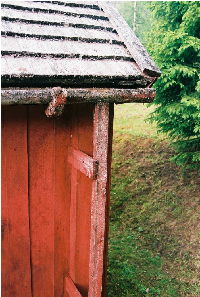
Rötad hängränna och krok vid sakristian (bild nr 08m22/32)-
