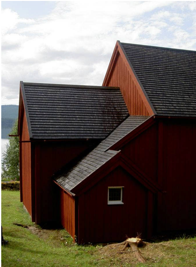
Samma takfall efter restaureringen (digital bild nr 8714).
