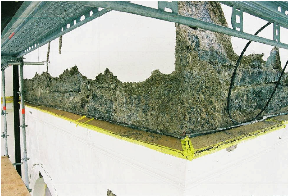
Bild 3. Tornets nordvästra hörn efter att den lösa putsen knackats ner (JLM07M033/18).
