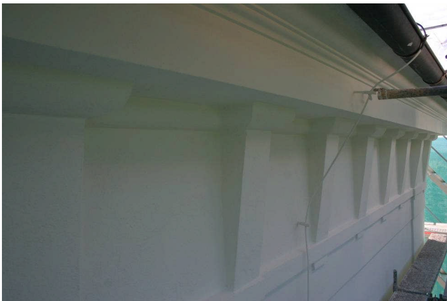
Bild 5. Tandsnittsdekoren efter omputsning och målning (digital bild pict 9800).
