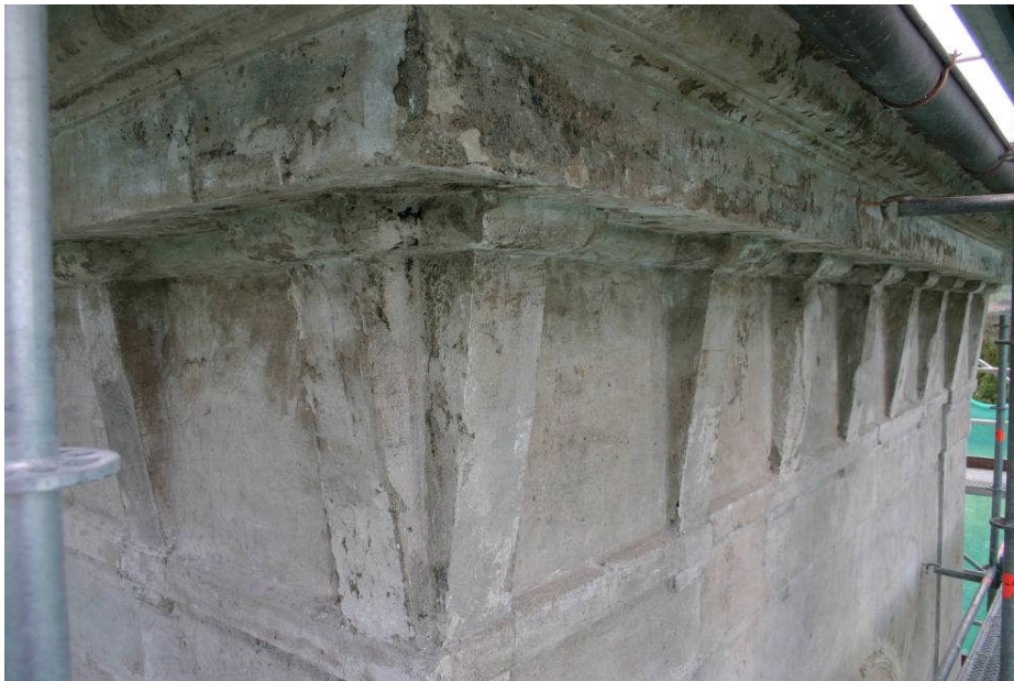
Bild 4. Tornets tandsnittsdekor efter tvätt och innan omputsning och målning (digital bild pict 9576).
