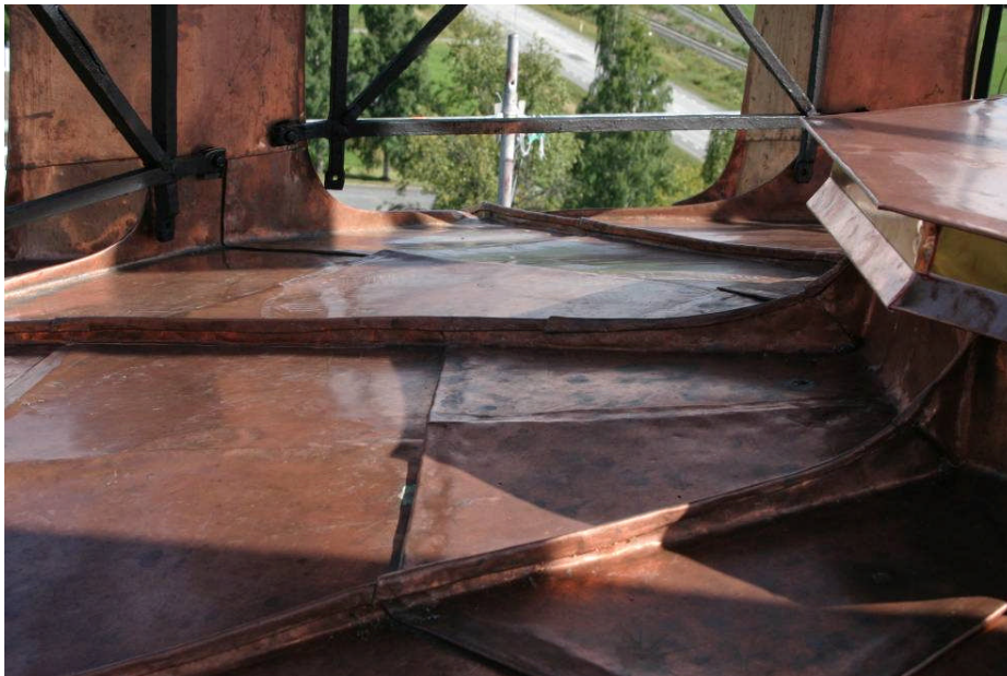
Bild 8. Plåtläggningen på golvet i lanterninen (digital bild pict 9796).
