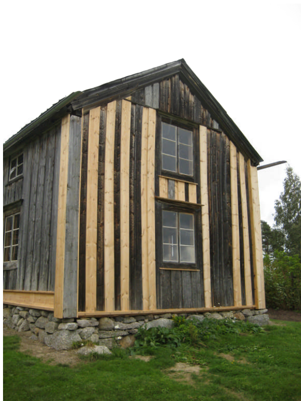
Utbytta panelbrädor på D-vägg
