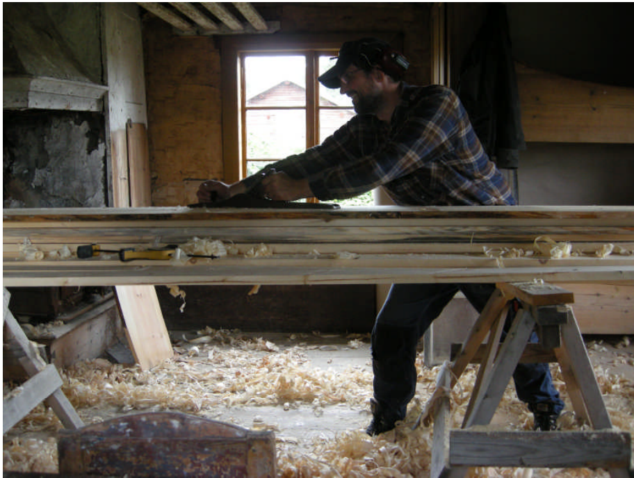
Nya panelbrädor till ytterväggarna hyvlas (Foto Jerker Jamte)
