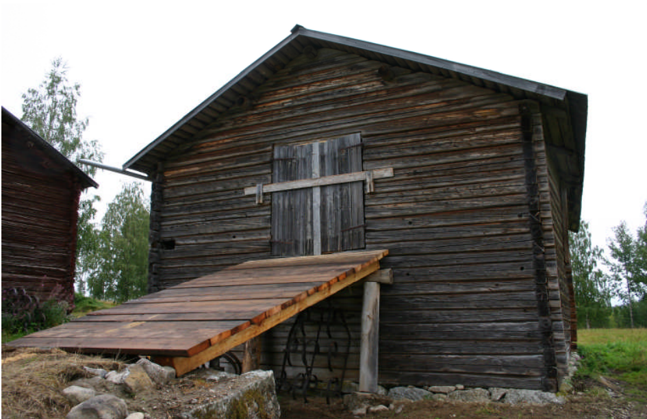
Den färdigställda Gällbron på D-väggen
