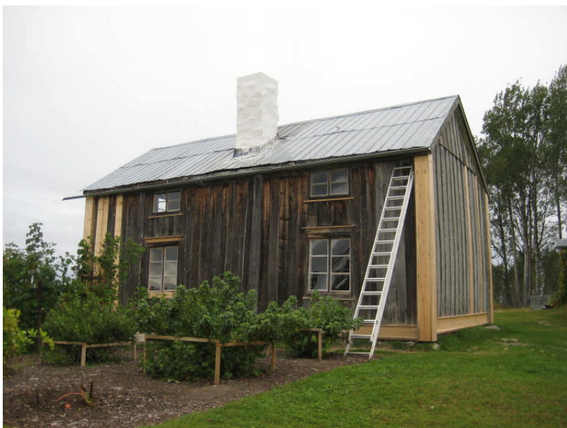
Här syns C-väggen, skorsten är färdigställd och slutligen avfärgad med vit kalkfärg
