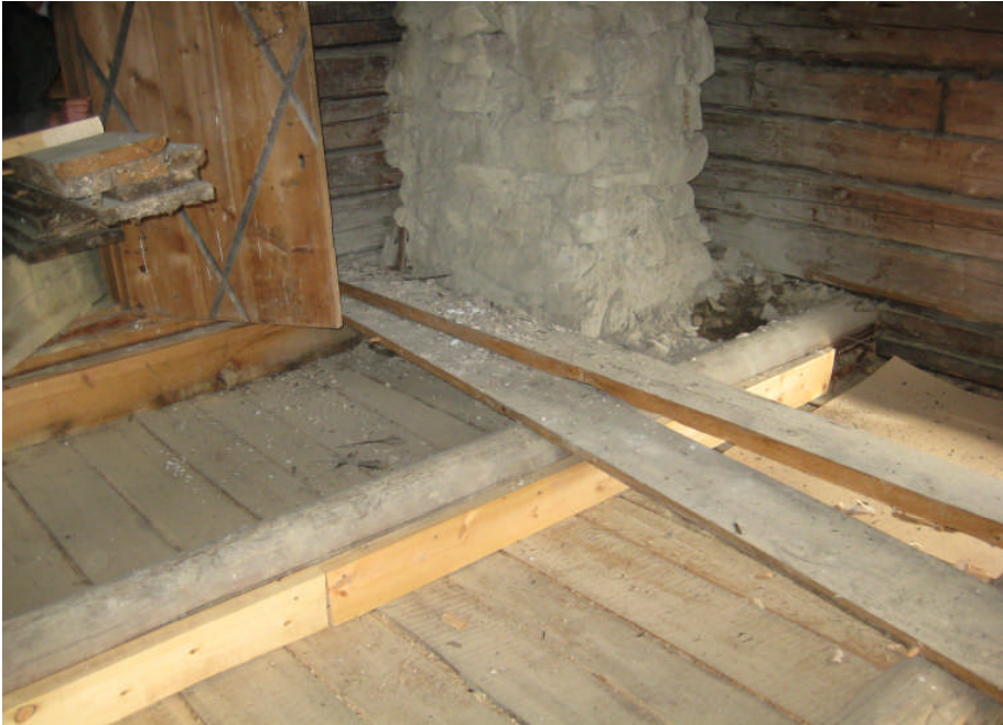
Golv bortplockat på övervåningen, det gamla isolermaterialet av spån, lerklining och löv är bortplockat
