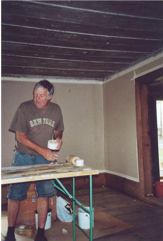
Arbete med pappspänning pågår i köket (Foto Lars Nord)
