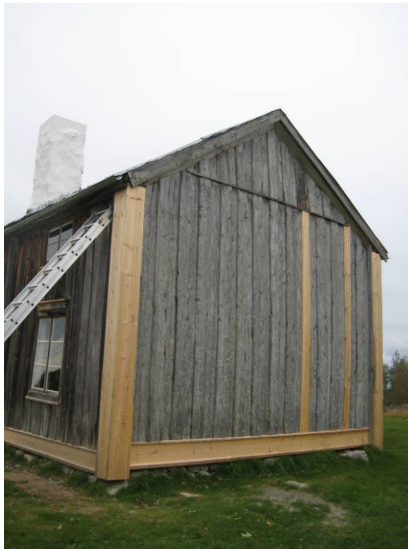
B-väggen, här syns skarvning av panel och den liggande panelbrädan med dropplist och fotlist
