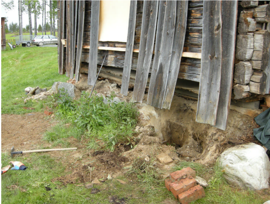
Arbete pågår med att byta ut och skarva stockarna D1 och D2 (Foto Jerker Jamte)
