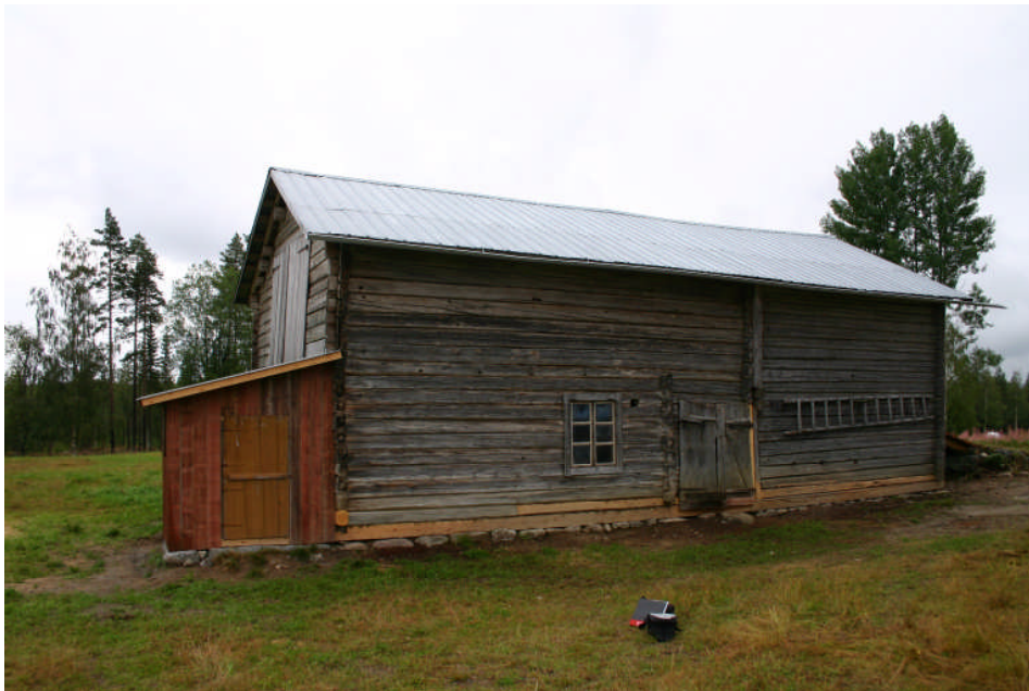
Ladugårdens A-vägg efter genomförd restaurering
