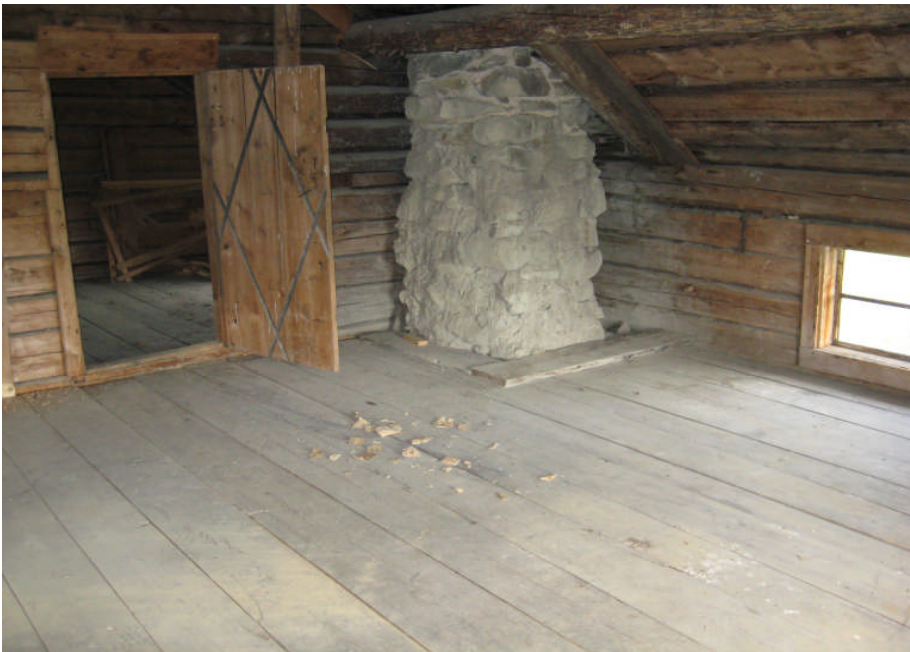
Ny isolerfyllning har lagts i facken, och brädgolvet har återmonterats
