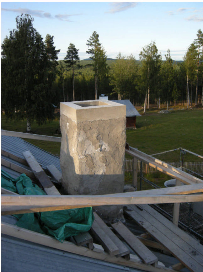
Kronan är gjuten och skorstenen är putsad
