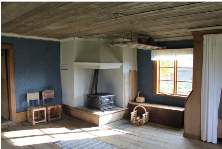
Väggarna i köket har fått sin pappspänning och tapet, spisen är kritad och limfärgsmål原因, taklisten är vitmålad
