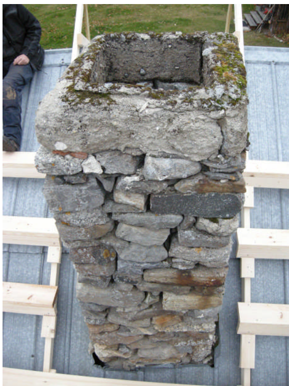
Skorsten innan den plockades ned, högst upp syns den gjutna kronan (Foto: Jerker Jamte)
