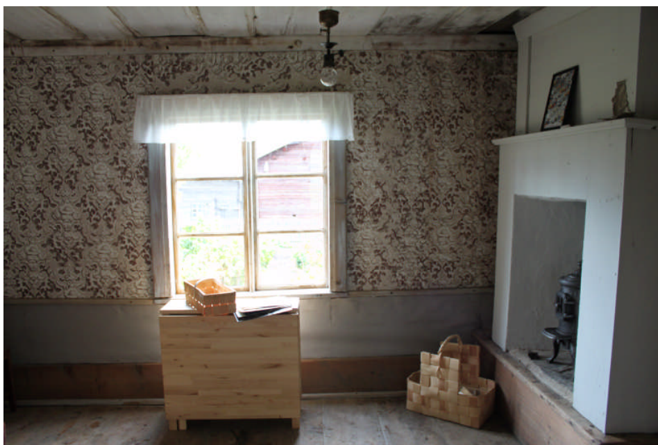
Nytryckta tapeter och lumppapper har klistrats upp på fönsterväggen i kammaren
