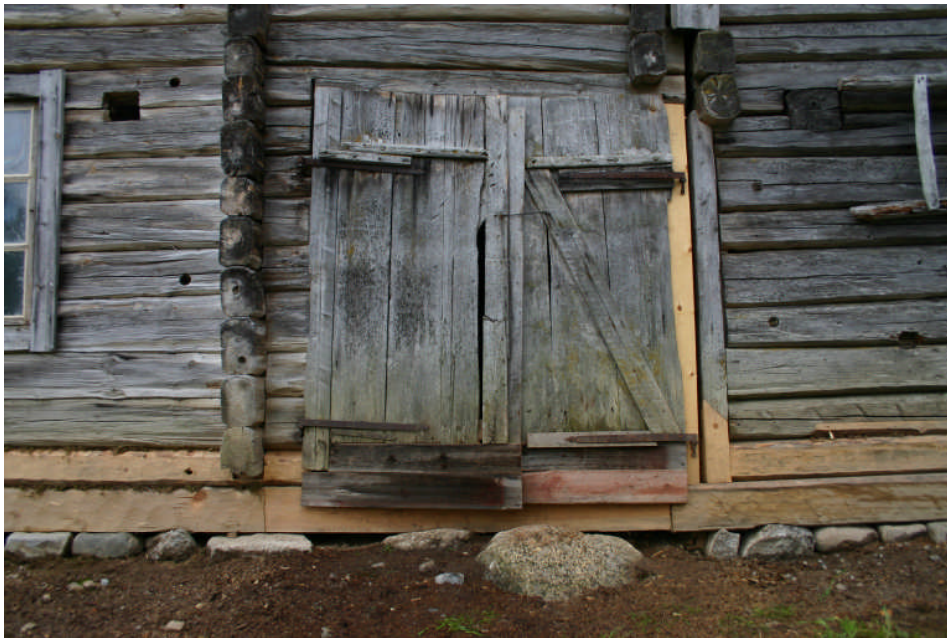
Porten på A-väggen, det högra dörrbladet är fäst i den nya gåten
