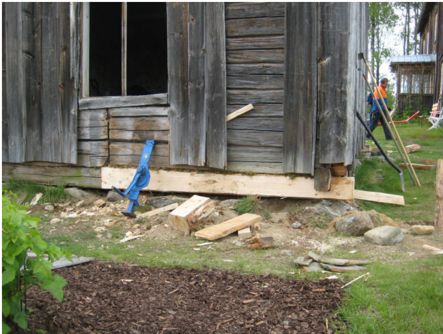
Skarvning av C1 vid CD-knut
