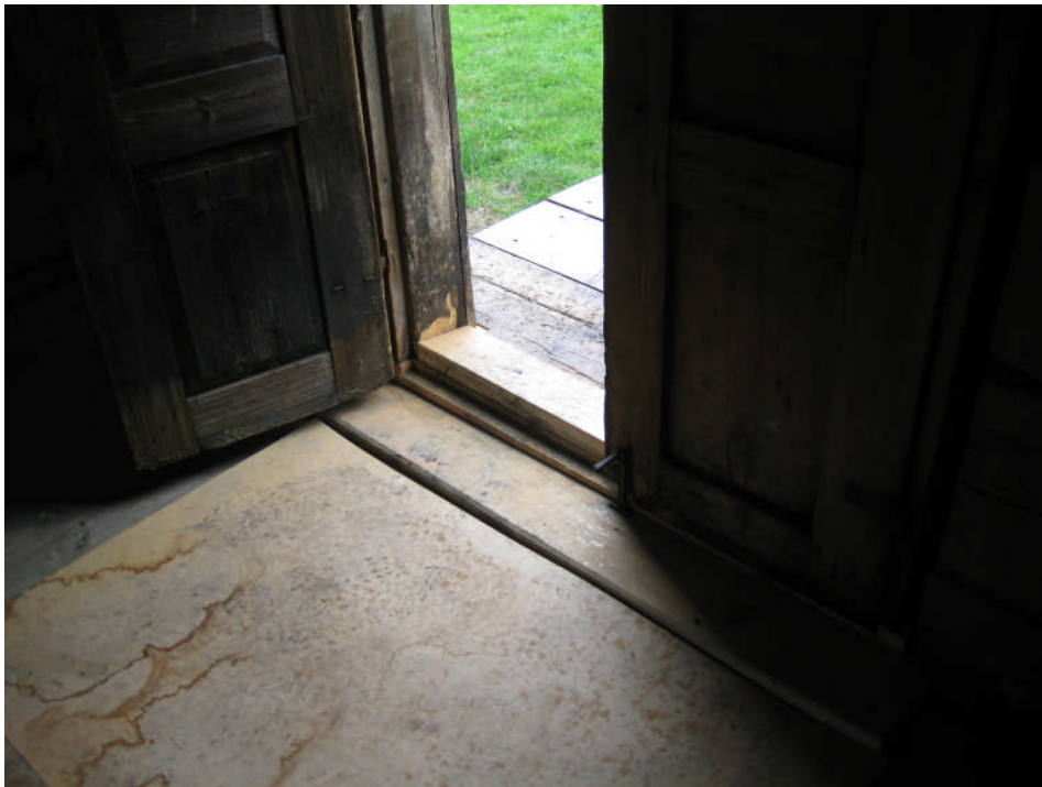
Ny tröskel på A-vägg
