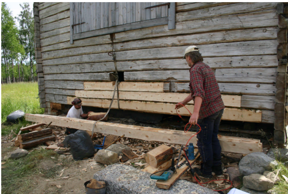
Under pågående arbete med att byta stockar på B-vägg
