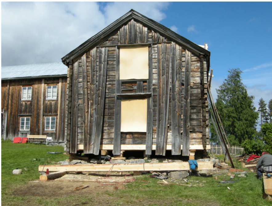
Panel i dåligt skick har plockats ned. Stocken D2 har timrats in och arbeten pågår med D1 (Foto Jerker Jamte)
