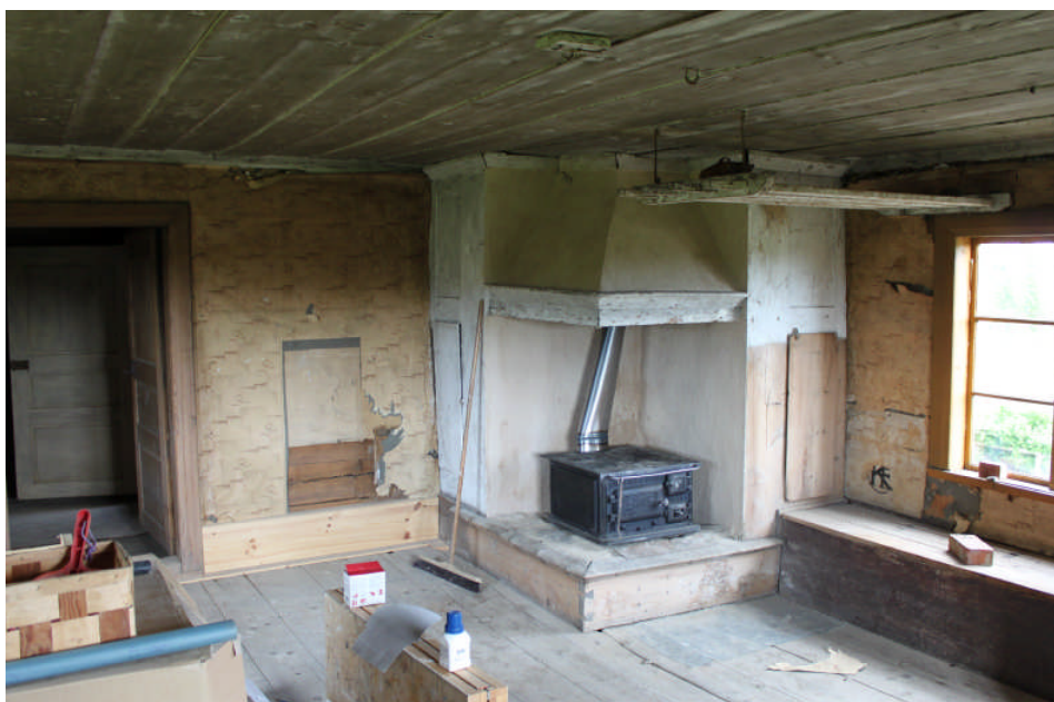
Järnspisen i köket har fått rökrör och har putsats med lerputs, nu väntar kritning och limfärgsmålning
