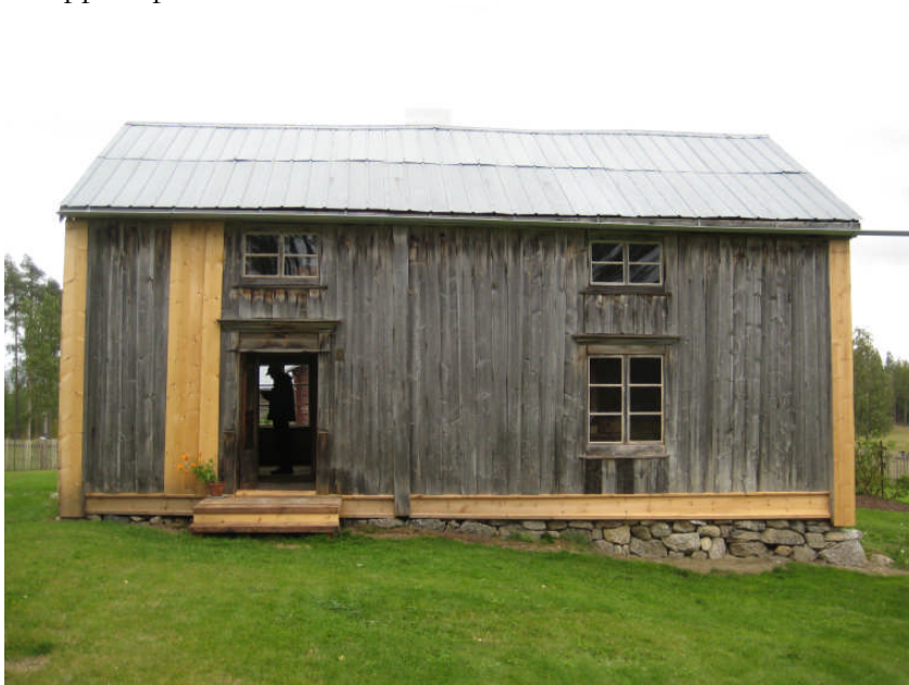
A-vägg, födorådsstugan efter genomförd restaurering
