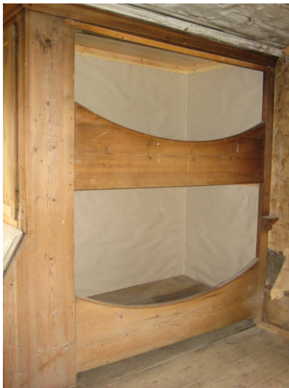
Här syns ny väggpapp och utbytta brädor i övre sängens tak
