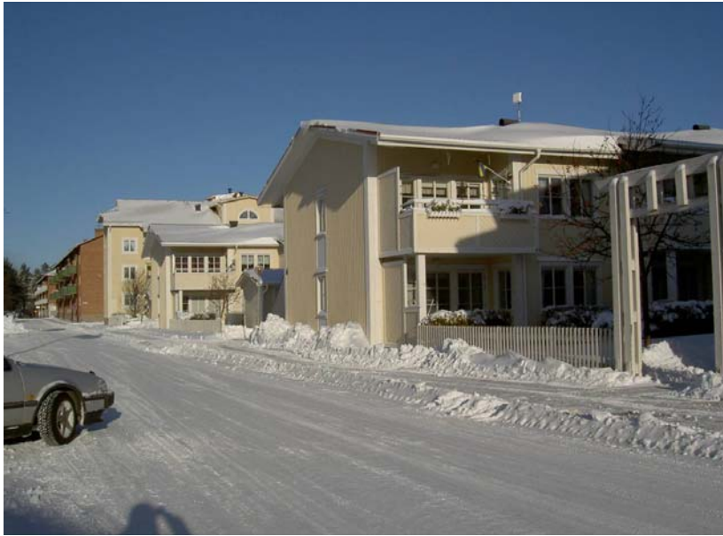
Kvarteret Hammaren, Dalagatan i Sveg, flerbostadsområde med innergårdar.
