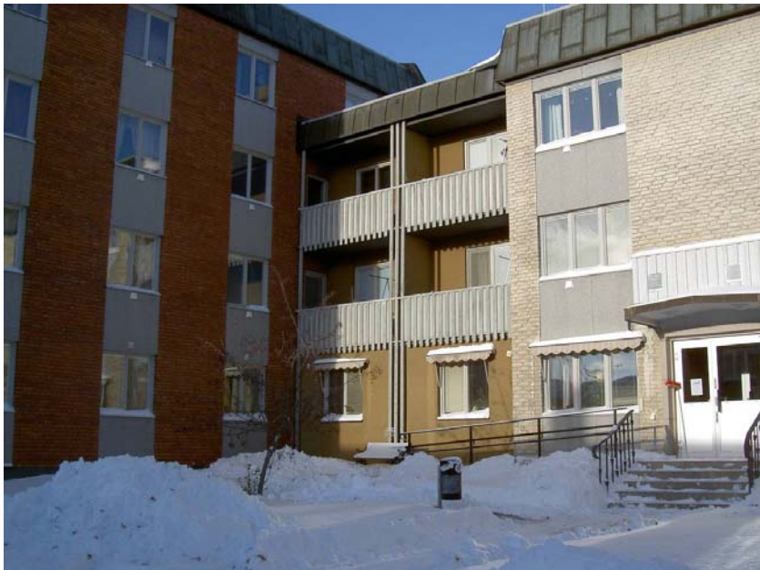
Det gamla kommunkontoret i Sveg i kvarteret Läraren. Fasaden mot Härjedalsgatan.
