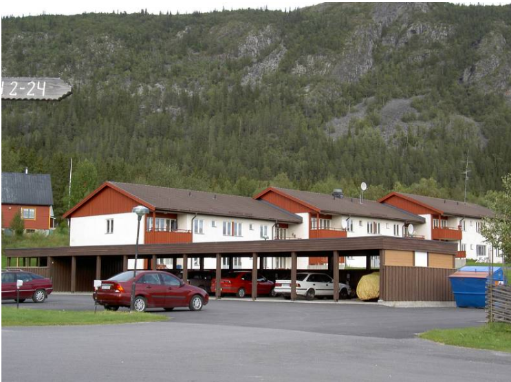
Funäsdalen, tre hopbyggda flerfamiljshus. Två exempel på hur funktionalismens idéer har fortlevt – enhetlighet och upprepning.
