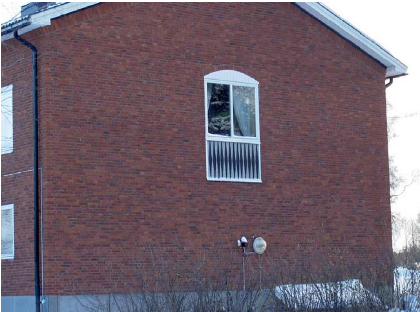
Detalj av tegelfasad med accentuerat gavelfönster med dekorativt segmentformat överstycke och grafiskt utformat parti under fönstret, kommunkontoret i Ytterhogdal.
