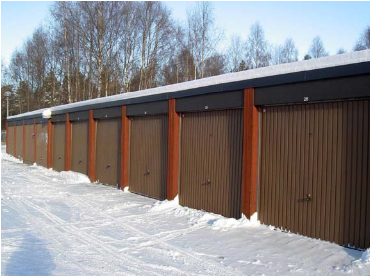
Garagelänga, kvarteret Mosippan, Sveg.
