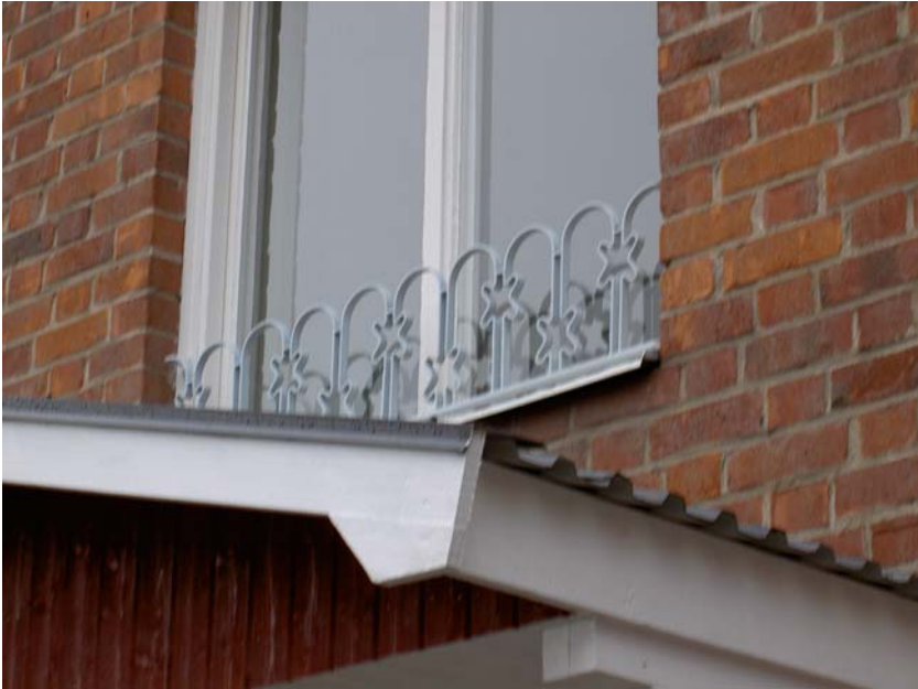
Dekorativt utformat räcke framför trapphusets fönster.
