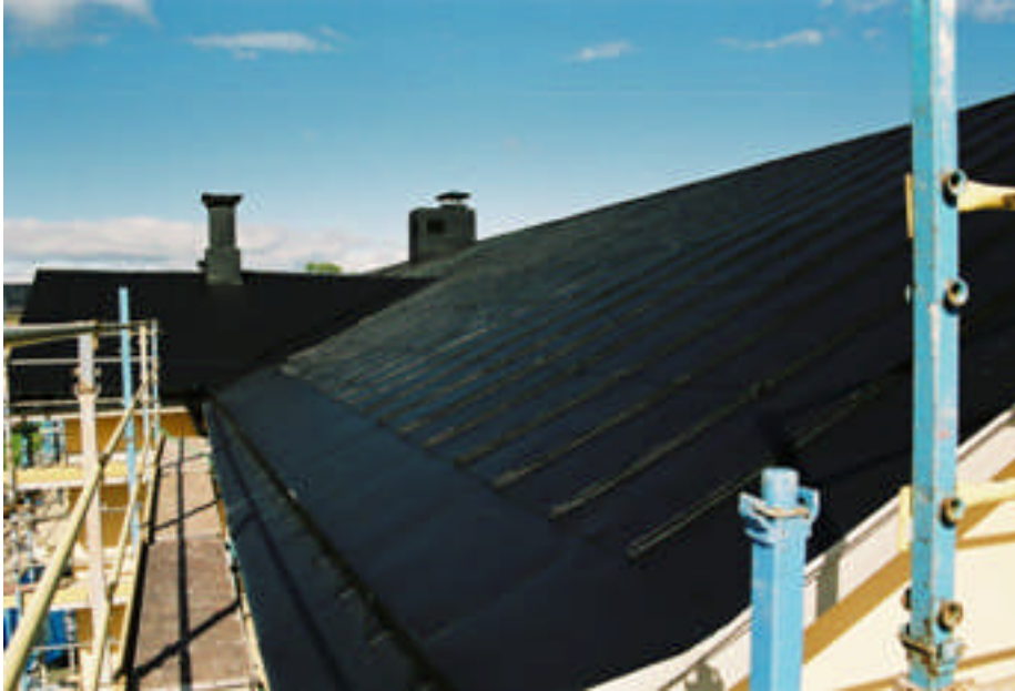
Plåttaket målades i en svart kulör (bild nr 05m081/04).
