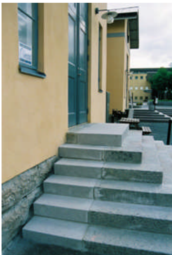
Nya granitblock närmast väggen kompletterar de gamla (bild nr 05m140/22).
