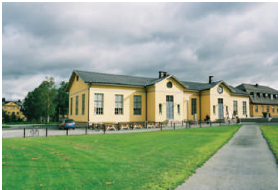
Byggnad 19 sedd från söder, efter restaurering (bild nr 05m076/37).
