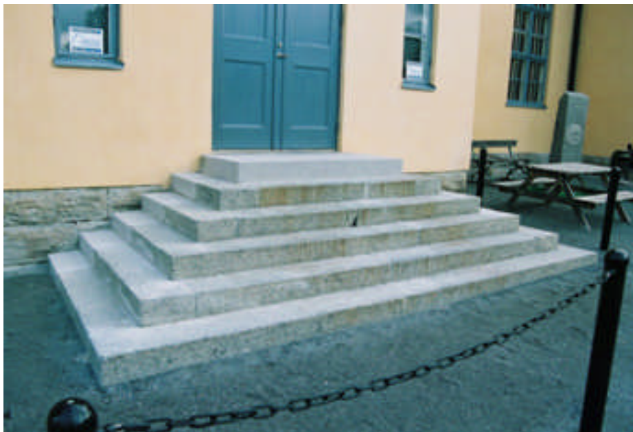
Trappan mot söder efter åtgärd (bild nr 05m140/19).
