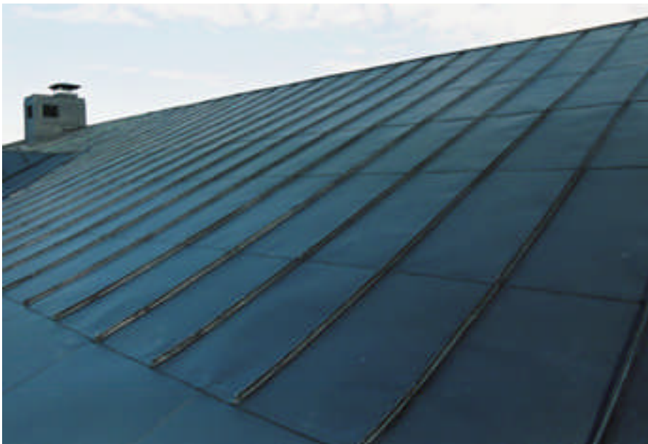
Det nymålade plåttaket (bild nr 05m081/04).
