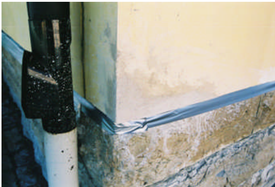
Ett skadat hörn har ilagats med kalkbruk (bild nr 05m081/16).
