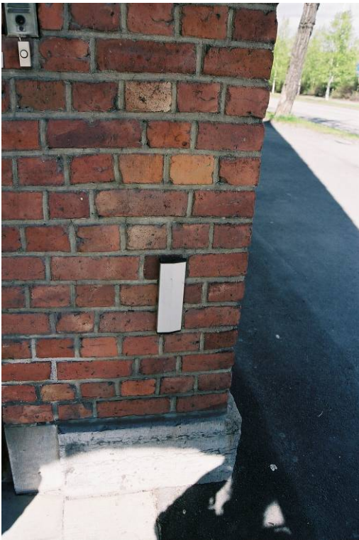
Tryckplattorna för dörröppning, utvändig respektive invändig. Jlm 05m71/19 & 17.
