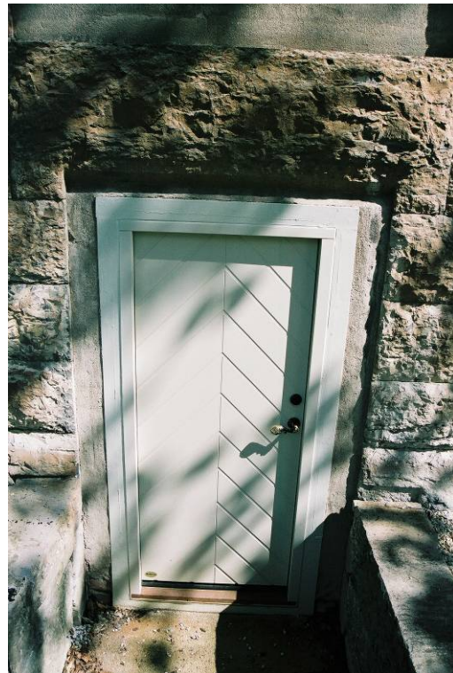
Den tidigare källardörren av stål och den nya trädörren med fiskbensmönster. Jlm 03m212/9 & 05m71/21.
