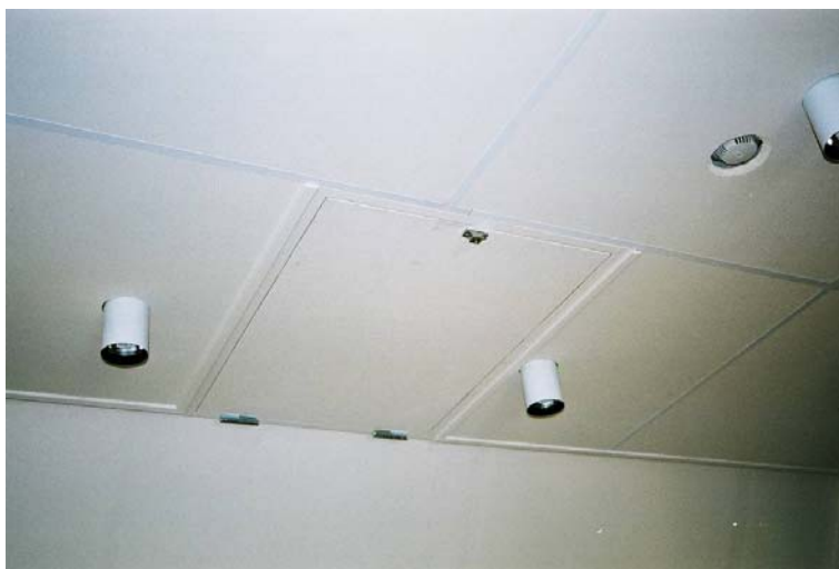
Inspektionsluckan täcks av en absorbentplatta. Jlm 07m18/20
