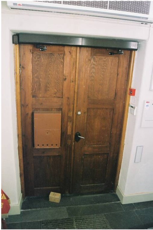
Dörröppnarna har monterats över pardörrarna Jlm 05m71/14
