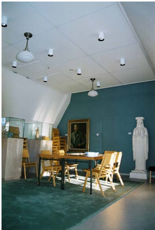
Taket efter utförda åtgärder. Absorbent- plattorna och de nya armaturerna har monterats. Jlm 07m18/16
