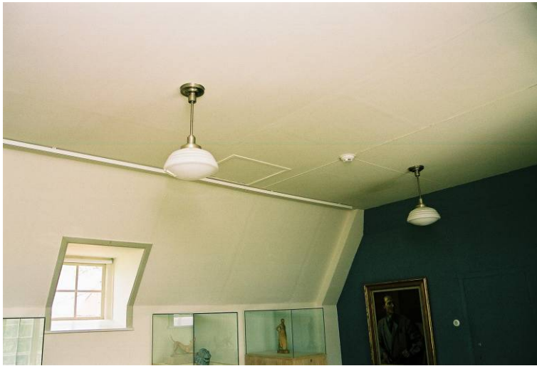
Taket på ”loftet” 401 före åtgärder. Jlm 05m71/9
