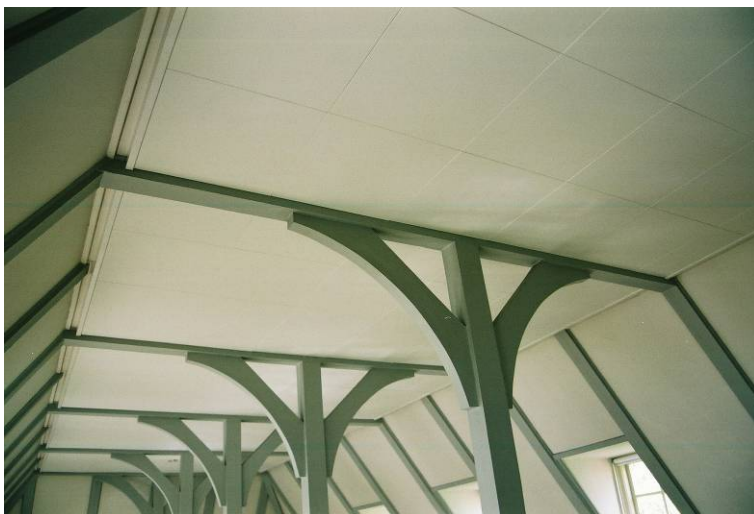
Takabsorbentplattorna har monterats på de vågräta takpartierna mellan bjälkarna. Jlm 05m71/7
