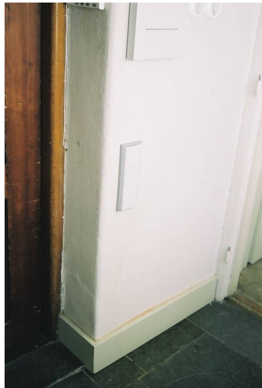
Tryckplattorna för dörröppning, utvändig respektive invändig. Jlm 05m71/19 & 17.
