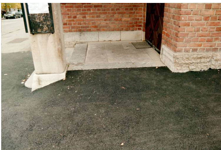
Entrén efter åtgärder. Trottoarens asfaltsnivå längs Rådhusgatan har höjts så att den är i samma nivå som trappans broplan. Jlm 03m210/29 & 31
