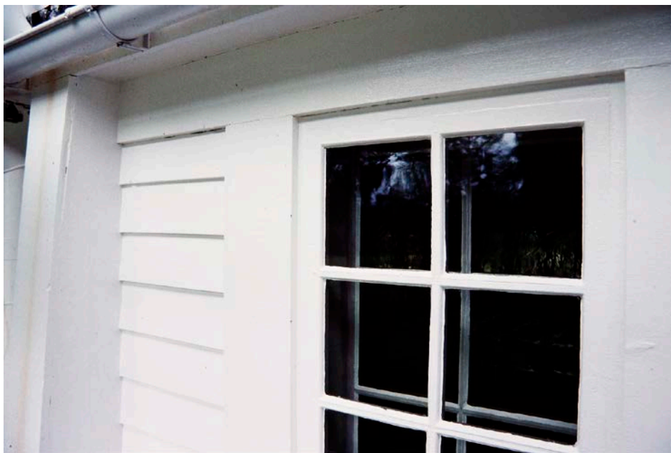
Figur 4 Fönster efter målning.
