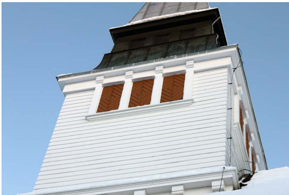
Figur 5 Tornluckorna efter målning.
