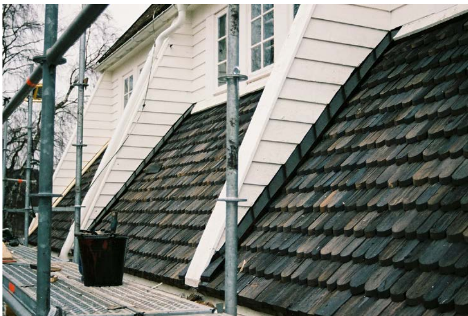
Figur 7 Södra takfallet efter läggning av nytt spåntak.
