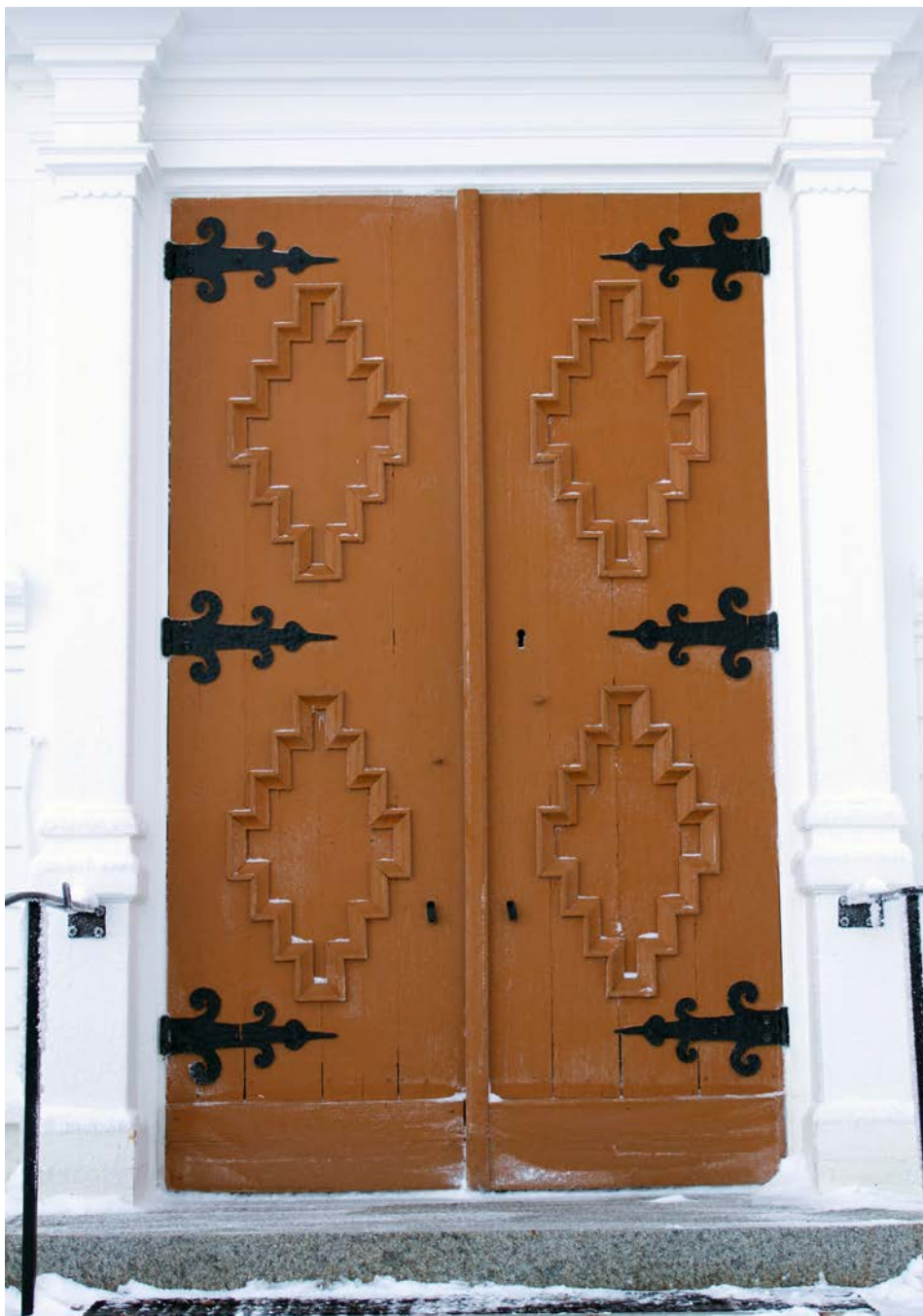
Figur 3 Dörrarna har målats med linoljefärg i obruten gulbrun kulör (gulockra), lika underliggande ursprunglig kulör. Bilden visar Huvudentrén åt väster.
