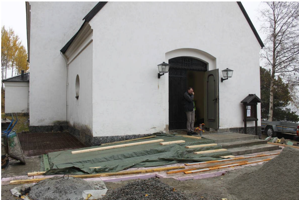
Bild 26: Fundamentet till den nya rampen och trappan har gjutits
