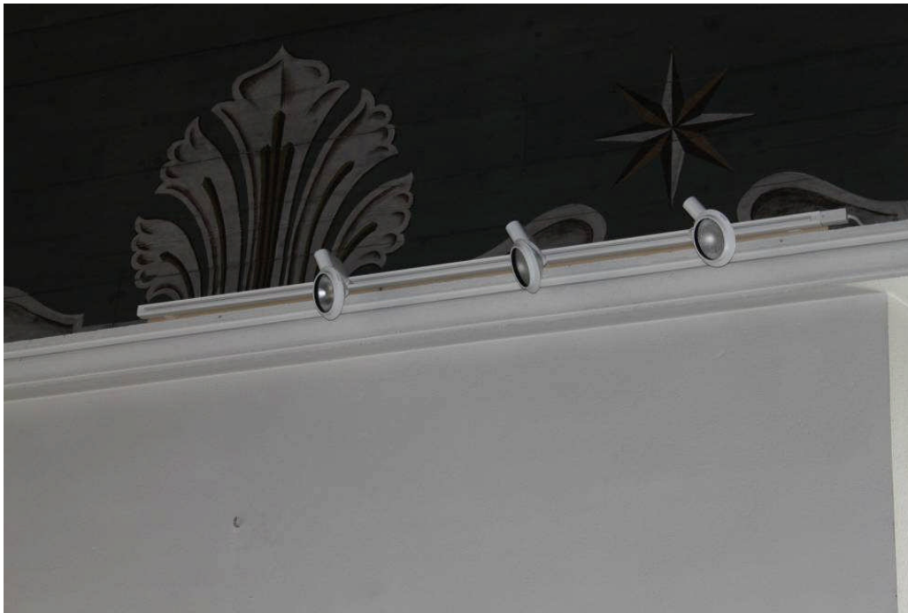
Bild 30: En av de ljusramper som monterats i långhuset. Trälisten som skenan var monterad på skulle, enligt protokoll från efterbesiktning 2010-10-03, målas i vit kulör senast 2011-11-24
