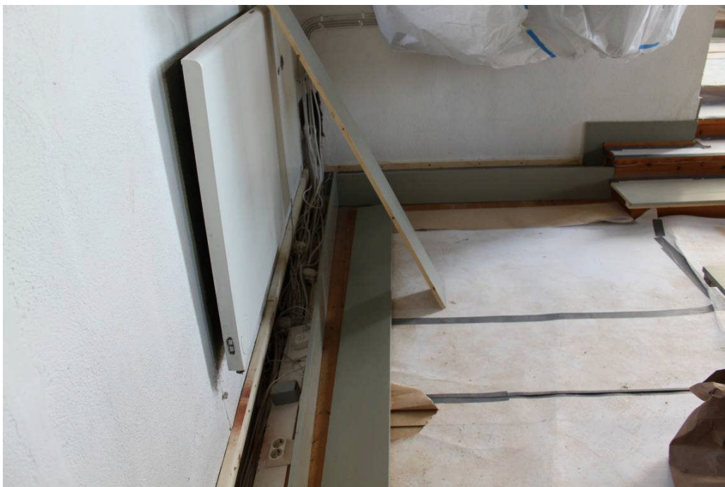
Bild 7: Arbete med den nya sockellådan pågår, nordöstra hörnet i långhuset
