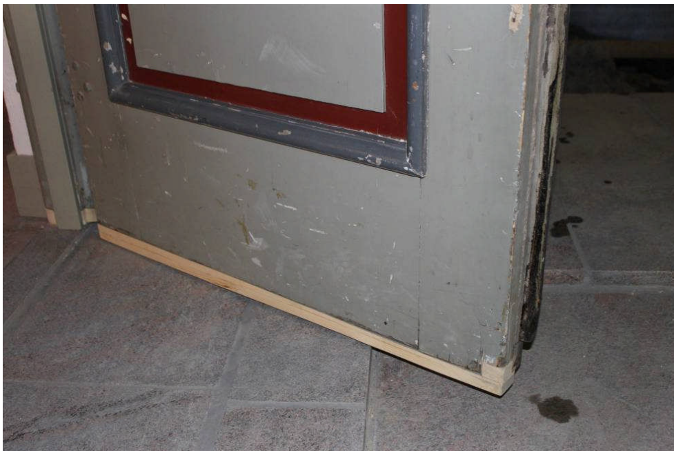
Bild 21: Entré dörren in till vapenhuset har byggts på i underkant efter det att den äldre högre tröskeln tagits bort
