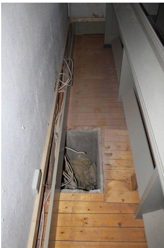
Bild 5, övre bilden: Här ser man den äldre sockellådan och där elledningarna till de äldre bänkvärmarna löper över sockellådan och in under bänken
