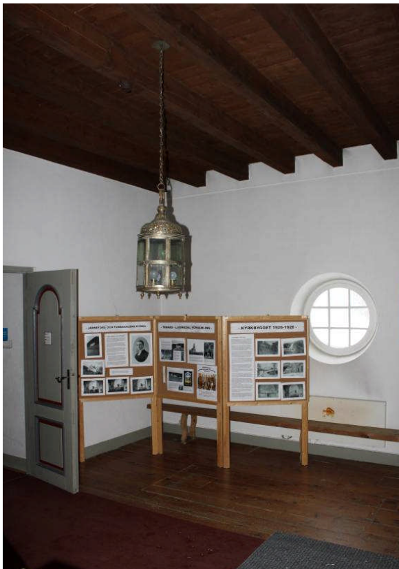
Bild 17: Vapenhuset före det att den nya toaletten byggs och före det att det äldre trägolvet bryts upp inför att bjälklaget ska förstärkas
