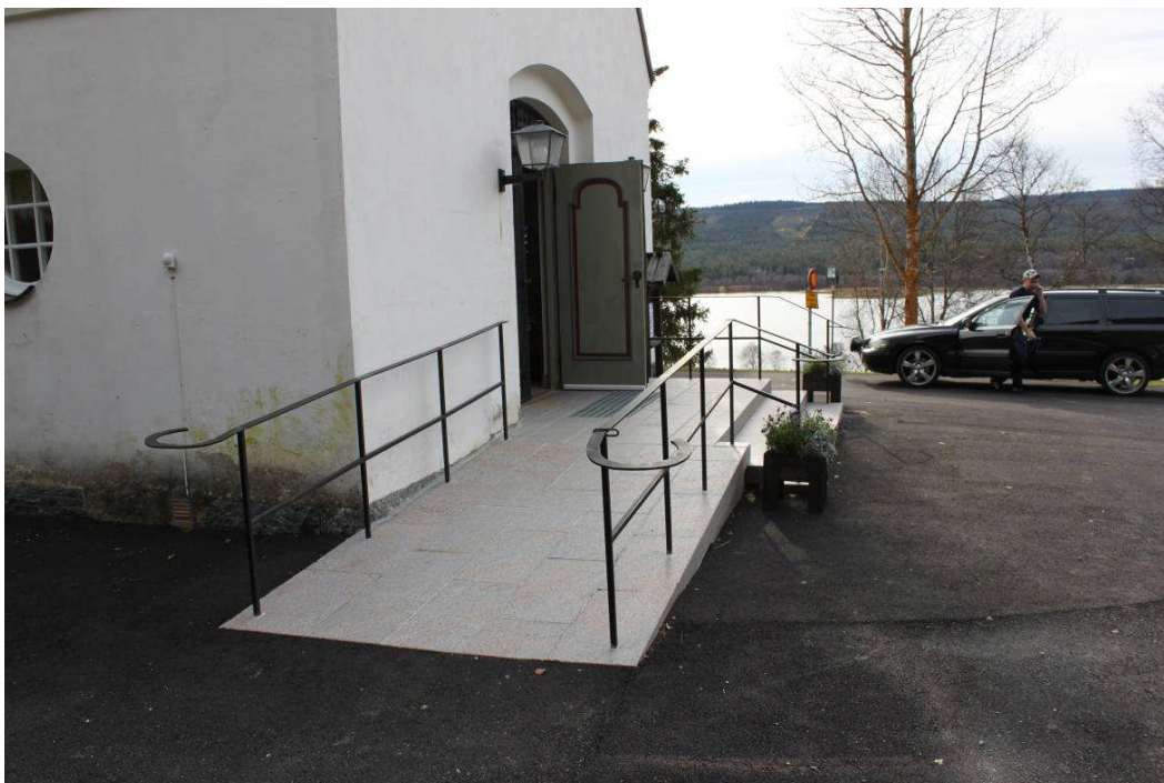
Bild 29: Rampen med räcken i smidesjärn
