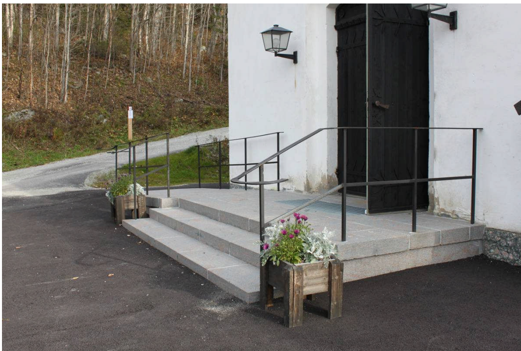
Bild 28: Den nya rampen och trappan är belagd med gnejs från Båarp i Halland
