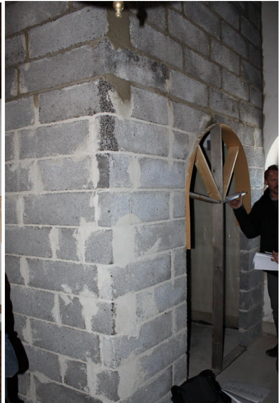
Bild 18: Vaggarna till den nya toaletten muras upp
