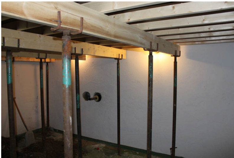
Bild 13: Bilden är tagen i källaren, arbete med förstärkningen av golvbjälklaget upp till vapenhuset pågår
