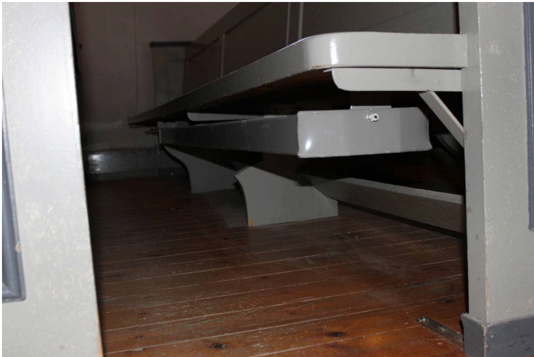
Bild 4: De nya konvektorerna har monterats, på fabrik har de blivit inmålade i samma kulör som bänkarna
