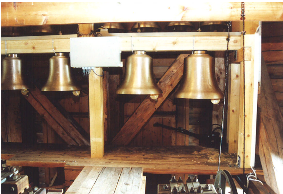
Bild 6. Den sekundära regelstommen, upphängningsanordningen, för klockspelet monterades fast med vinkeljärn. Foto 03m82/2
