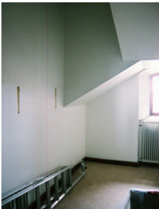
Bild 1: Utrymmet för kapprummet och toaletten.
