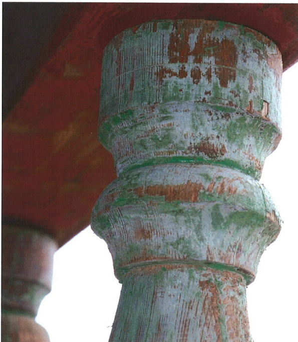
Lös färg bortskrapad av målare på balusterdocka, sydsida, insida.
